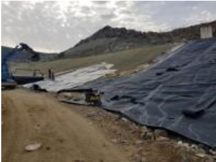
Εικόνα 7.35 Τοποθέτηση γεωφάσματος σε Χ.Υ.Τ.Α Μυκόνου (πηγή: https://www.epoli.gr/topothesisi-membranwn-ston-xyta-mykonoy-a-106306.html?category_id=51 )
