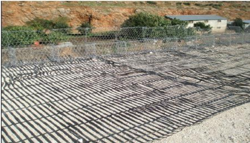
Εικόνα 5.26 Τοποθέτηση οπλισμένης γης
