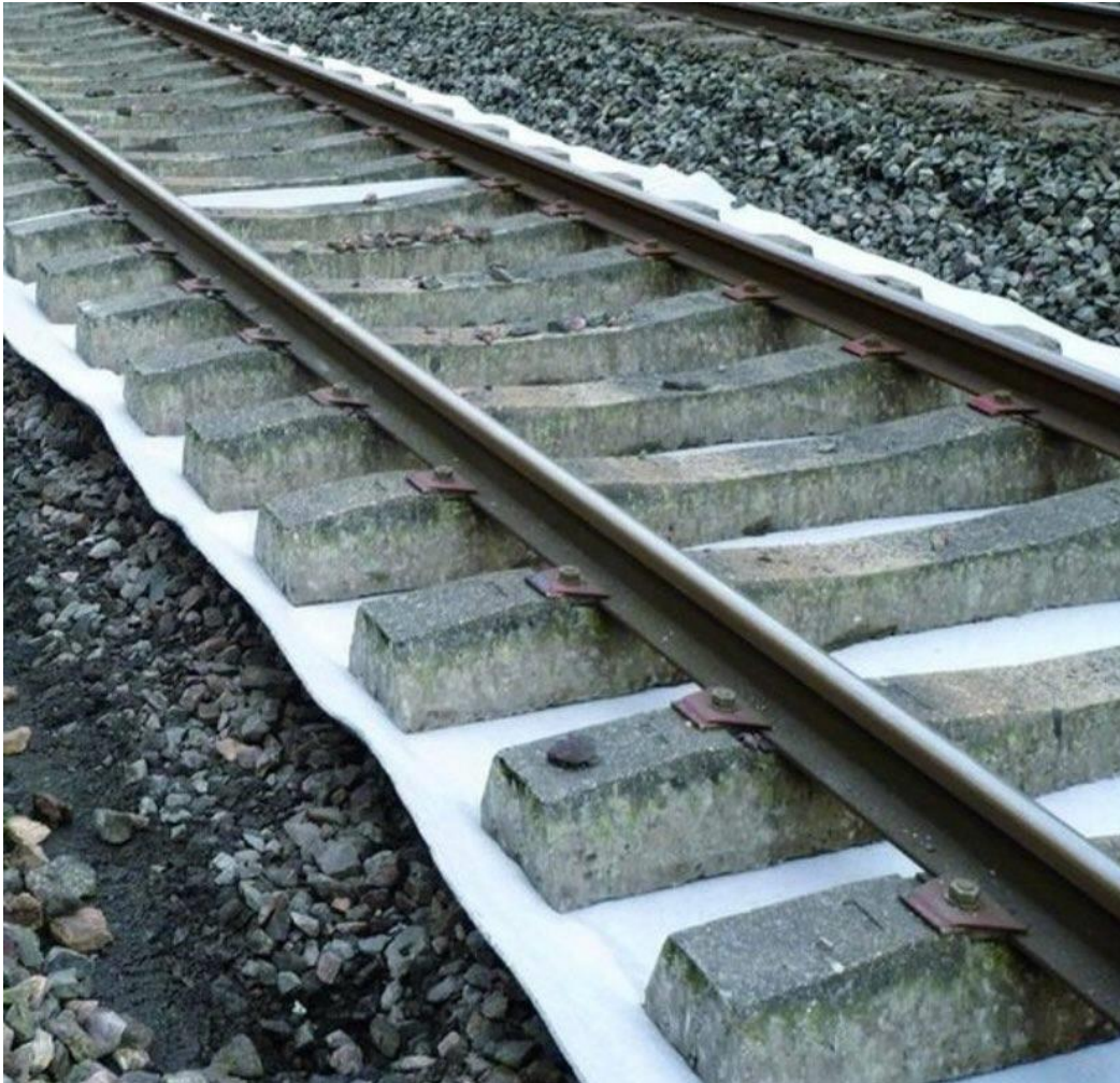
Εικόνα 7.32 Χρήση γεωφάσματος σε σιδηροδρομικά έργα
