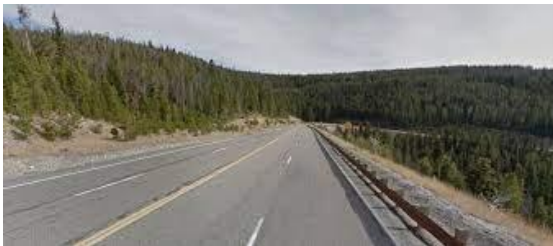
Εικόνα 7.46 Ο Salmon-Lost Trail Pass Highway
