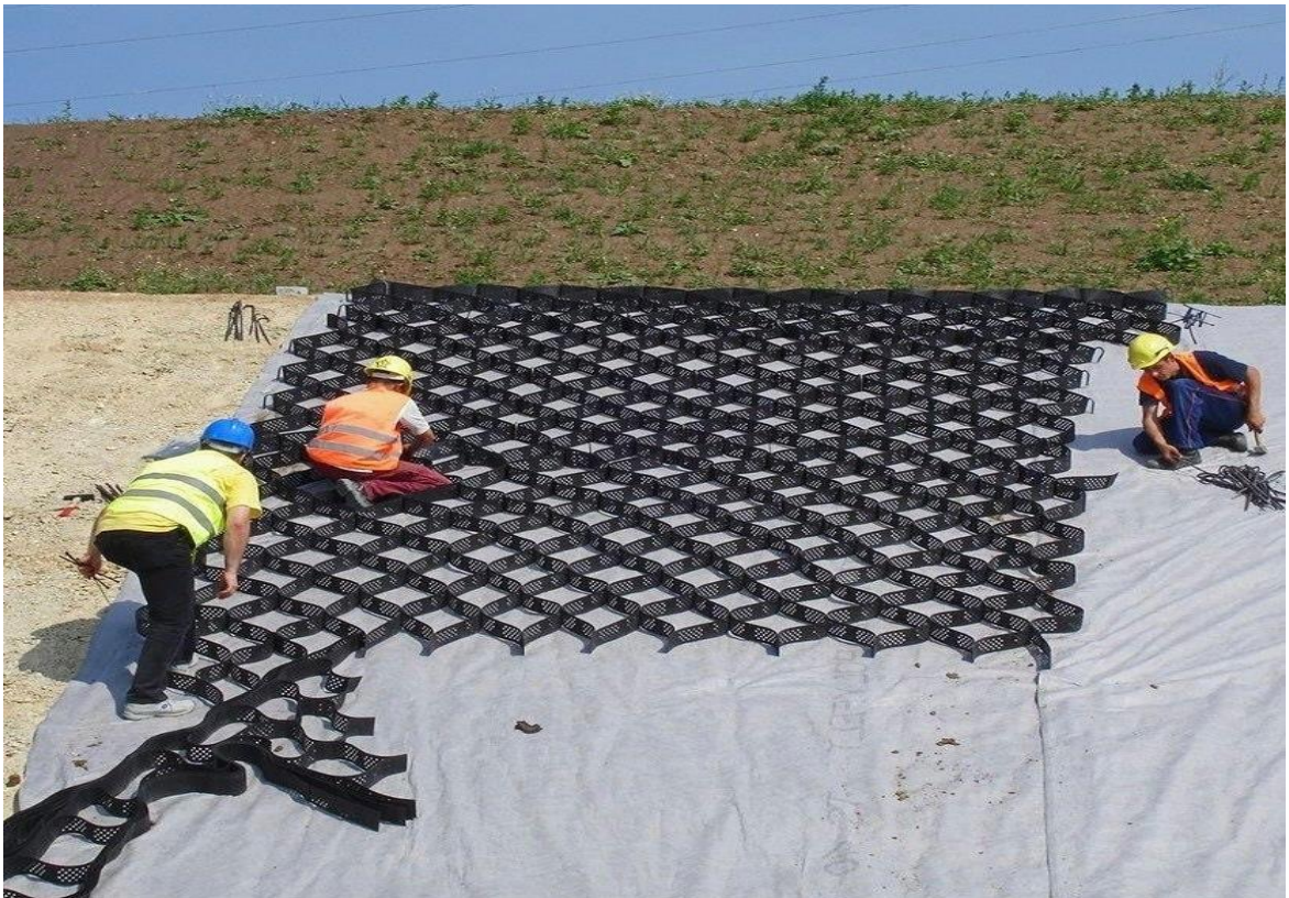
Εικόνα 2.13 Χρήση γεωκυψελών σε επίχωμα
