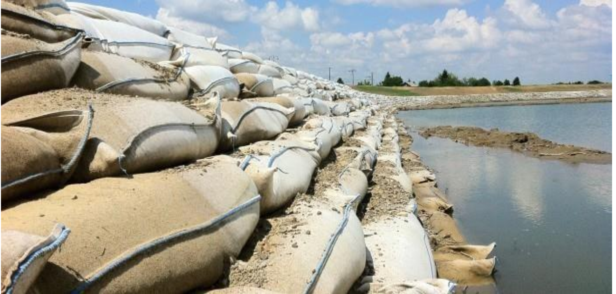
Εικόνα 2.12 Χρήση γεώσακων για την αποφυγή διάβρωσης
