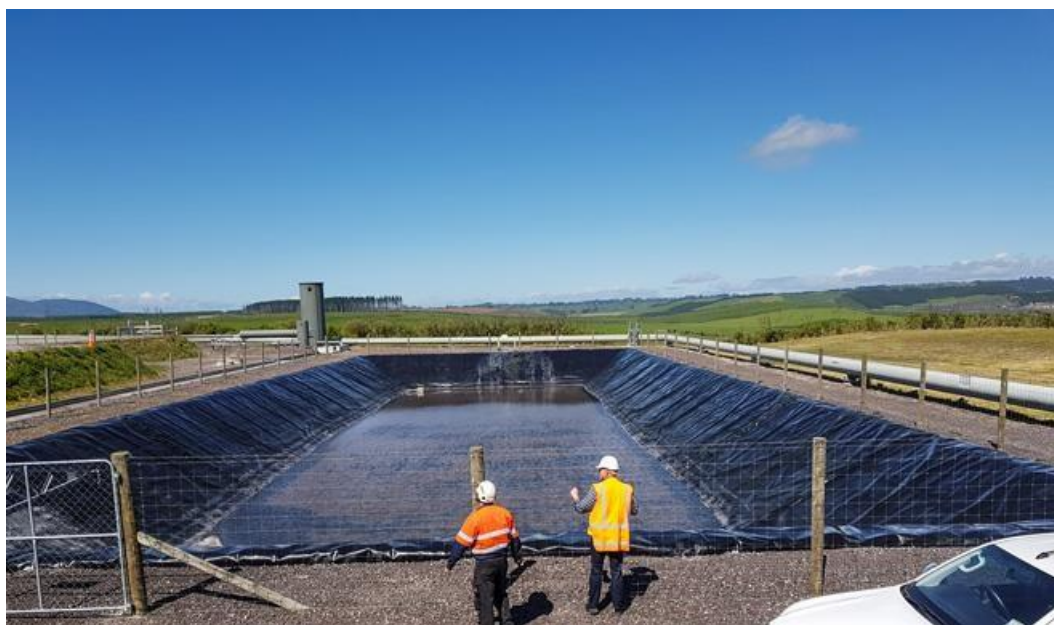
Εικόνα 2.6 Τοποθέτηση γεωμεμβράνης σε έργο στην Ολλανδία
