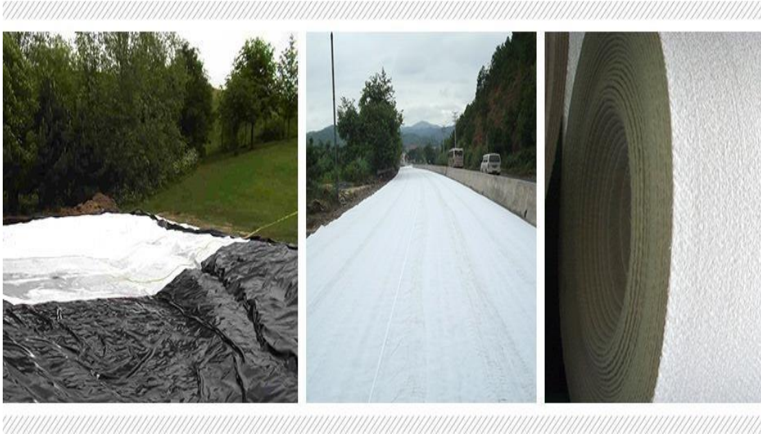
Εικόνα 2.2 Διάστρωση γεωφάσματος σε αυτοκινητόδρομο
