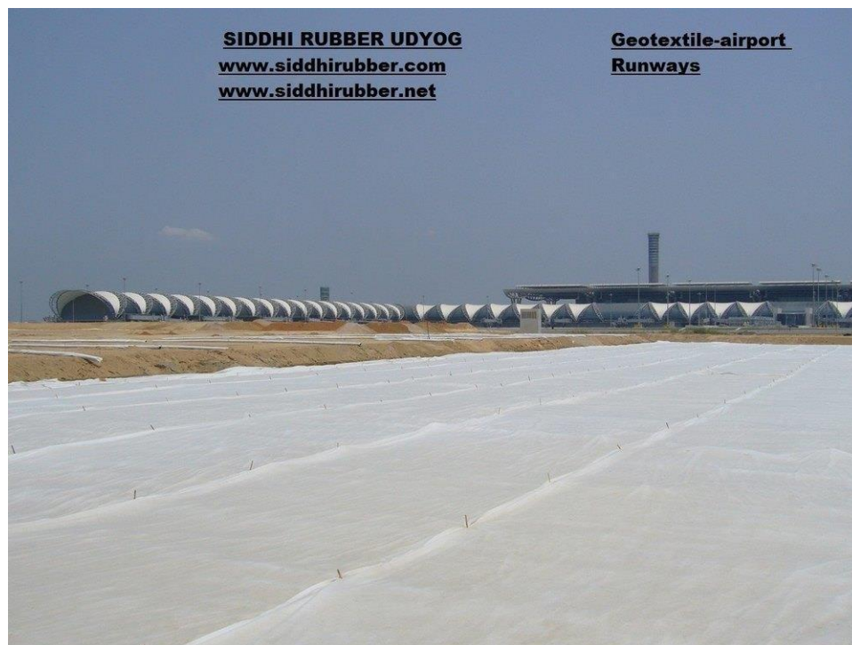
Εικόνα 7.44 Μέρος κατά τη διάρκεια της διάστρωσης των γεωφασμάτων στο αεροδρόμιο της Κίνας
