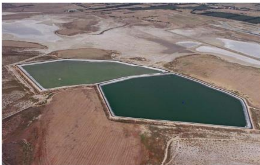
Εικόνα 10: Δεξαμενές αποθήκευσης επεξεργασμένων αποβλήτων
