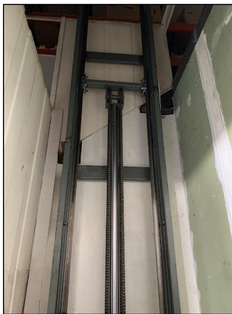
Εικόνα 5.8 – Αναβατήριο εμπορευμάτων
