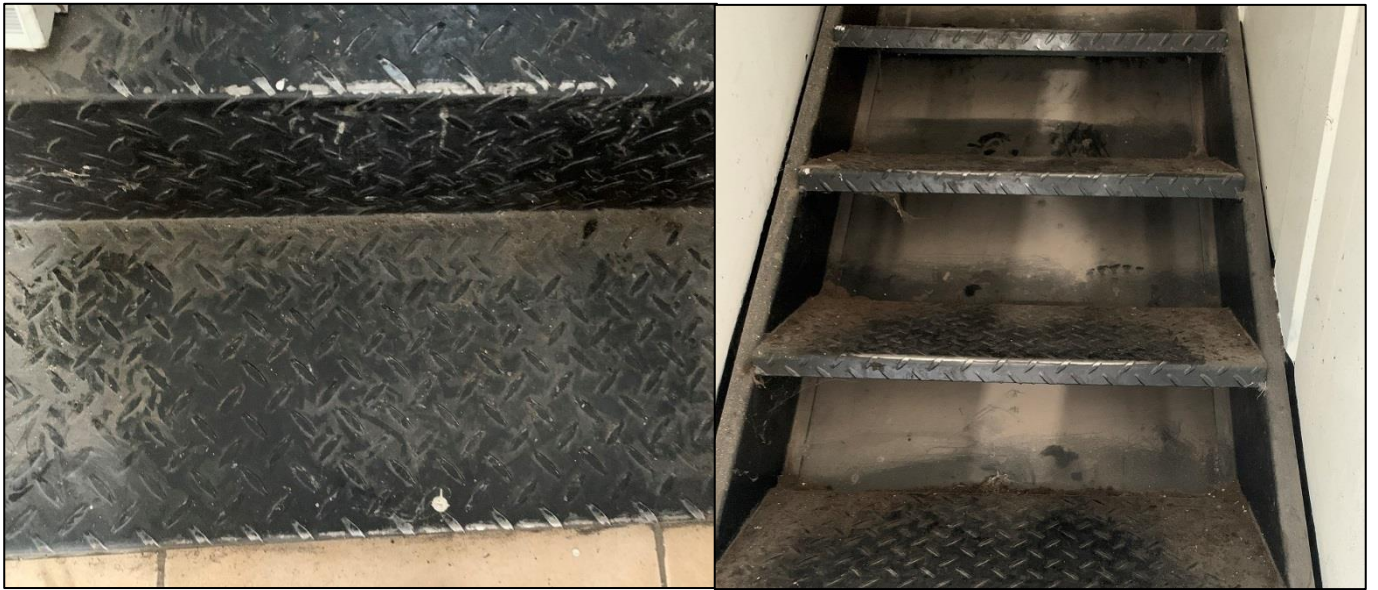
Εικόνα 5.6 – Σκαλοπάτια που οδηγούν στο πατάρι, χωρίς αντιολισθητική ταινία
