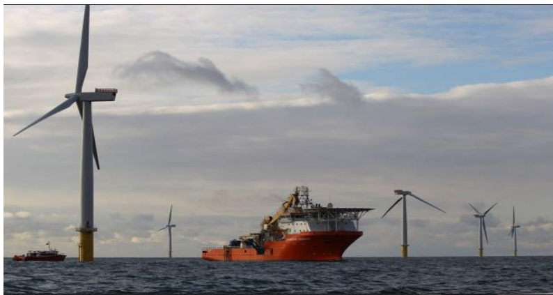
Εικόνα 6.2: Κατασκευή θαλάσσιου αιολικού πάρκου
