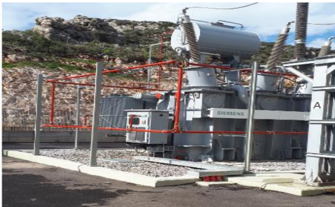
Εικόνα 8.8: Υποσταθμός στην Σκαλαβούνα Λακωνίας για την διασύνδεση Κρήτης Πελοποννήσου
