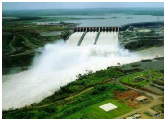
Εικόνα 9.5: Φράγμα Υδροηλεκτρικού σταθμού στο <<Parana River>>
