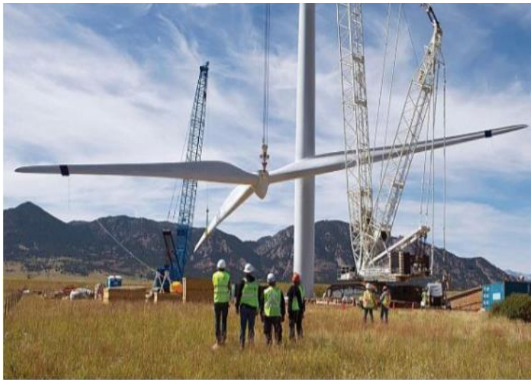
Εικόνα 6.1: Κατασκευή αιολικού πάρκου στην ξηρά
