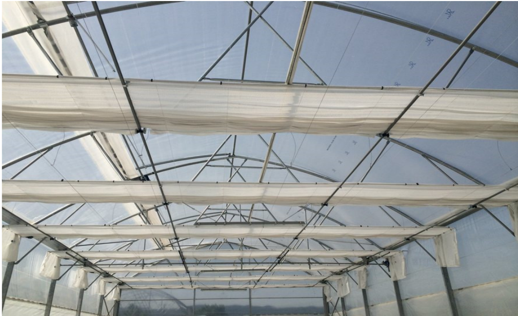
Εικόνα 10. Θερμοκουρτίνα σε θερμοκήπιο
