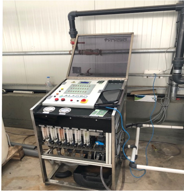
Εικόνα 14. Κεφαλή λίπανσης
