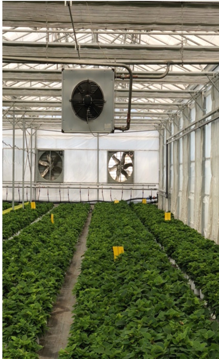
Εικόνα 9. Σύστημα αερισμού
