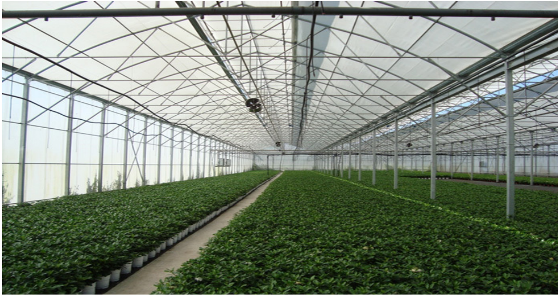
Εικόνα 1. Εσωτερικό θερμοκηπίου ανοίγματος 9,60 μ., πλαϊνή κάλυψη πολυκαρβονικό, οροφή διπλό φουσκωτό φιλμ
