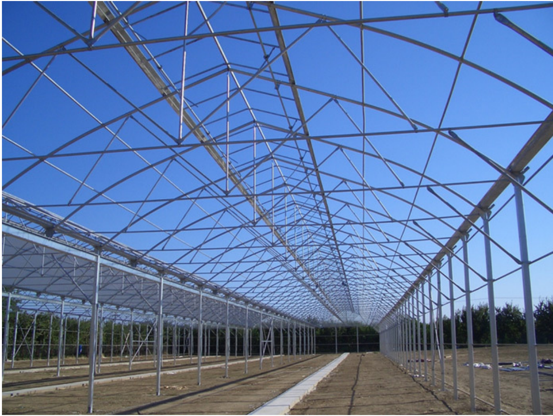
Εικόνα 2. Μεταλλικός σκελετός θερμοκηπίου, ανοίγματος 9,60 μ., ύψος υδροροής 5 μ.
