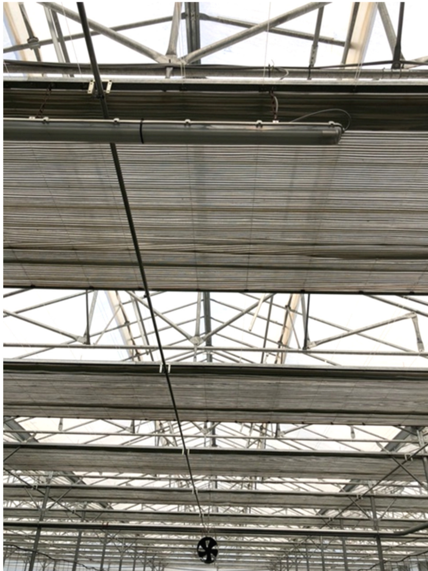
Εικόνα 11. Θερμοκουρτίνα θερμοκηπίου
