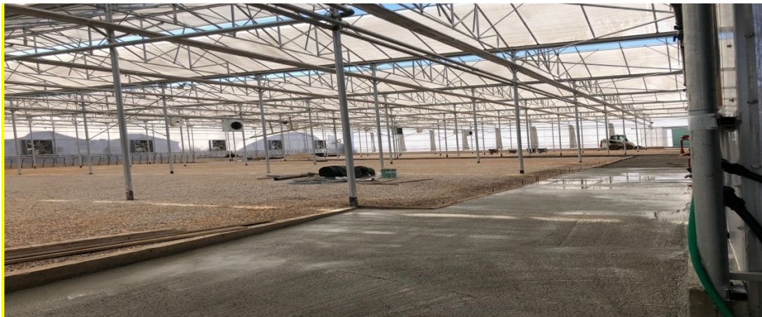
Εικόνα 6. Σκελετός θερμοκηπίου
