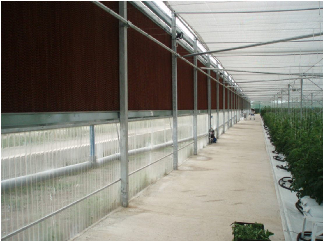
Εικόνα 4. Σύστημα δροσισμού με πάνελ υγρής παρειάς
