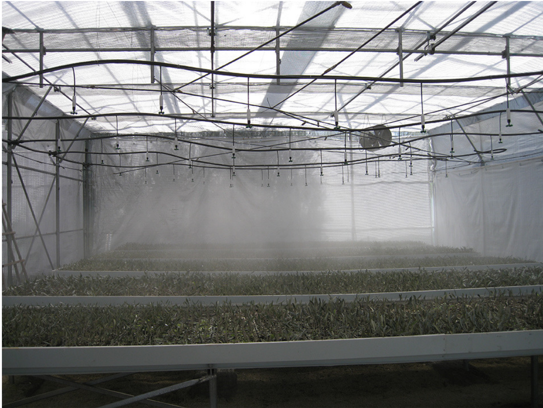
Εικόνα 12. Υδρονέφωση θερμοκηπίου
