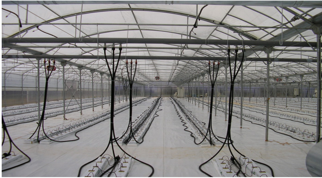
Εικόνα 5. Σύστημα επιδαπέδιας θέρμανσης
