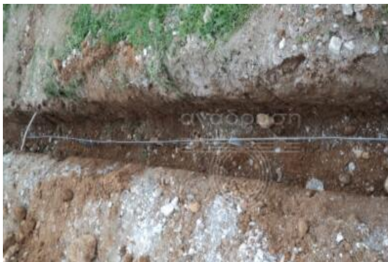
Εικόνα 4-6 Περιμετρική Γείωση Εγκατάστασης Αλεξικέραυνων Κλωβού Faraday Κτηρίου
