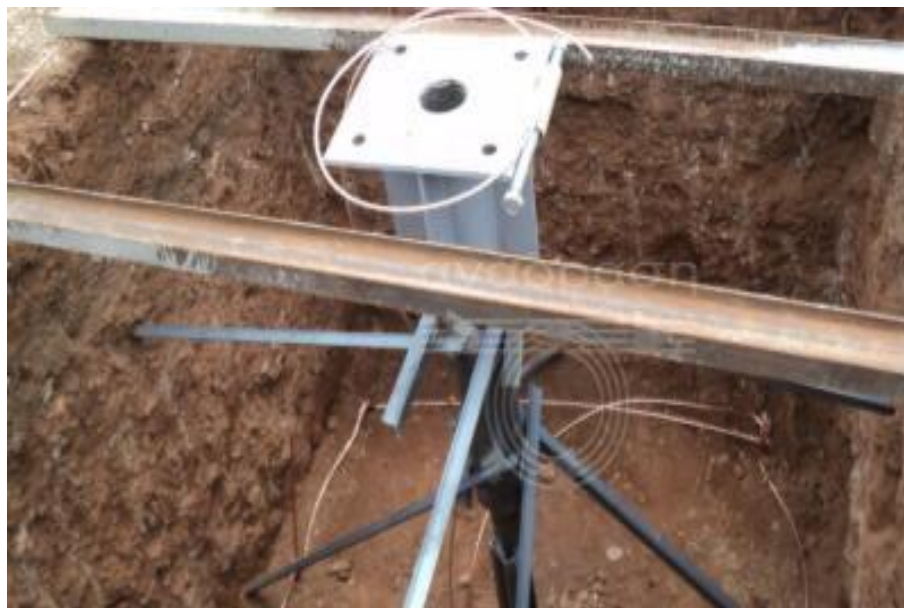
Εικόνα 4-14 Εγκαταστάσεις Αντικεραυνικών Συστημάτων Ιονισμού
