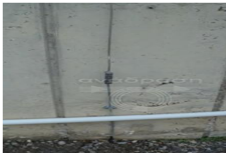
Εικόνα 4-5 Αντικεραυνικά Συστήματα Προστασίας Κτηρίων Κλωβού Faraday
