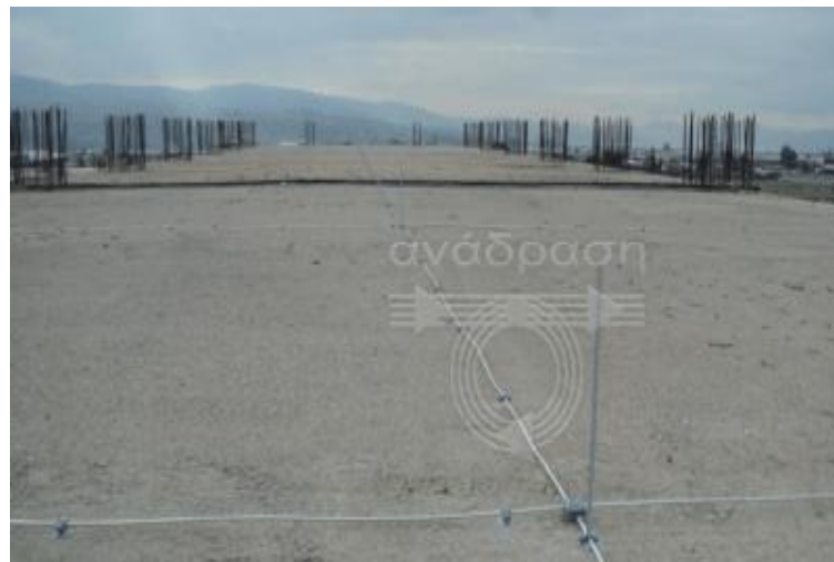
Εικόνα 4-4 Κατασκευή Εγκατάστασης Αντικεραυνικής Προστασίας Κτηρίου (πλέγμα στην ταράτσα)
