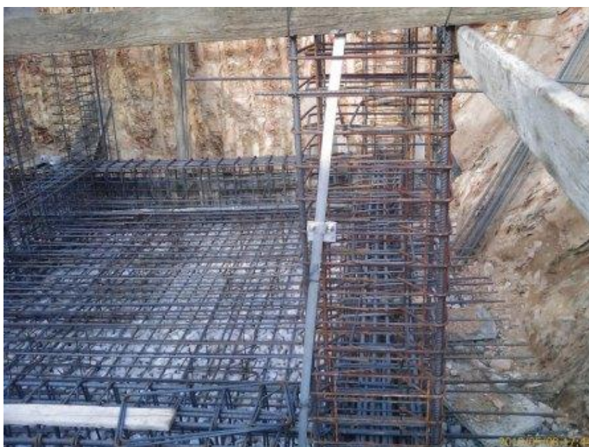
Εικόνα 4-7 Εγκατάσταση περιμετρικής ταινίας γείωσης στη θεμελίωση
