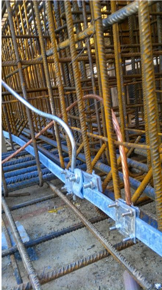
Εικόνα 4-11 Απολήξεις αγωγών καθόδου στην ταινία γείωσης
