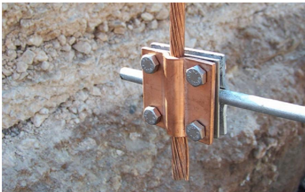
Εικόνα 4-10 Αναμονή σύνδεσης για θεμελιακή γείωση
