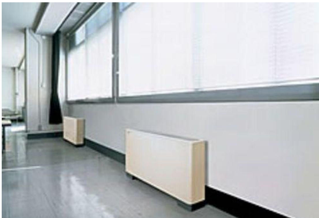
Εικόνα 7 Άποψη οικίας με FCU δαπέδου(πηγή: www.directindustry.com )
