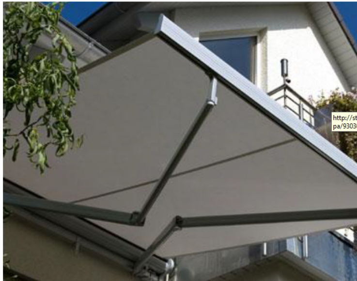
Εικόνα 7: Κινητό σκίαστρο εξωτερικού χώρου
