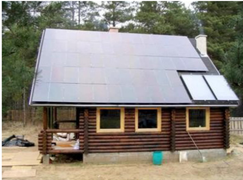
Εικόνα 11:εγκατάσταση Φ/Β στην οροφή κτιρίου
