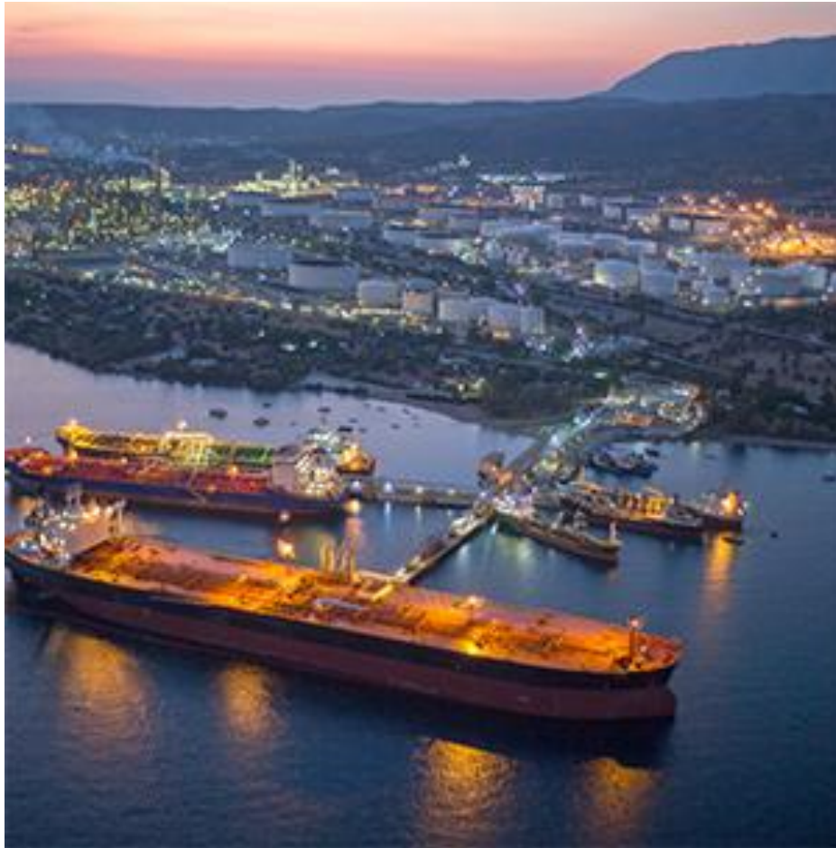
Εικόνα 5.1 Οι εγκαταστάσεις της LPC A.E. στον Ασπρόπυργο Αττικής [8].
