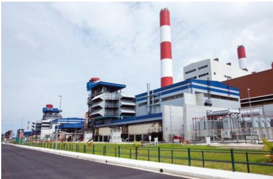
Εικόνα 7.1 Μεγάλη μονάδα συμπαραγωγής ηλεκτρισμού και θερμότητας στη Σιγκαπούρη [18].
