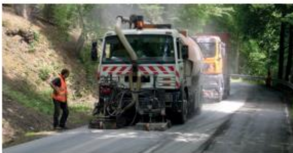
Εικόνα 46: Ήλωση οδοστρώματος (20)
