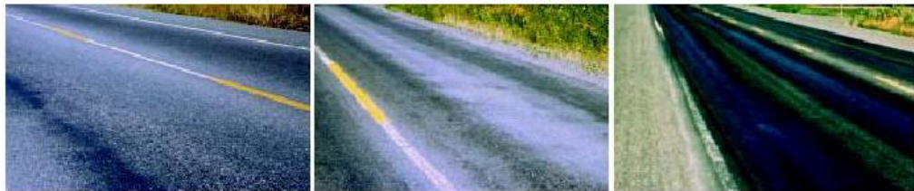
Εικόνα 29: Επίπεδα σοβαρότητας του φαινομένου ανάδυσης ή εξίδρωσης της ασφάλτου (17)
