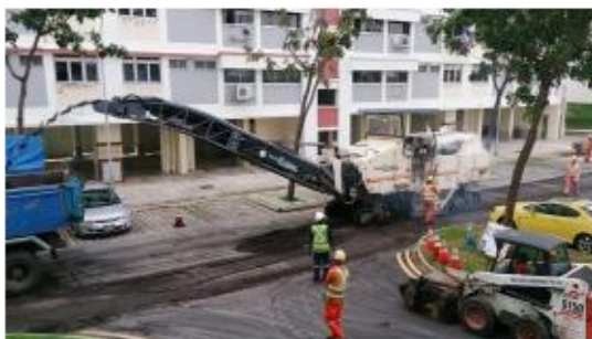
Εικόνα 47: Χάραξη – εκτομή οδοστρώματος (21)
