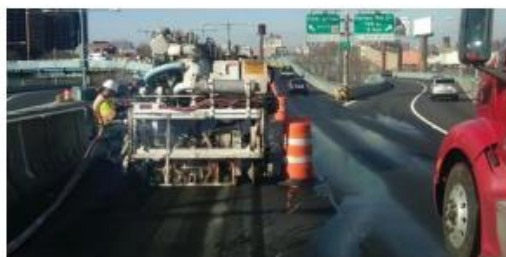
Εικόνα 48: Χάραξη – πριονισμός οδοστρώματος (19)
