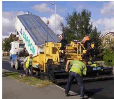
Εικόνα 52: Διάστρωση θερμού ασφαλτομίγματος (19)
