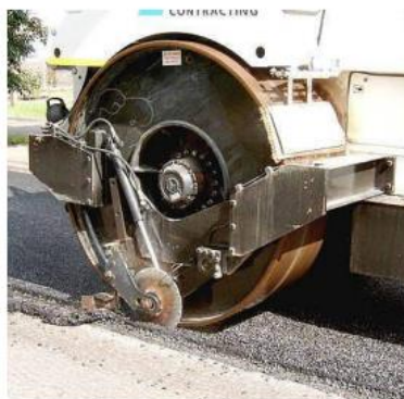
Εικόνα 55: Τομή ασύνδετου υλικού στους αρμούς (19)
