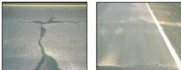
Εικόνα 30: Ανάδυση και άντληση νερού και λεπτόκοκκου υλικού (17)
