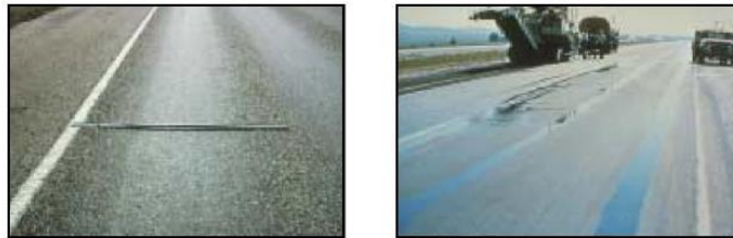
Εικόνα 25: Αυλακώσεις και αυλακώσεις με παραμένοντα νερά (17)
