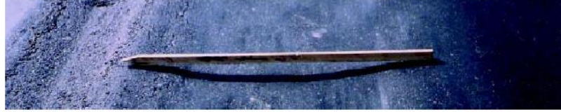
Εικόνα 24: Αυλακώσεις από τροχιές τροχών (17)
