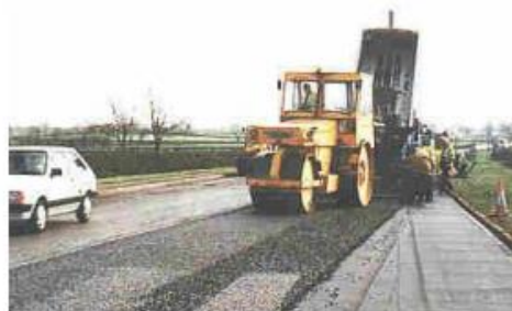
Εικόνα 53: Διάστρωση ψηφίδων στο θερμό ασφαλτόμιγμα (19)
