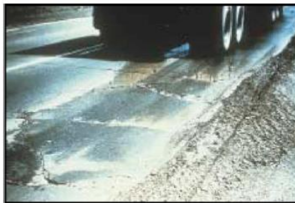
Εικόνα 43: Επιφανειακές παραμορφώσεις (καθιζήσεις) (17)
