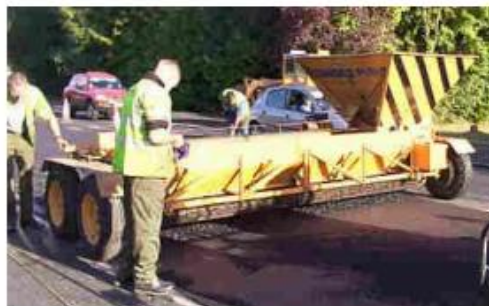
Εικόνα 53: Διάστρωση ψηφίδων στο θερμό ασφαλτόμιγμα (19)
