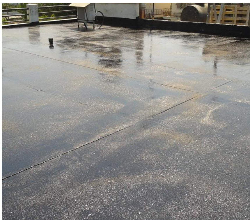
Εικόνα 4.19: Δεύτερη στρώση μόνωσης και τελική επίστρωση χαλαζιακού αδρανούς για δημιουργία μηχανικής πρόσφυσης.
