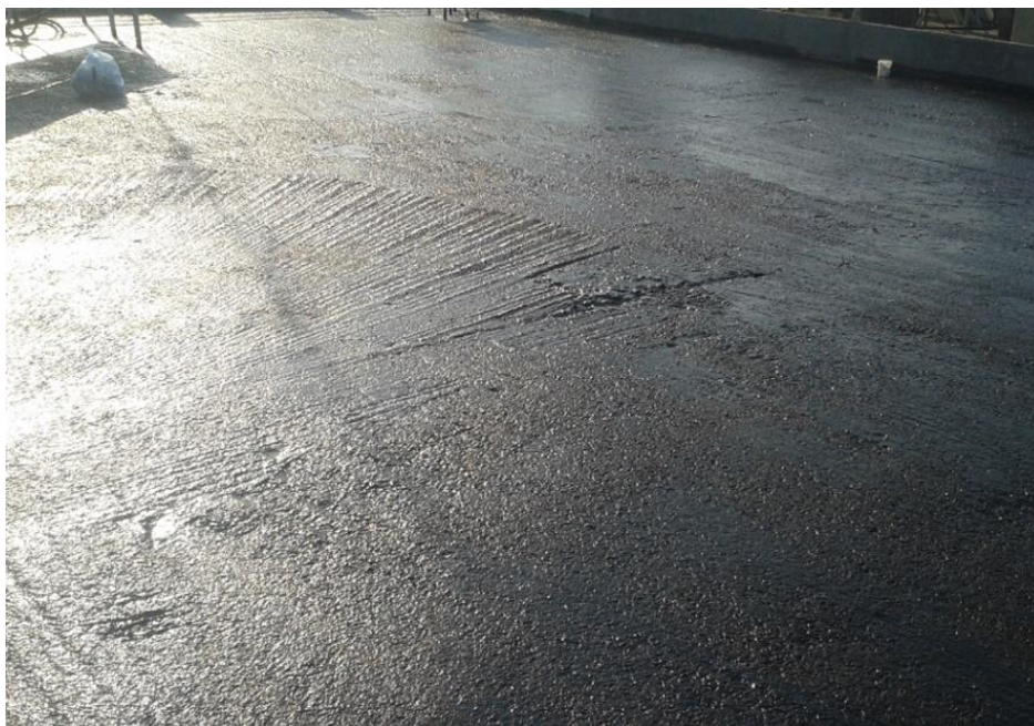
Εικόνα 4.13: Φράγμα υδρατμών με ελαστομερές υβρίδιο πολυουρεθάνης ασφάλτου.
