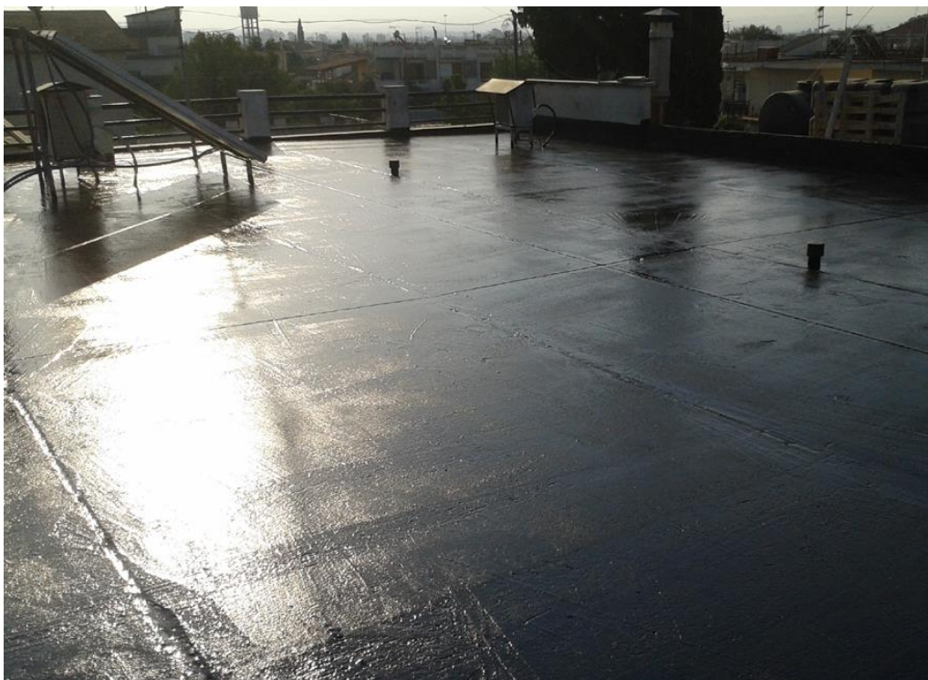
Εικόνα 4.18: Κοπή αρμών και εφαρμογή μόνωσης ελαστομερούς υβριδίου ασφάλτου πολυουρεθάνης.
