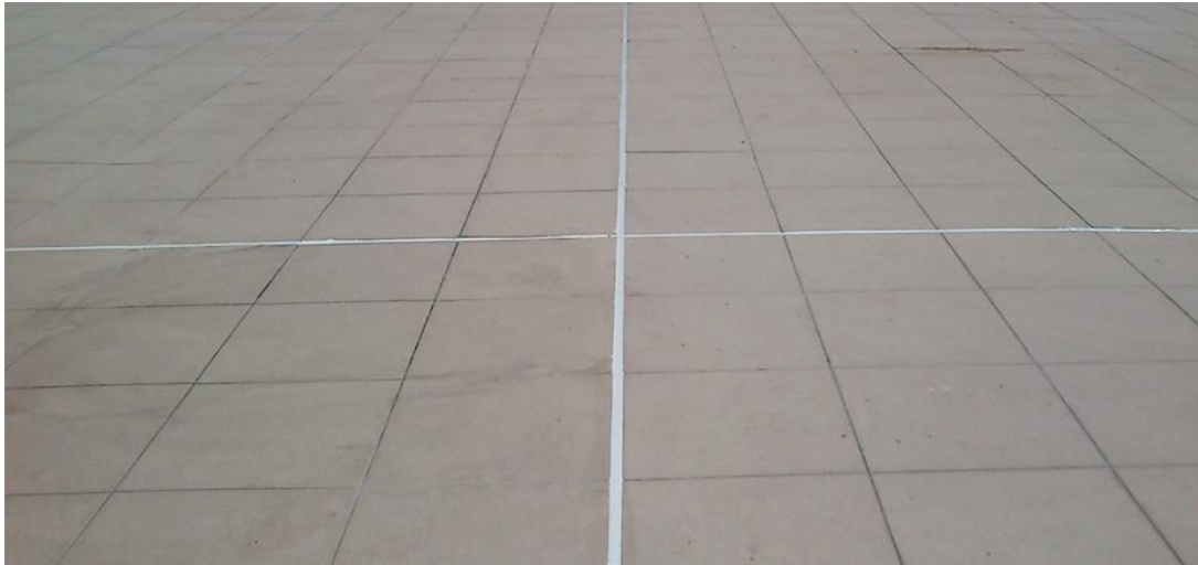
Εικόνα 4.20: Τελική στρώση πλακόστρωση με αρμούς κινητικότητας.
