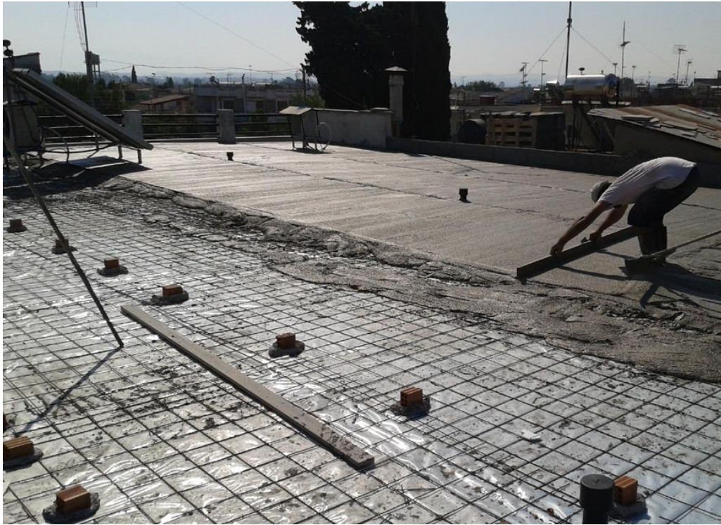
Εικόνα 4.16: Επίστρωση υλικού ρύσεων Interfill
