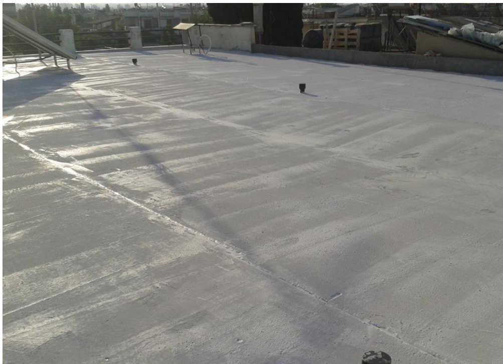
Εικόνα 4.17: Τέλική επιφάνεια υλικού ρύσεων.
