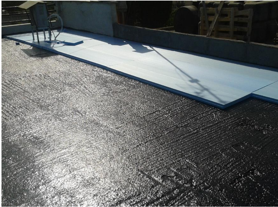
Εικόνα 4.14: Τοποθέτηση εξηλασμένης πολυστερίνης 5cm με κονίαμα θερμοπρόσοψης.
