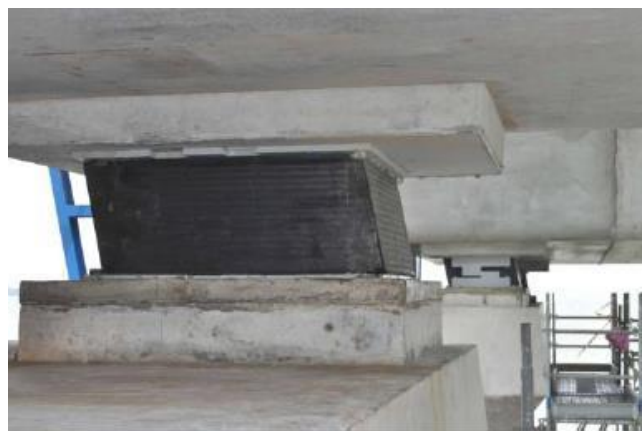
Εικ.36 Ελαστομεταλλικό εφέδρανα υψηλής απόσβεσης (HDNR), ( https://docplayer.gr/51806362-Ptyhiaki-ergasia-syneisfora-pathitikon-systimatou-stonelegho-talantoseon-kataskeyon.html )
