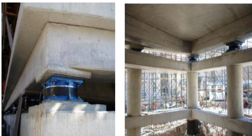
Εικ.40 Εφέδρανα ολίσθησης ( ikee.lib.auth.gr )
