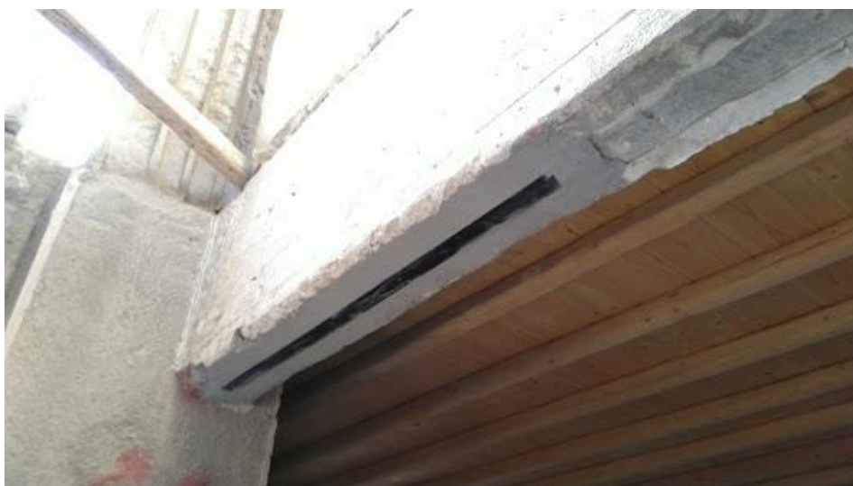
Εικ.11 Ενίσχυση με ινοπλισμένα πολυμερή με την μορφή ελάσματος, ( http://www.epidomos.gr/page.php?id=50&lang= )
