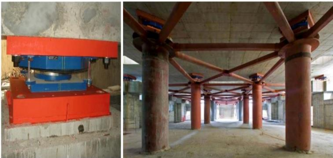
Εικ.42 Εφεδρανα Ολίσθησης και η τοποθέτηση τους ( library.tee.gr)
