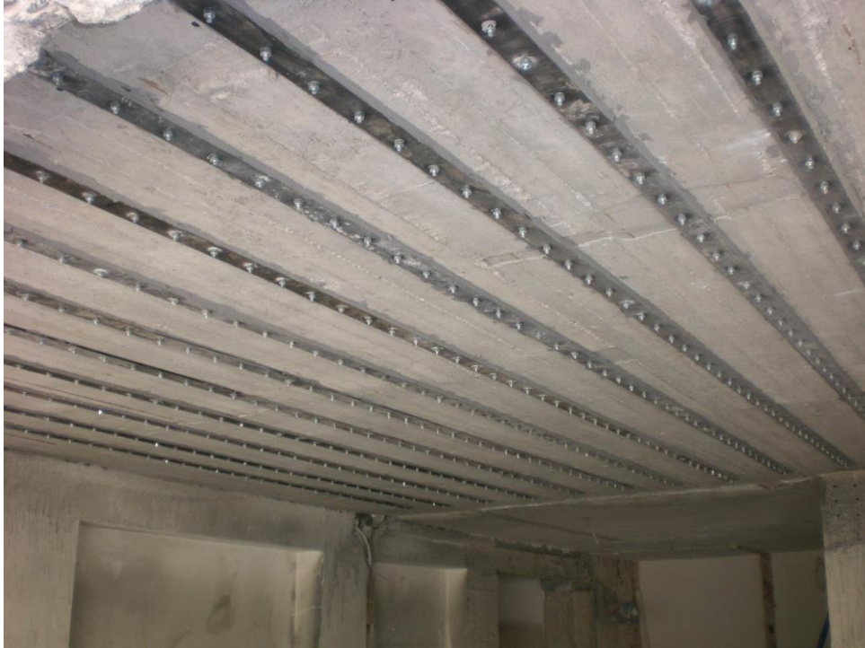
Εικ.12 Επικολλητά μεταλλικά ελάσματα, με χρήση πρόσθετων στοιχείων αγκύρωσης ( http://sideris-konstantinos.blogspot.com/p/blog-page_8741.html )
