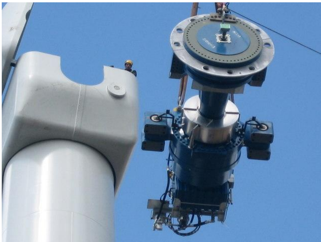
Εικόνα 2: Τα εξαρτήματα μιας ανεμογεννήτριας οριζόντιου άξονα (κιβώτιο ταχυτήτων, άξονας ρότορα και συγκρότημα φρένων) ανυψώνονται στη θέση τους.
