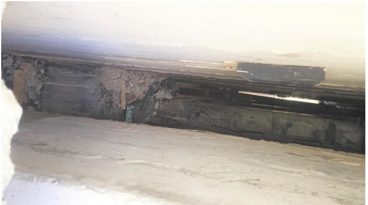
Φωτογραφία 5.21 Ελαστομεταλλικά εφέδρανα γέφυρας.
