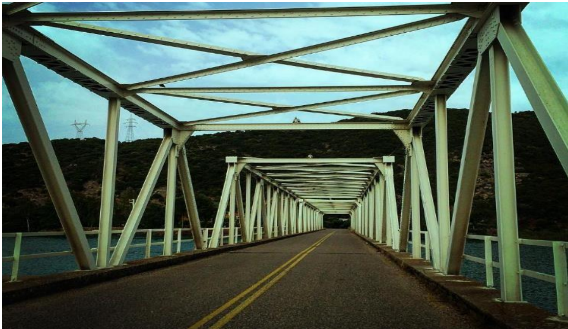
Εικόνα 1.14. Η μεταλλική γέφυρα Μαρσουλίου στον Αχελώο [link 14].
