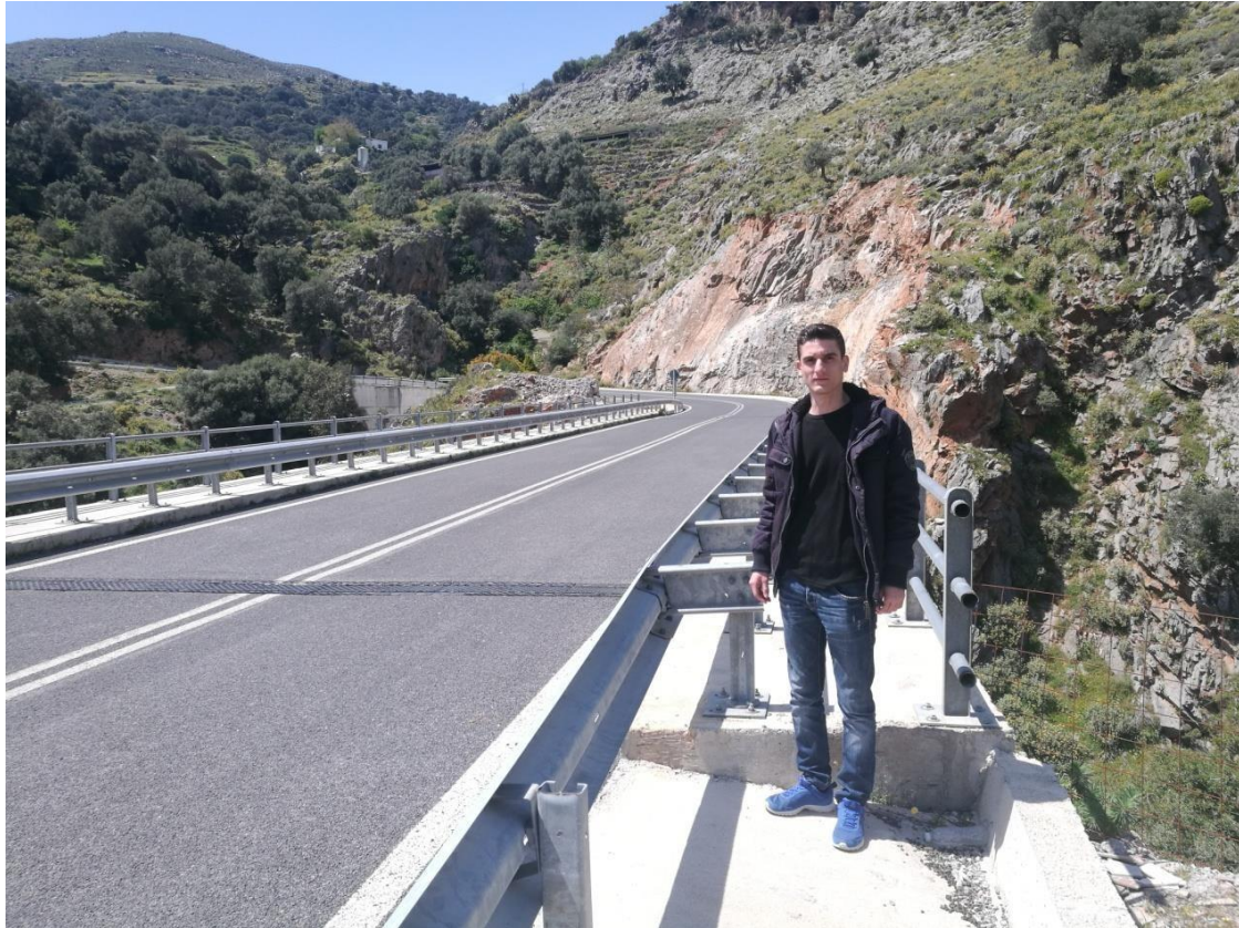
Φωτογραφία 5.20 Κατάστρωμα γέφυρας (φαίνεται και ο φοιτητής κ.Λιοδακης).
