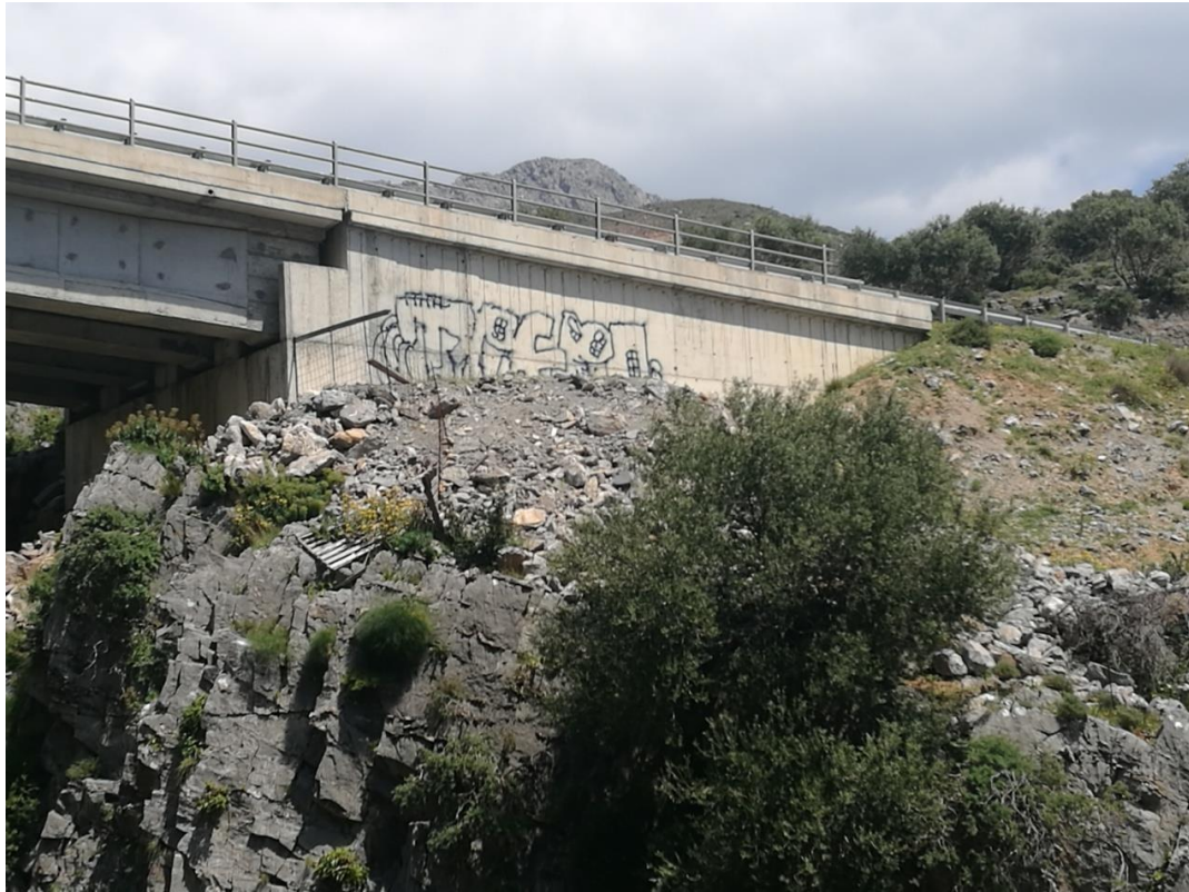
Φωτογραφία 5.4 Θεμελίωση δεξιού ακρόβαθρου.
