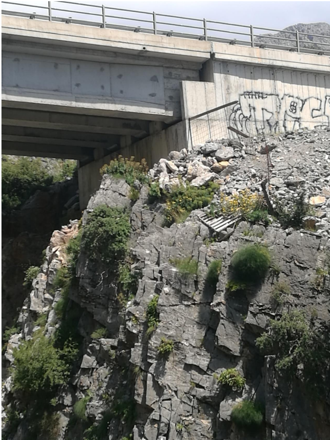
Φωτογραφία 5.3 Δεξιό ακρόβαθρο γέφυρας.
