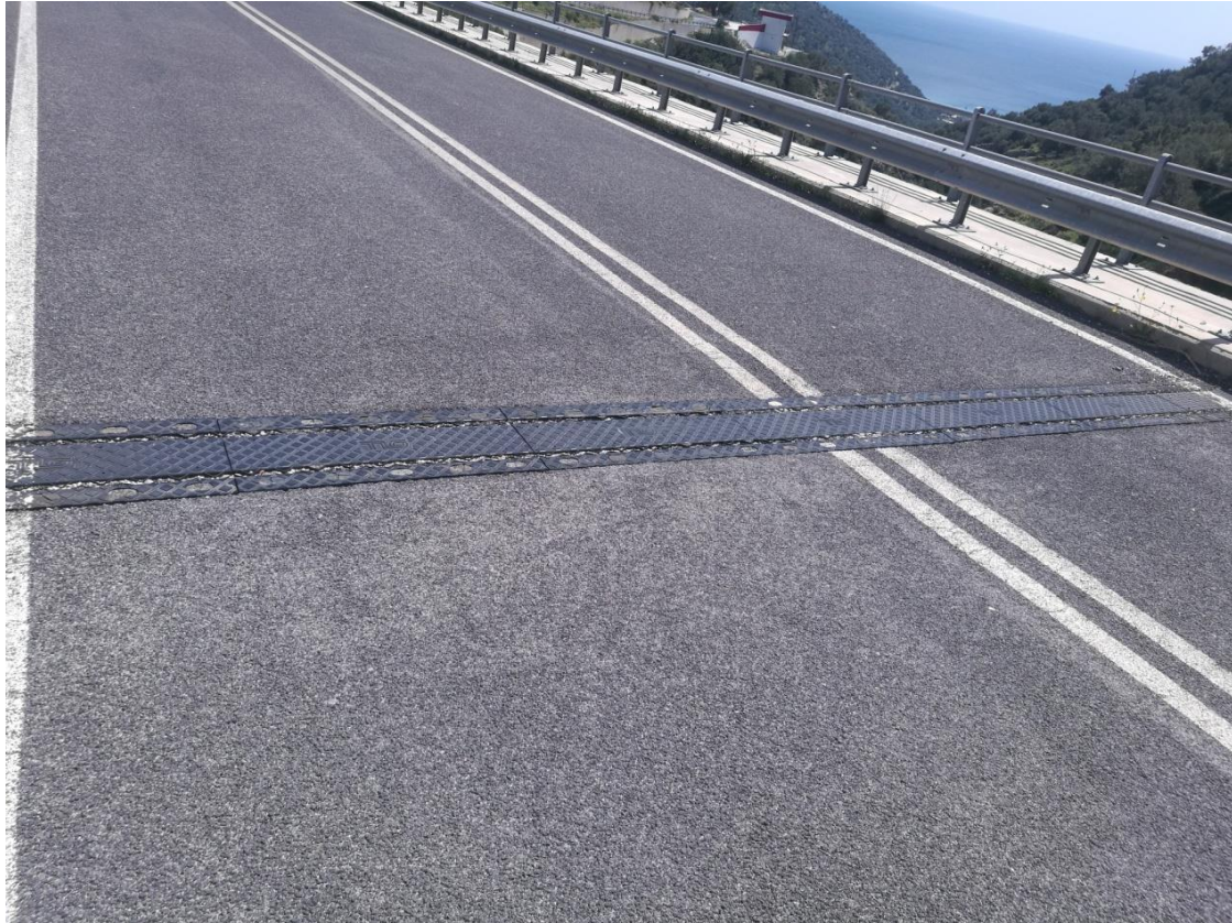
Φωτογραφία 5.10 Αρμός στο κατάστρωμα της γέφυρας.
