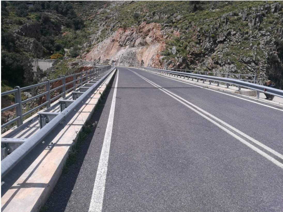
Φωτογραφία 5.8 Κατάστρωμα γέφυρας.
