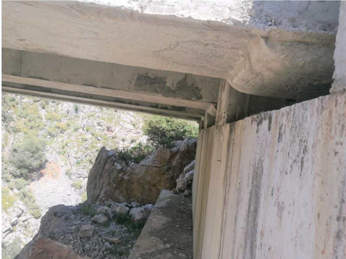
Φωτογραφία 5.15 Πλάγια όψη γέφυρας και βάθρα στήριξης.
