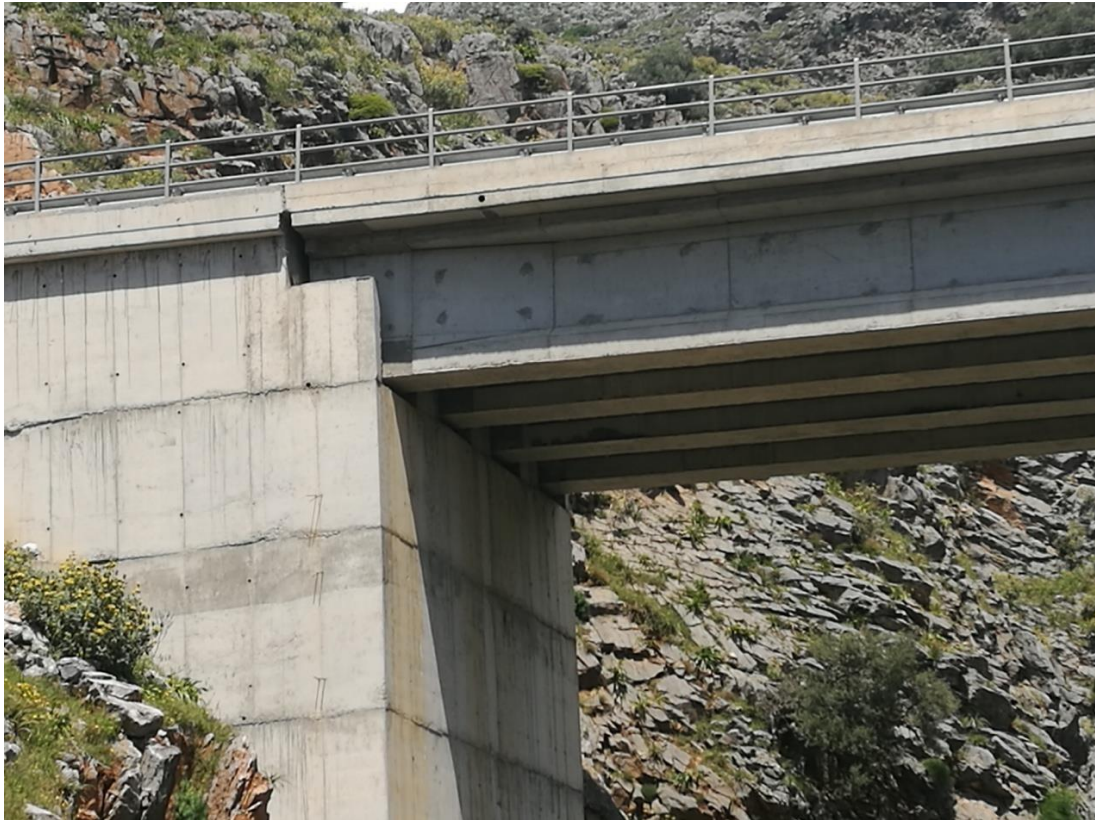
Φωτογραφία 5.6 Σύνδεση καταστρώματος με δεξιό ακρόβαθρο.
