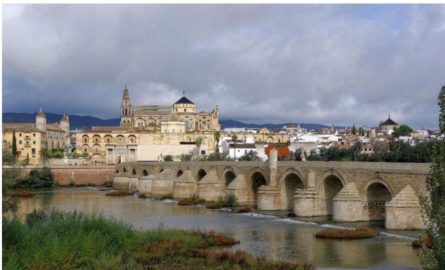
Εικόνα 1.2. Η Ρωμαϊκή γέφυρα της Κόρδοβας, κτίστηκε το 1ο αιώνα π.Χ., έχει συνολικό μήκος 247 μέτρα και πλάτος περίπου 9 μέτρα [link 2].
