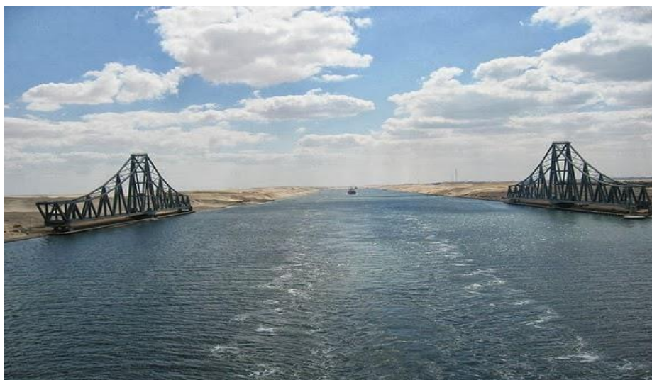
Εικόνα 1.10. El Ferdan Railway Bridge, Αίγυπτος [link10].
