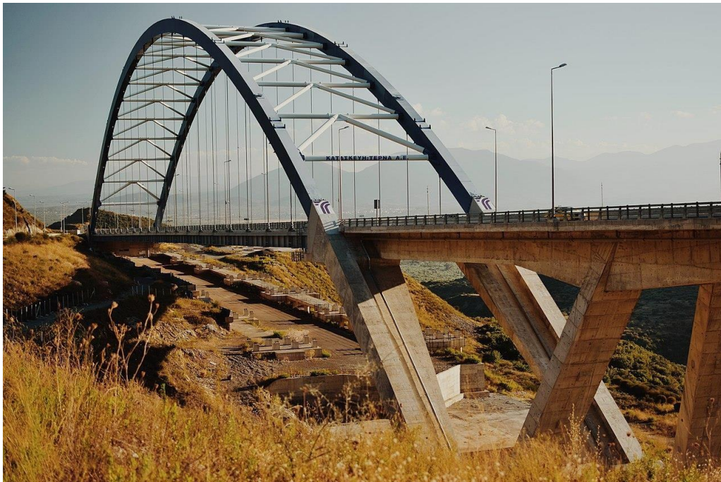
Εικόνα 1.7. Τοξωτή Γέφυρα Τσακώνας είναι μια από τις μεγαλύτερες τοξωτές γέφυρες με πολλαπλά ανοίγματα στον κόσμο [link 7].
