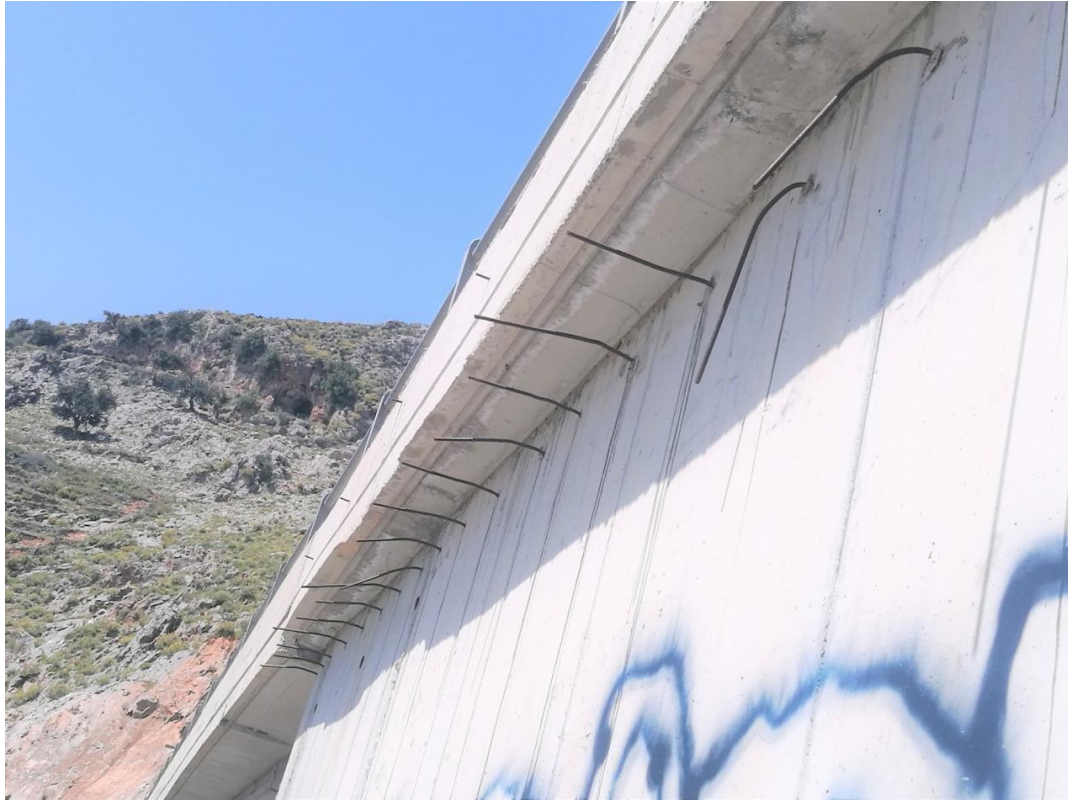
Φωτογραφία 5.17 Πρόβολος επέκτασης πλάκας γέφυρας.
