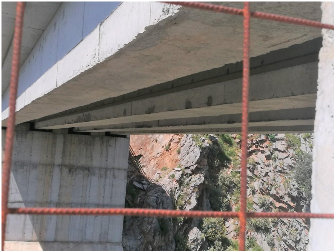
Φωτογραφία 5.14 Γέφυρα από οπλισμένο σκυρόδεμα.
