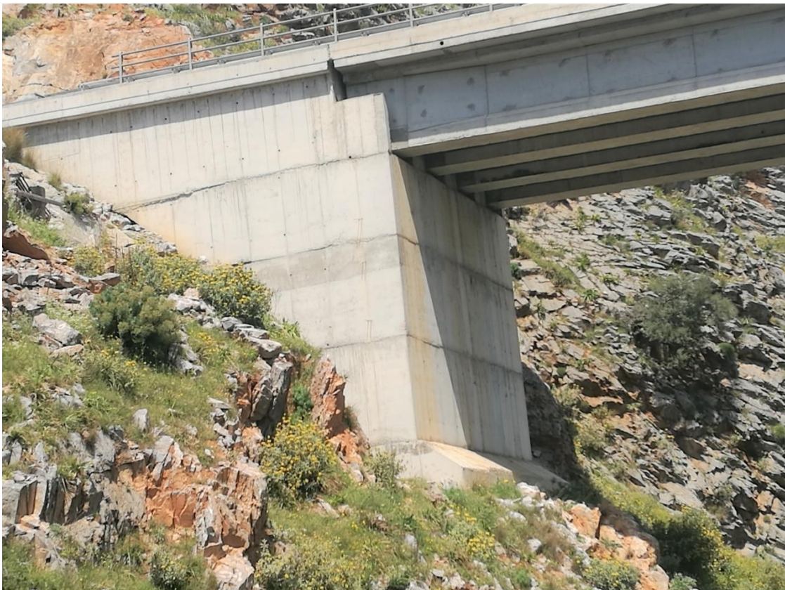
Φωτογραφία 5.2 Αριστερό ακρόβαθρο γέφυρας.
