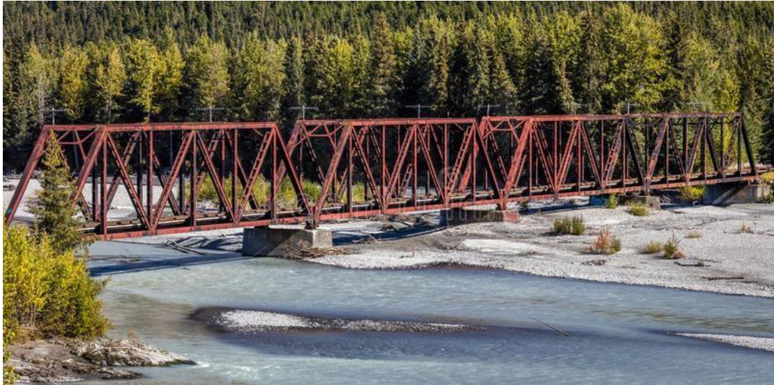
Εικόνα 1.4. Γέφυρα Red Rod Iron στην Αλάσκα [link 4].
