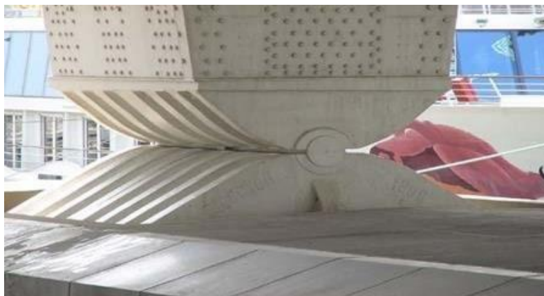
Εικόνα 1.17. Αρθρωτό εφέδρανο [link 17].
