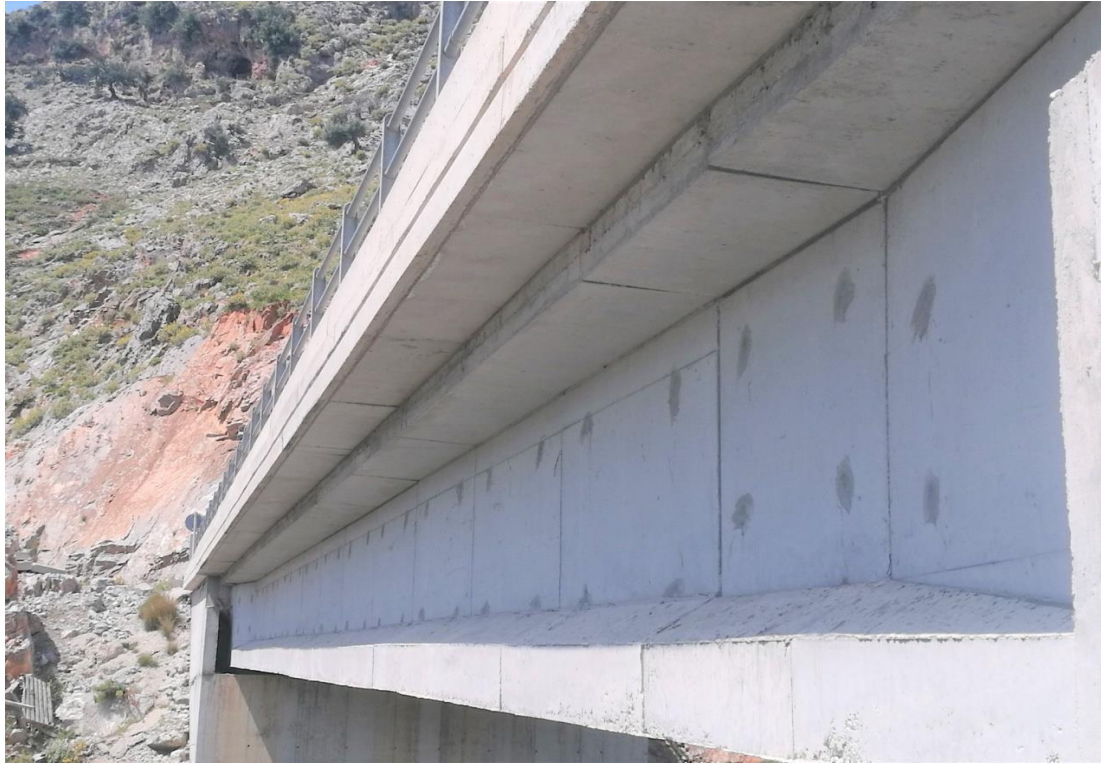
Φωτογραφία 5.13 Δοκός στήριξης γέφυρας από οπλισμένο σκυρόδεμα και πλάκα οδοστρώματος από οπλισμένο σκυρόδεμα.
