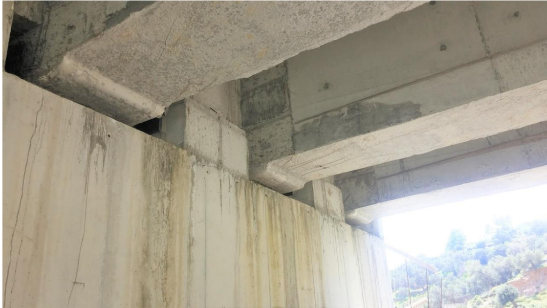
Φωτογραφία 5.22 Δοκάρια γέφυρας από οπλισμένο σκυρόδεμα.
