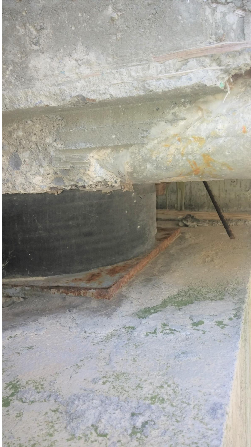
Φωτογραφία 5.22 Ελαστομεταλλικά εφέδρανα.
