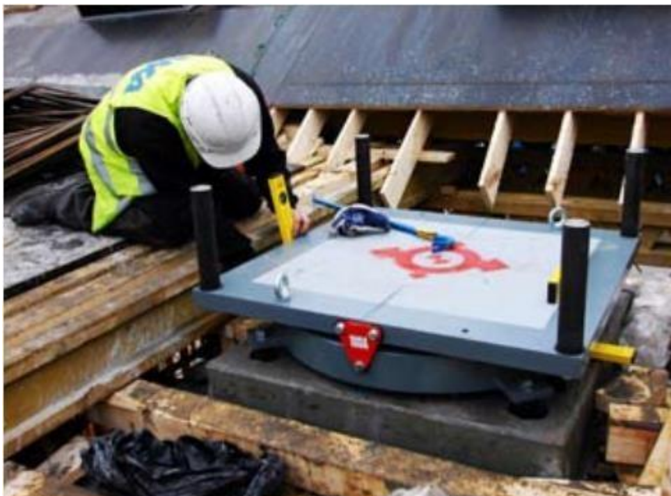
Εικόνα 1.19. Εφέδρανα σημειακού τύπου [link 19].
