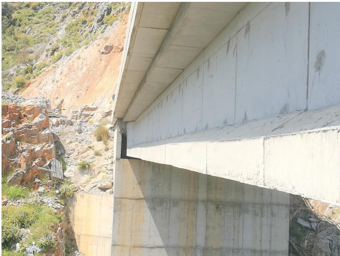
Φωτογραφία 5.16 Κολόνα στήριξης από οπλισμένο σκυρόδεμα.
