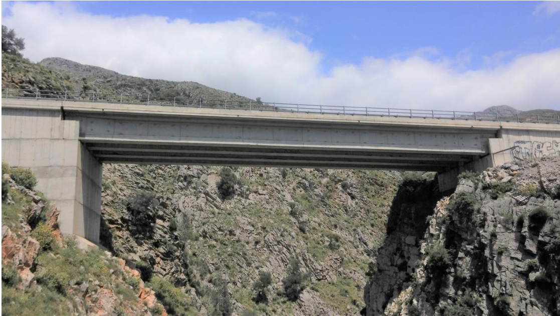
Φωτογραφία 5.1 Όψη γέφυρας έργου.
