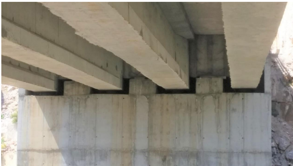
Φωτογραφία 5.24 Δοκάρια γέφυρας και τοιχίο στηριξης γέφυρας.
