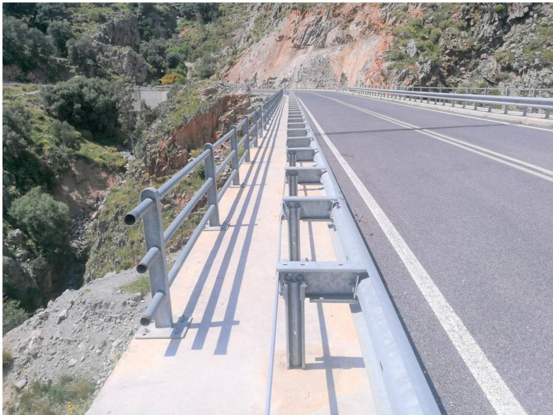
Φωτογραφία 5.18 Προστατευτικές μπάρες, πεζόδρομος.
