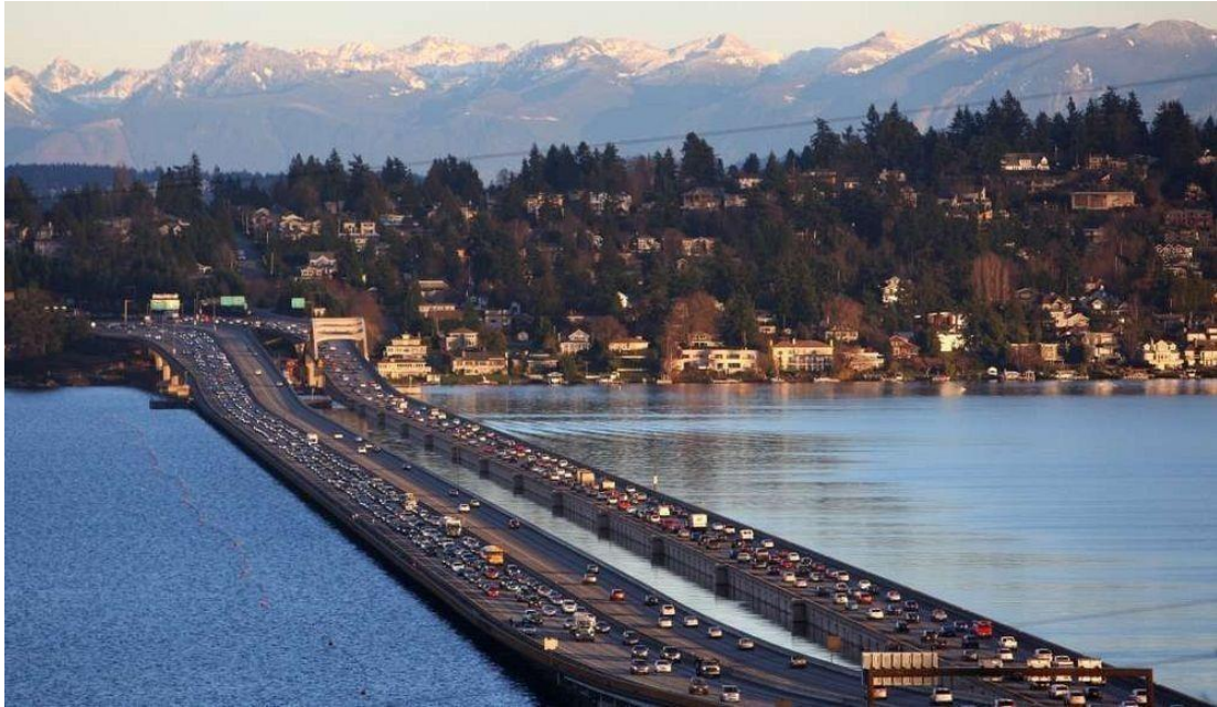
Εικόνα 1.11. Lacey V. Murrow Memorial Bridge, λίμνη Ουάσινγκτον, στο Σιάτλ [link 11].
