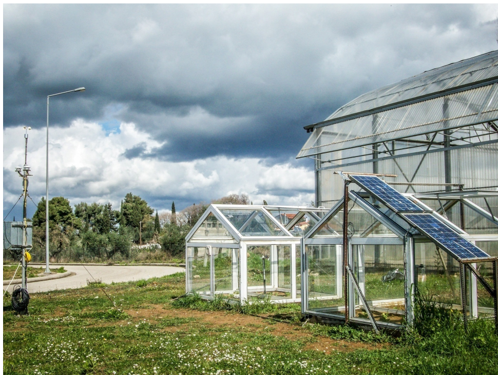
Εικόνα 4β. Τα πειραματικά θερμοκήπια και ο Μετεωρολογικός σταθμός.
