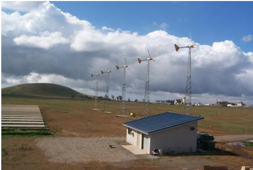
Εικόνα 2-1 Αυτόνομο υβριδικό σύστημα ισχύος
