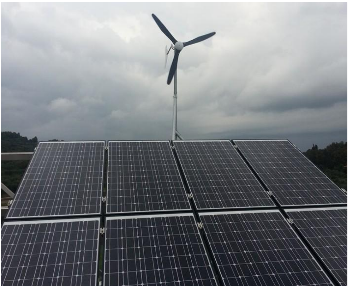
Εικόνα2-4 Ανεμογεννήτρια σε υβριδικό αυτόνομο φωτοβολταϊκό
