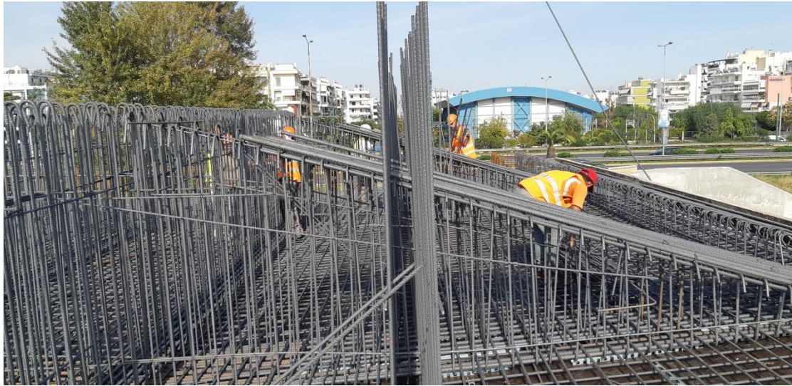
Φωτογραφία 5.33 Οπλισμός διατομής καταστρώματος.
