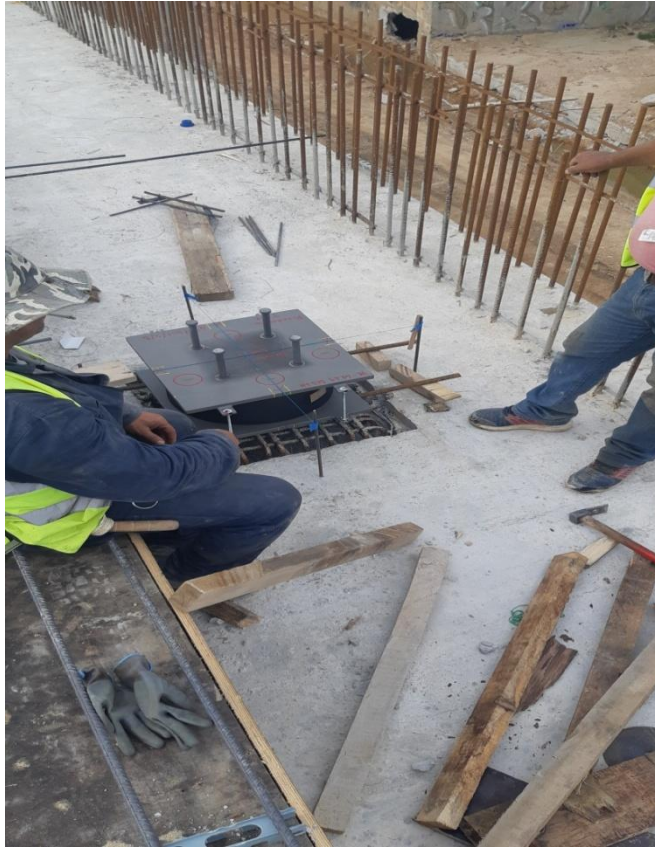
Φωτογραφία 5.36 Τοποθέτηση εφέδρανου.
