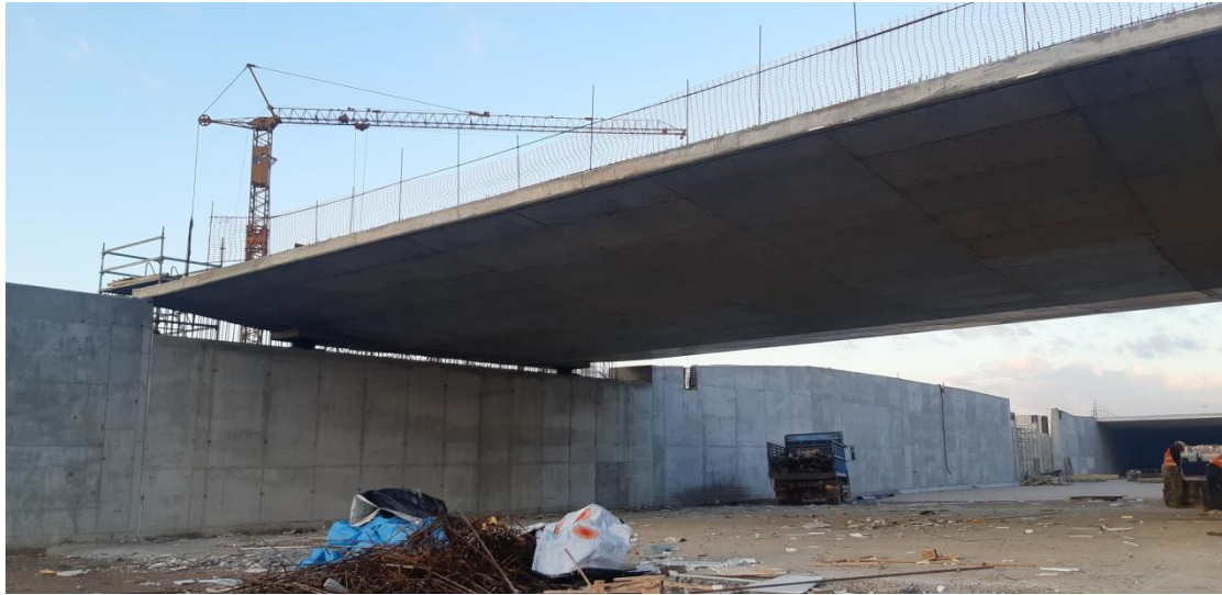
Φωτογραφία 5.56 Πλάκα καταστρώματος.
