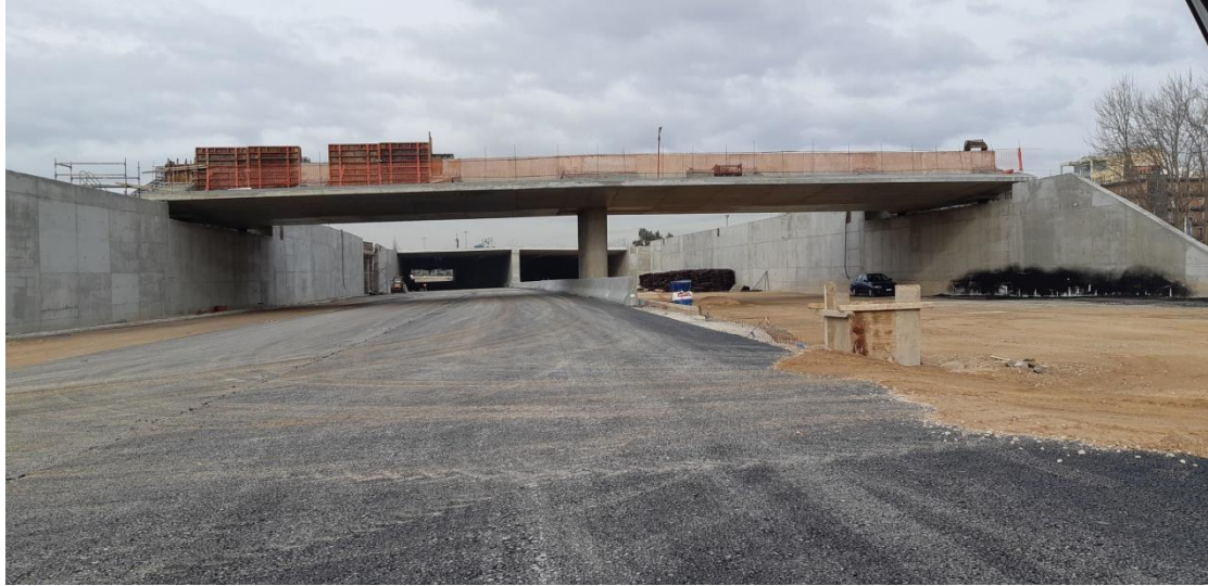
Φωτογραφία 5.58 Όψη γέφυρας.
