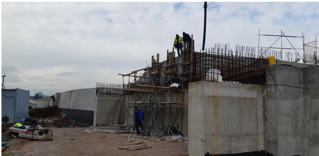
Φωτογραφία 5.51 Έλεγχος οπλισμού από τον επιβλέποντα μηχανικό.
