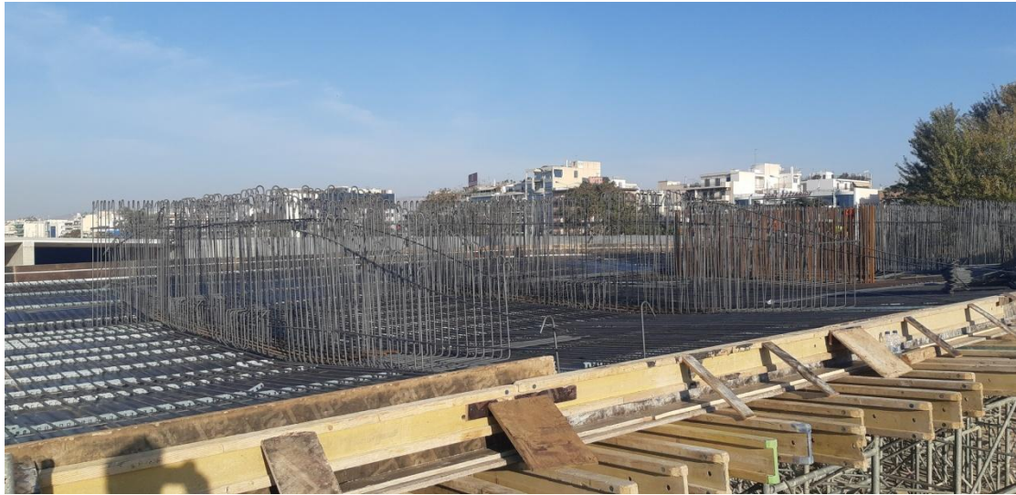
Φωτογραφία 5.31 Τοποθέτηση ξυλότυπου για το κατάστρωμα της γέφυρας.
