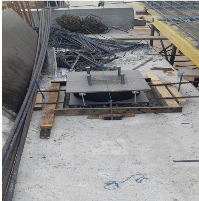
Φωτογραφία 5.37 Τοποθέτηση – έλεγχος εφέδρανου.
