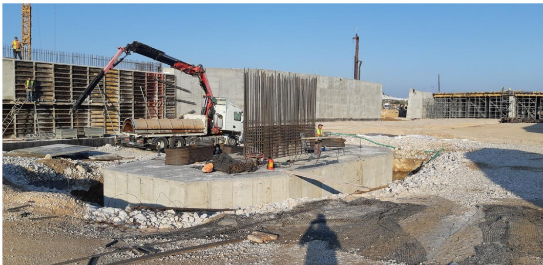
Φωτογραφία 5.13 Οπλισμός (αναμονές) θεμελίου μεσόβαθρου.
