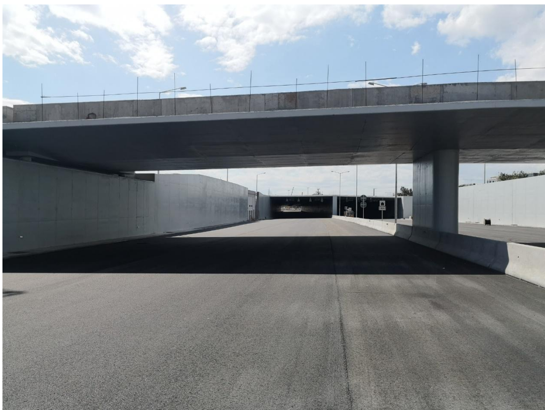
Φωτογραφία 5.61 Έργο πριν την ολοκλήρωση.
