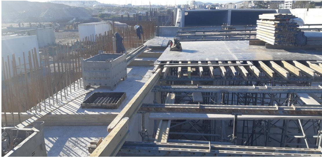
Φωτογραφία 5.27 Τοποθέτηση ξυλότυπου για το κατάστρωμα της γέφυρας.
