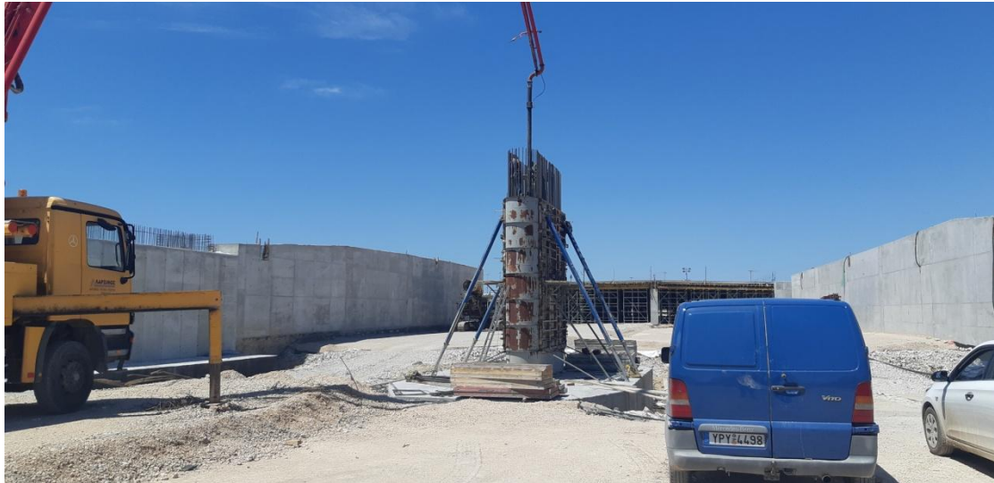
Φωτογραφία 5.16 Σκυροδέτηση κορμού μεσόβαθρου.
