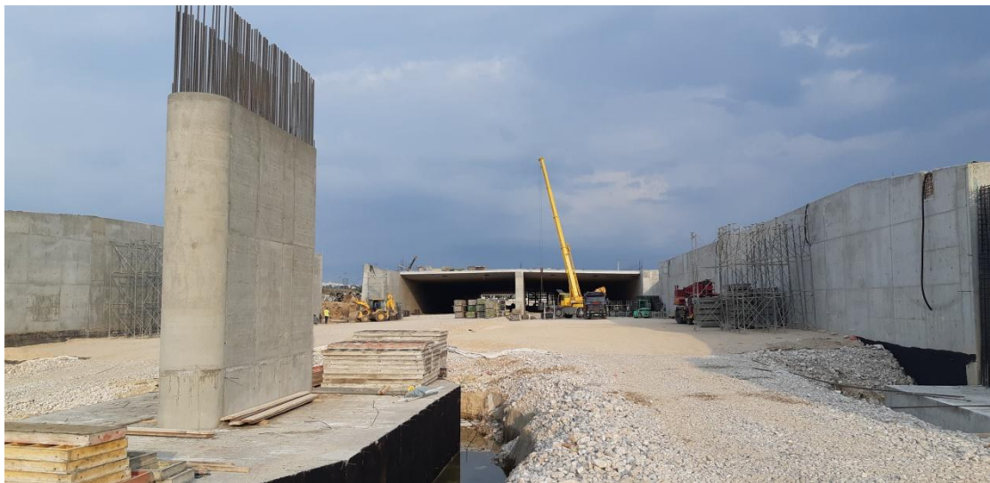
Φωτογραφία 5.22 Φάση της κατασκευής πριν το καλούπωμα του καταστρώματος.
