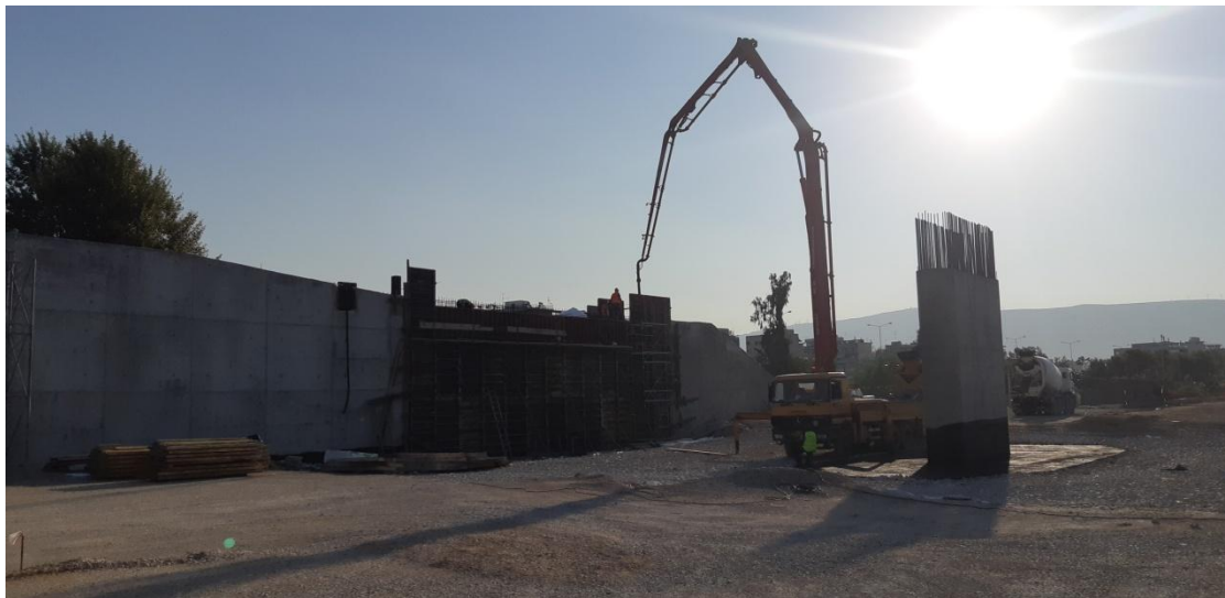
Φωτογραφία 5.24 Σκυροδέτηση τοιχείων.
