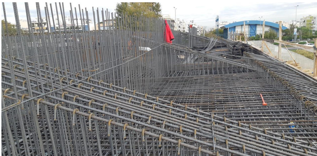
Φωτογραφία 5.38 Οπλισμός διατομής καταστρώματος.
