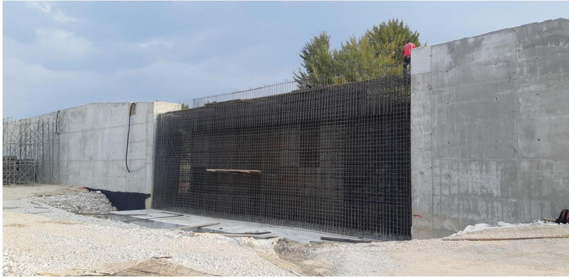
Φωτογραφία 5.21 Οπλισμός τοιχείου.
