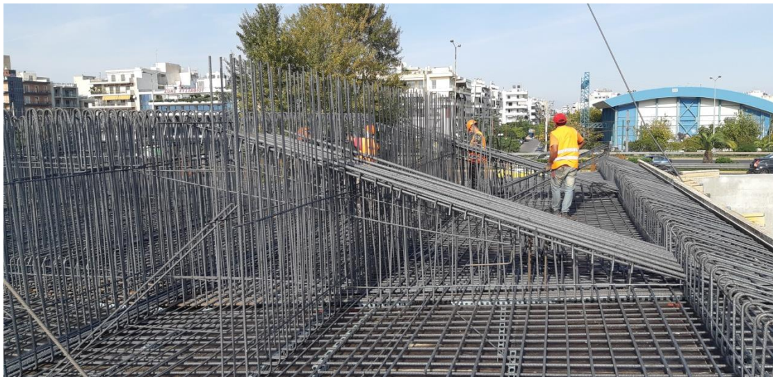
Φωτογραφία 5.34 Οπλισμός διατομής καταστρώματος.
