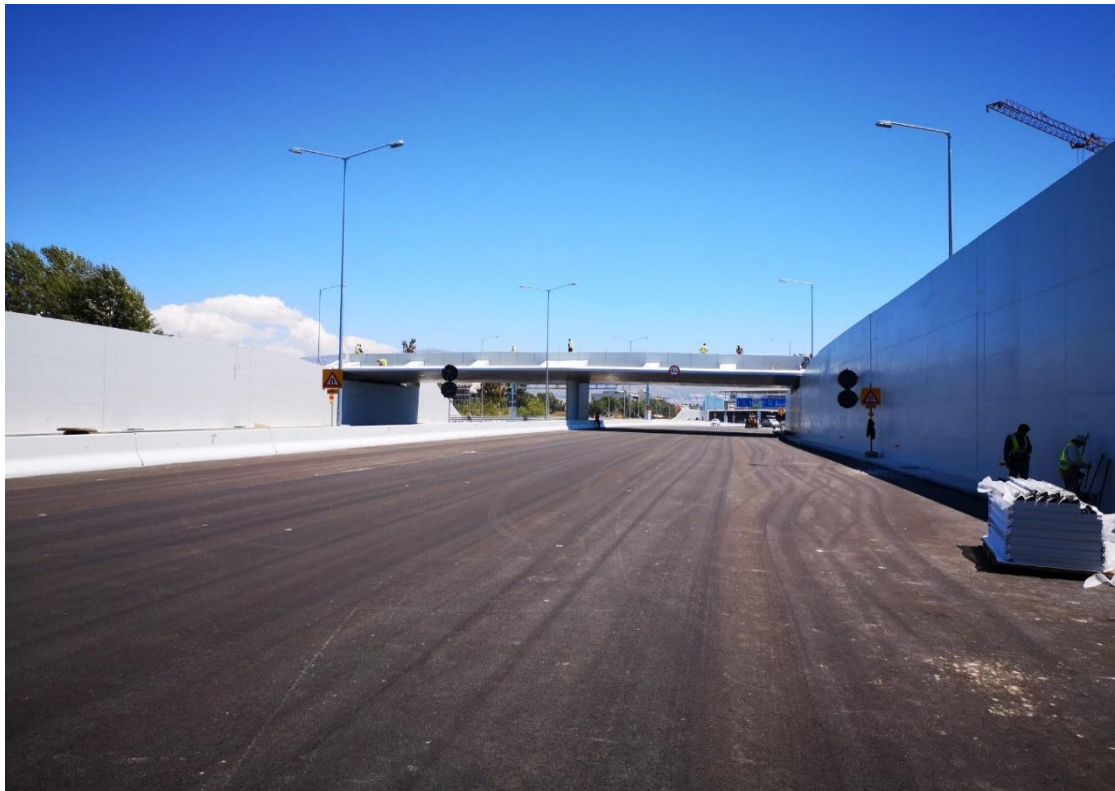
Φωτογραφία 5.63 Έργο στην ολοκλήρωση.
