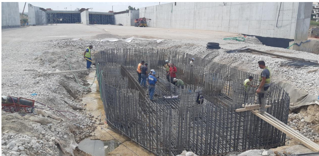
Φωτογραφία 5.5 Οπλισμός θεμελίου μεσόβαθρου.
