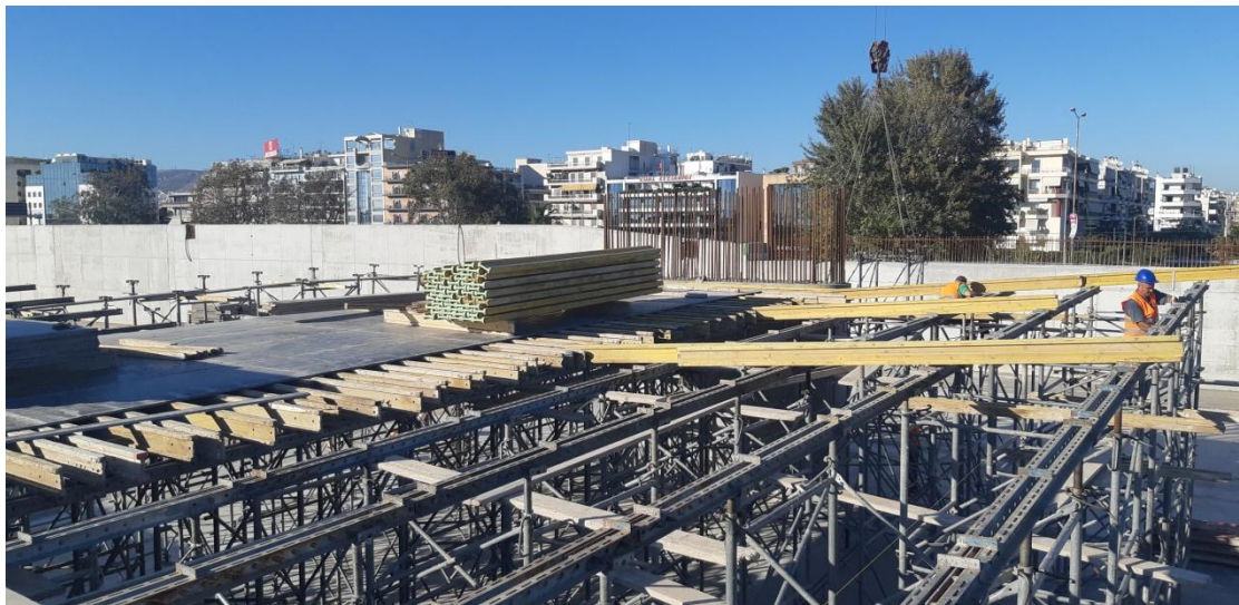
Φωτογραφία 5.26 Τοποθέτηση ξυλότυπου για το κατάστρωμα της γέφυρας.
