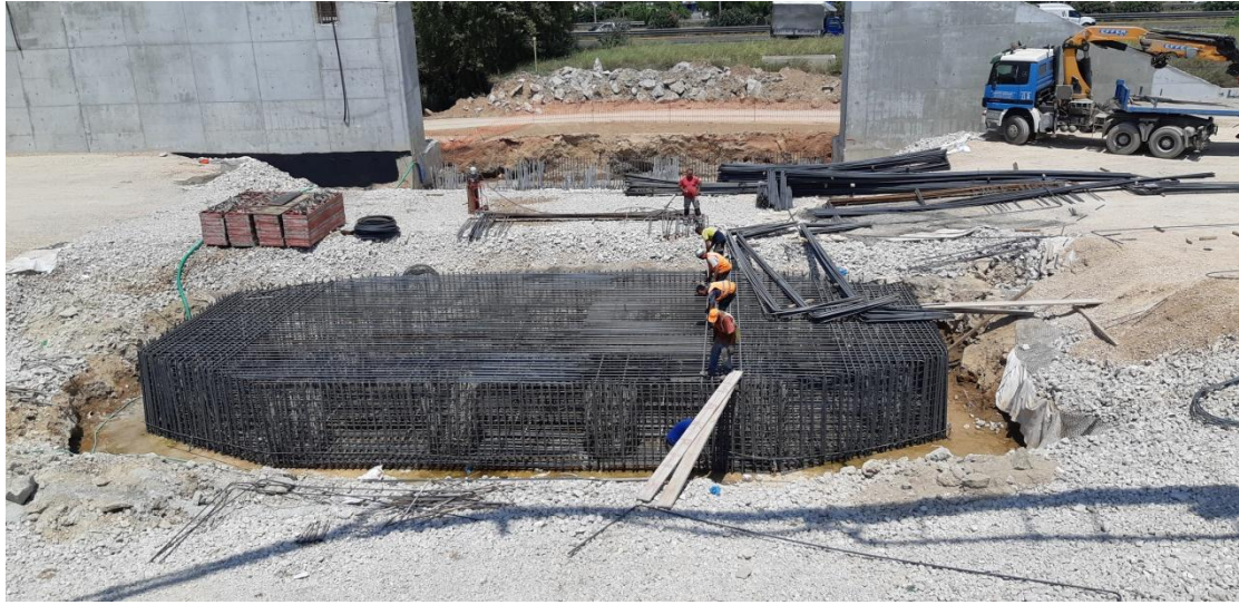
Φωτογραφία 5.10 Οπλισμός θεμελίου μεσόβαθρου.
