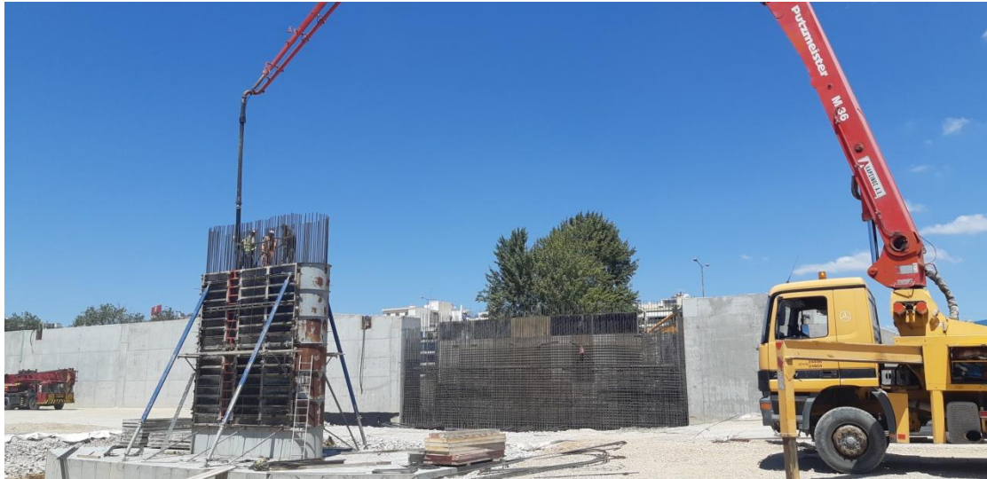
Φωτογραφία 5.18 Σκυροδέτηση κορμού μεσόβαθρου.
