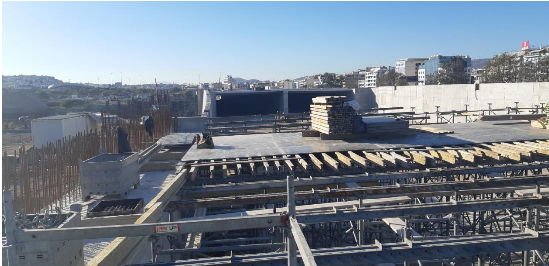
Φωτογραφία 5.29 Τοποθέτηση ξυλότυπου για το κατάστρωμα της γέφυρας.
