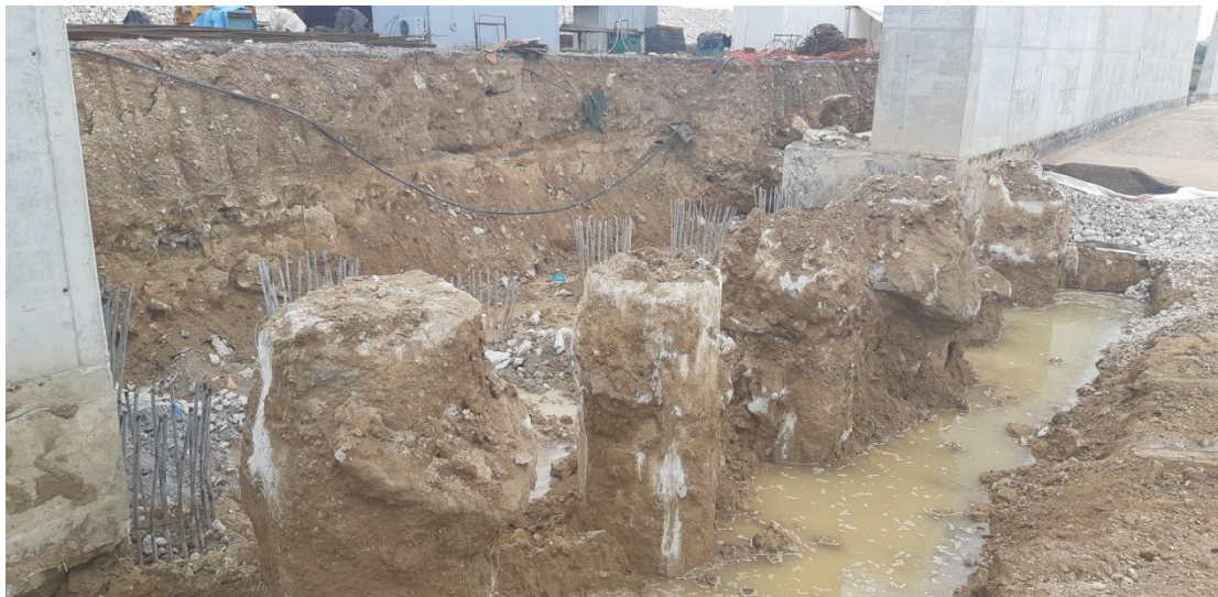
Φωτογραφία 5.1 Θεμελίωση, πασσαλοσωλήνες.
