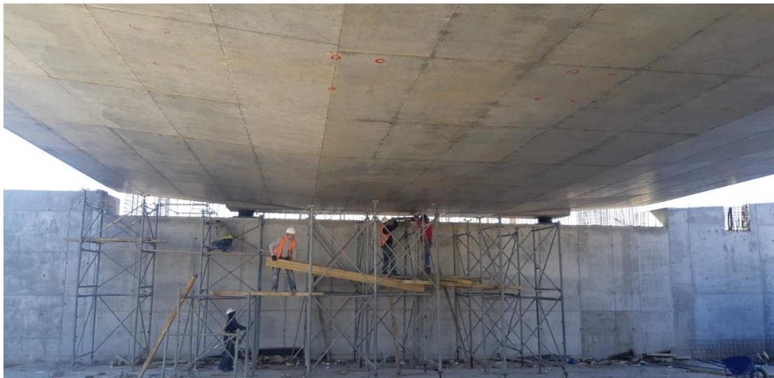
Φωτογραφία 5.55 Πλάκα καταστρώματος (κάτωθεν όψη).
