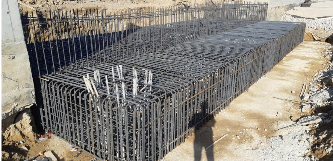
Φωτογραφία 5.2 Οπλισμός πεδίου θεμελίωσης.
