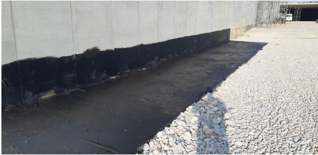
Φωτογραφία 5.23 Τοποθέτηση υγρομόνωσης.
