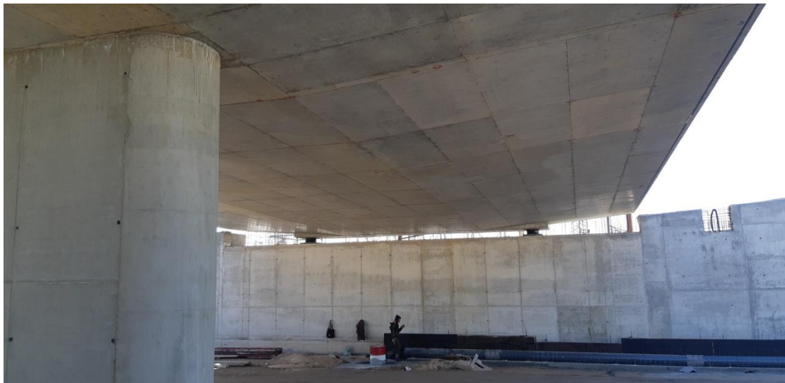
Φωτογραφία 5.57 Πλάκα καταστρώματος.
