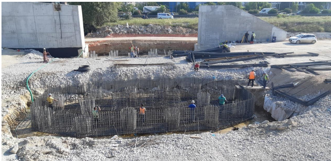
Φωτογραφία 5.7 Οπλισμός θεμελίου μεσόβαθρου.
