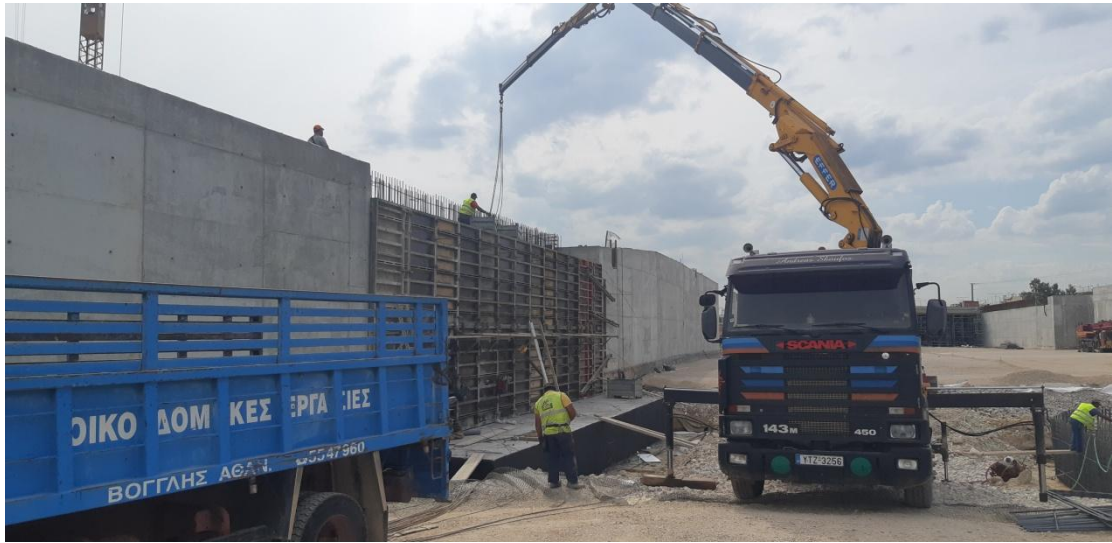
Φωτογραφία 5.6 Σκυροδέτηση τοιχείων.
