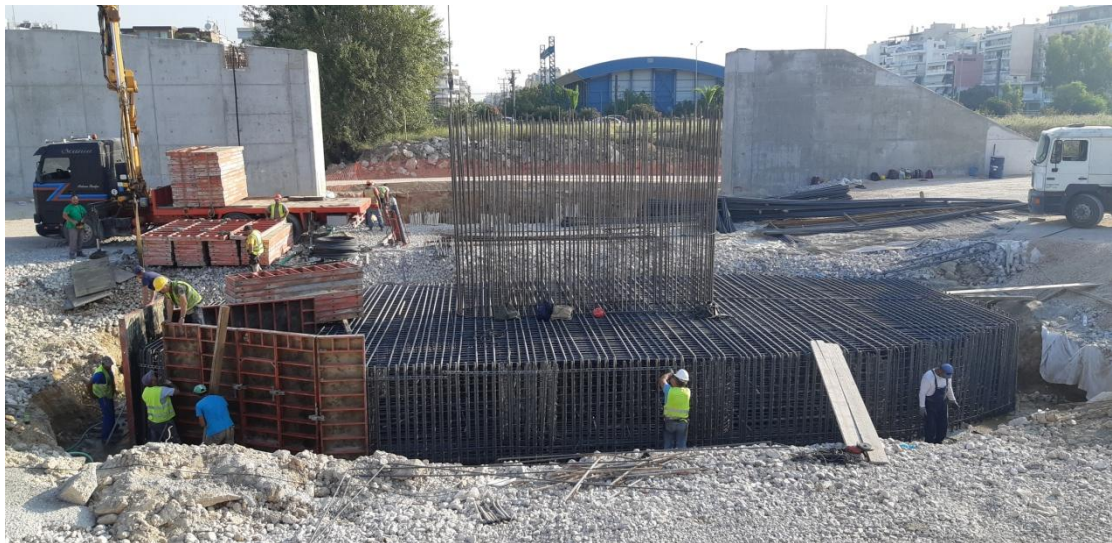
Φωτογραφία 5.11 Οπλισμός θεμελίου μεσόβαθρου.
