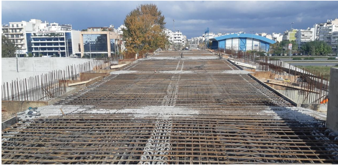
Φωτογραφία 5.50 Άνω οπλισμός διατομής.
