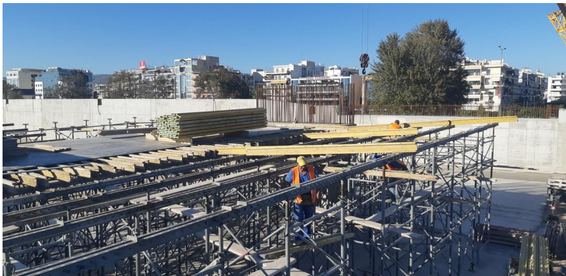
Φωτογραφία 5.28 Τοποθέτηση ξυλότυπου για το κατάστρωμα της γέφυρας.
