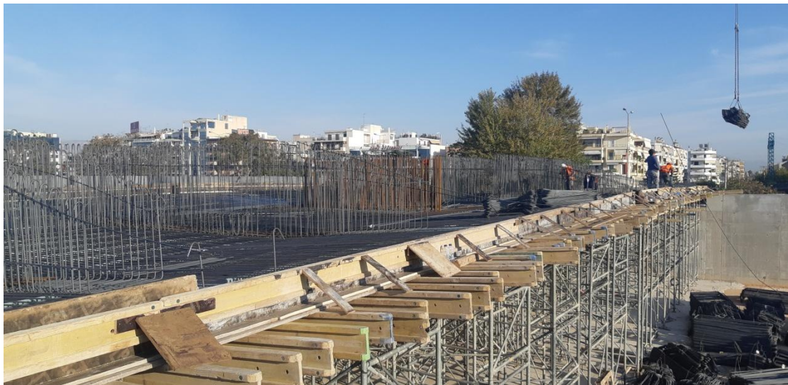
Φωτογραφία 5.32 Τοποθέτηση ξυλότυπου για το κατάστρωμα της γέφυρας.
