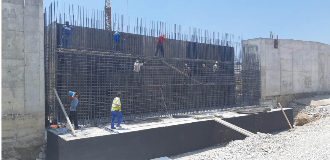
Φωτογραφία 5.4 Οπλισμός κορμού μεσόβαθρου.
