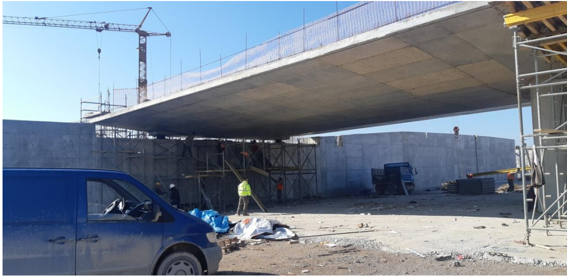
Φωτογραφία 5.54 Πλάκα καταστρώματος.
