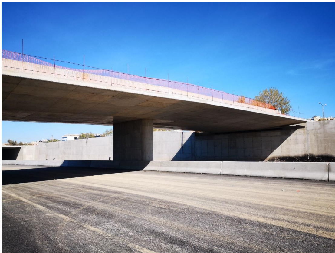
Φωτογραφία 5.59 Όψη γέφυρας (προς το τέλος του έργου).
