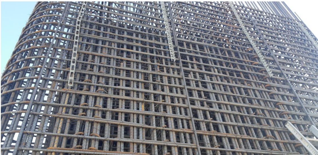
Φωτογραφία 5.15 Οπλισμός κορμού μεσόβαθρου.
