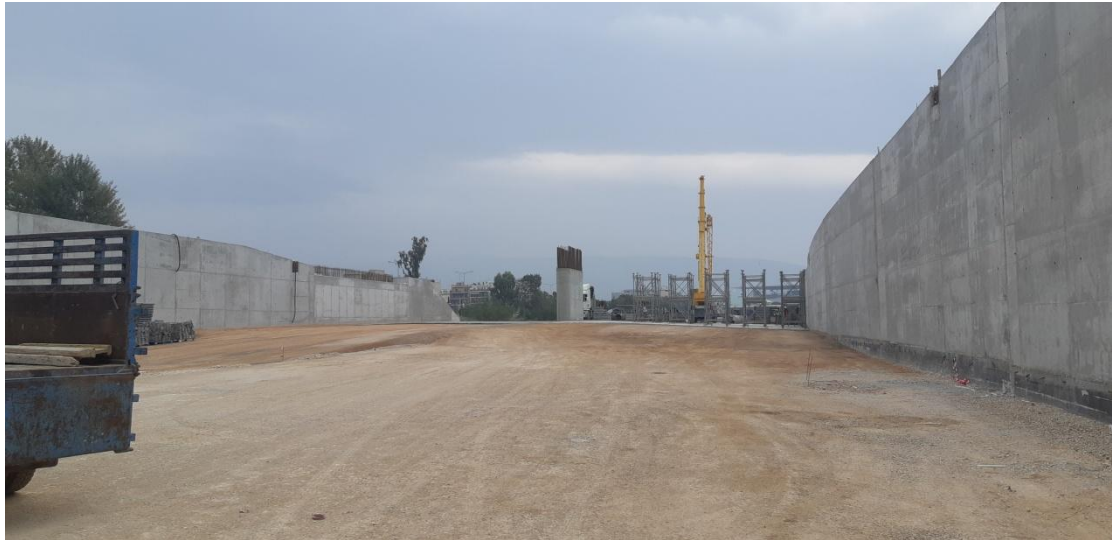
Φωτογραφία 5.25 Τοποθέτηση ικριωμάτων για το καλούπωμα του καταστρώματος.
