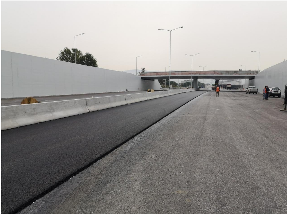
Φωτογραφία 5.60 Τοποθέτηση ασφάλτου.
