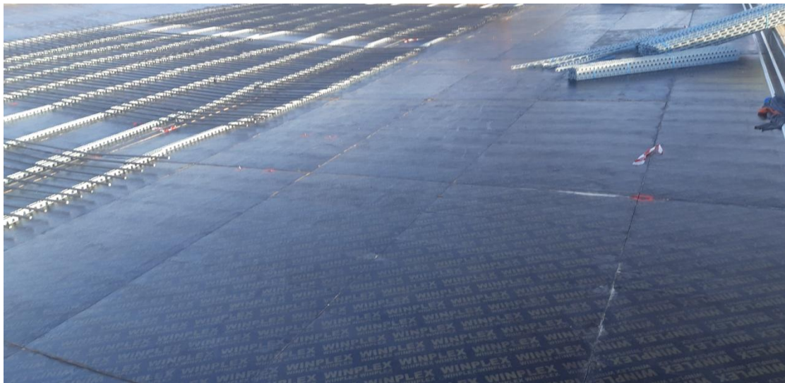
Φωτογραφία 5.30 Τοποθέτηση ξυλότυπου για το κατάστρωμα της γέφυρας.
