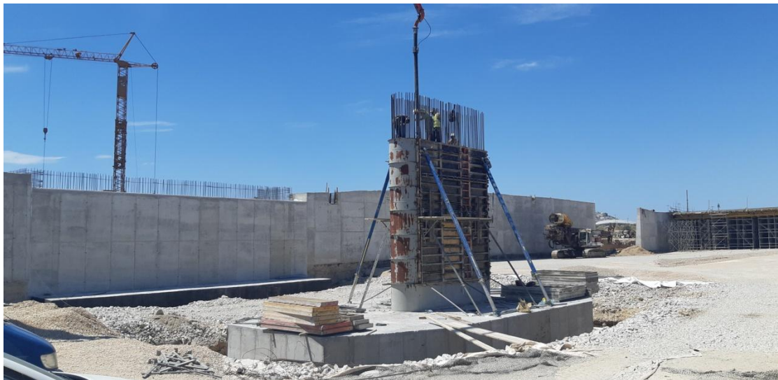
Φωτογραφία 5.17 Σκυροδέτηση κορμού μεσόβαθρου.
