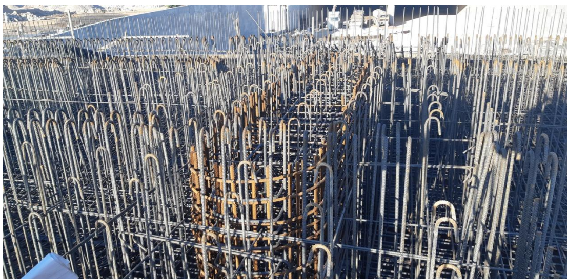
Φωτογραφία 5.40 Οπλισμός διατομής καταστρώματος.
