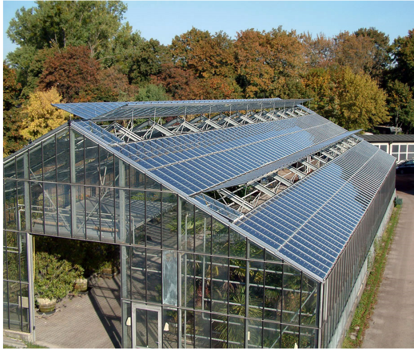
Εικόνα 1.2: Εγκατεστημένα φωτοβολταϊκά σε στέγη θερμοκηπίου, Σάντα Κρούζ, ΗΠΑ
