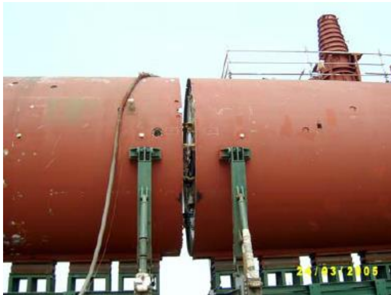
Εικόνα 60: Κοπή Υ/Β ΩΚΕΑΝΟΣ για την προσθήκη του νέου τμήματος
