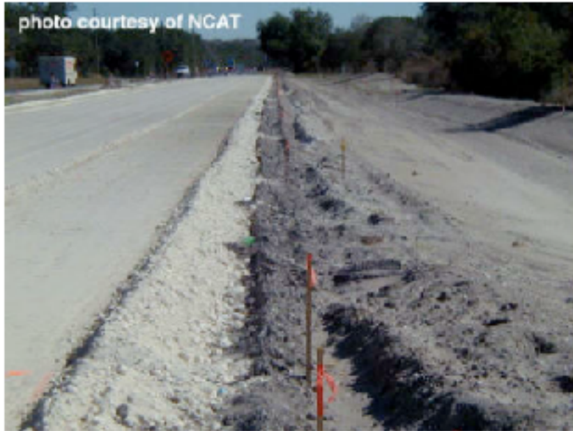
Εικόνα 3. Limerock Base Course Undergoing Final Grading.
