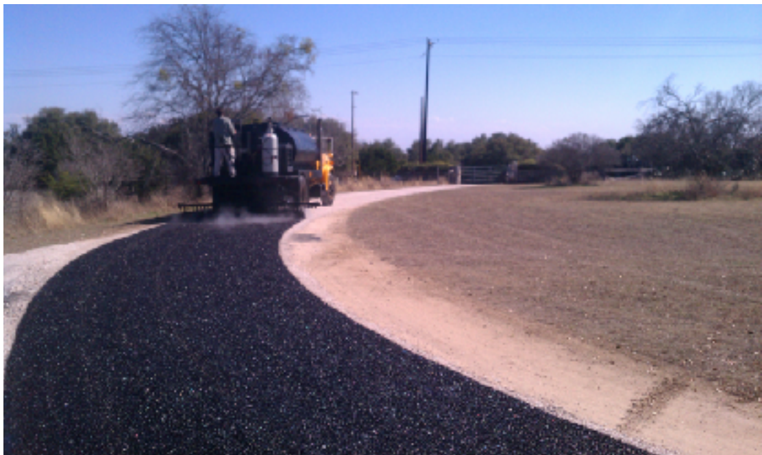
Εικόνα 6. Completed CTB with Curing Seal.
