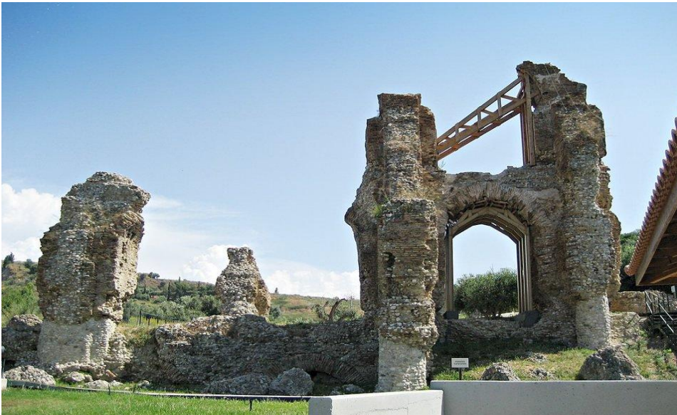
Το ρωμαϊκό υδραγωγείο της Πάτρας. Κατά τους Ρωμαϊκούς χρόνους υδροδοτούσε την πόλη
