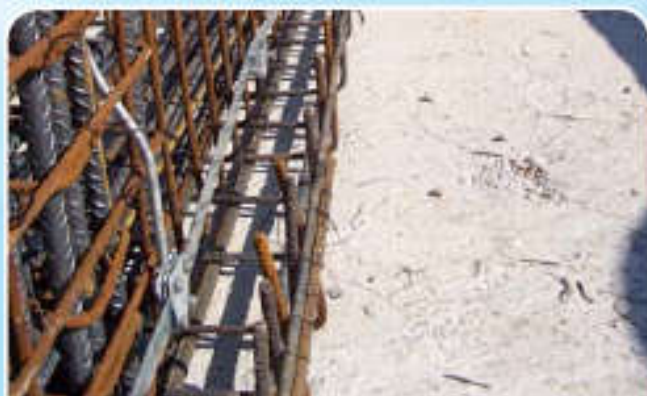
Εγκατάσταση θεμελιακής γείωσης
