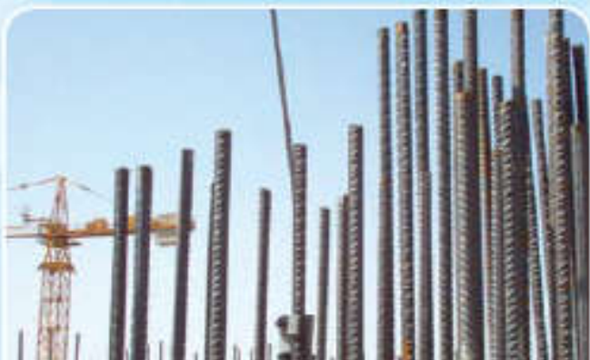
Σύνδεσμος οπλισμού σε αγωγό
