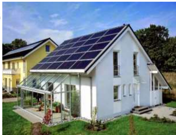
Εικόνα 2: Ηλιακός θερμοσίφωνα. (β) Υβριδικό Συστήματα εγκατεστημένο σε σπίτι (Παθητικό Ηλιακό σύστημα και Φωτοβολταϊκό σύστημα).
