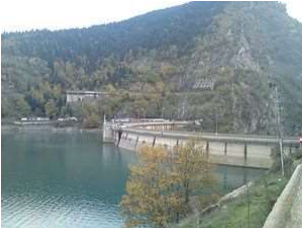
Εικόνα 3:Υδροηλεκτρικό φράγμα στη λίμνη Πλαστήρα.
