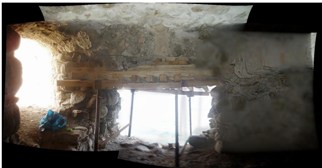
Εικόνα 169: άνοιγμα στη βόρεια όψη
