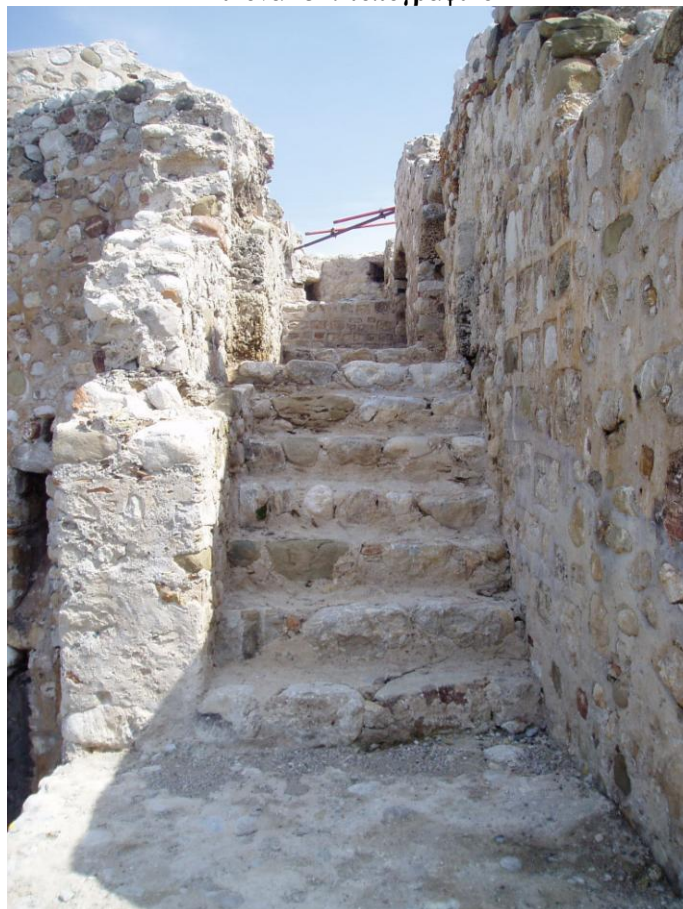
Εικόνα 135: σκάλα που οδηγεί στο δώμα
