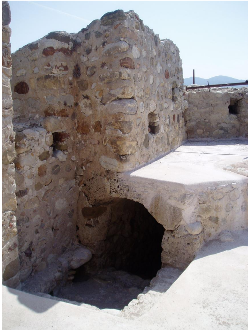
Εικόνα 160: το άνοιγμα που μας οδηγεί στο εσωτερικό του κτιρίου
