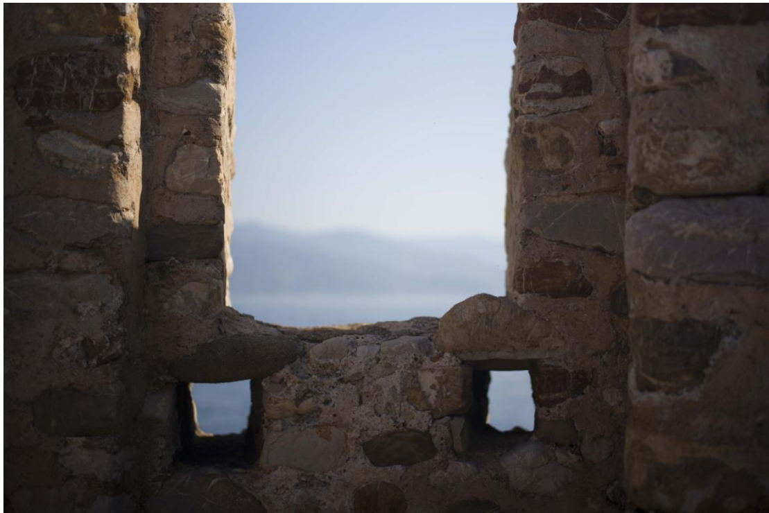
Εικόνα 158: λεπτομέρεια στην εσωτερική βόρεια όψη
