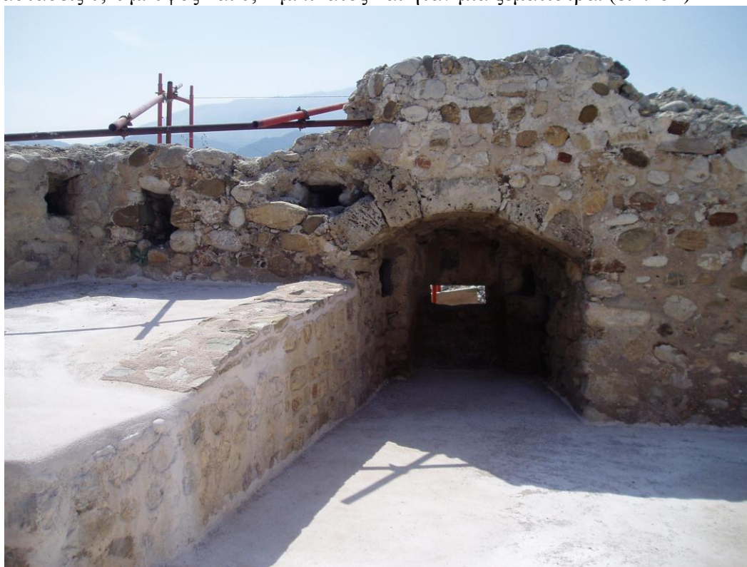
Εικόνα 154: το δεύτερο επίπεδο στην εσωτερική νότιο δυτική όψη
