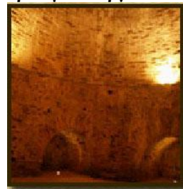
Εικόνα 124:φωτισμένη άποψη του εσωτερικού των τρίδμων πύργων
