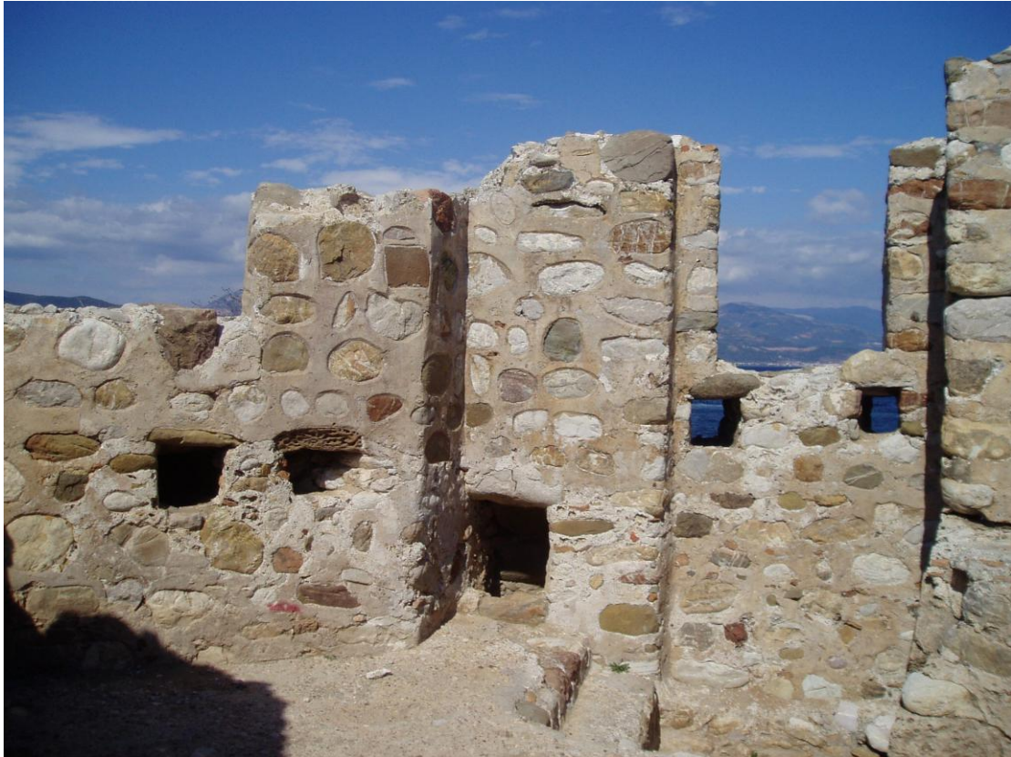
Εικόνα 157: λεπτομέρεια στην εσωτερική βόρεια όψη
