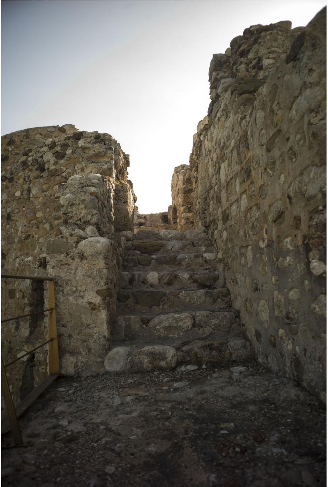
Εικόνα 148: σκάλα που οδηγεί στο δώμα
