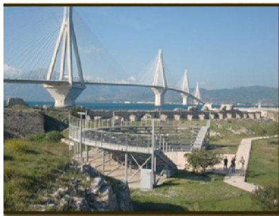
Εικόνα 131: μεταλική κατασκευή κερκίδας για πραγματοποίηση ποικιλόμορφων πολιτιστικών εκδηλώσεων
