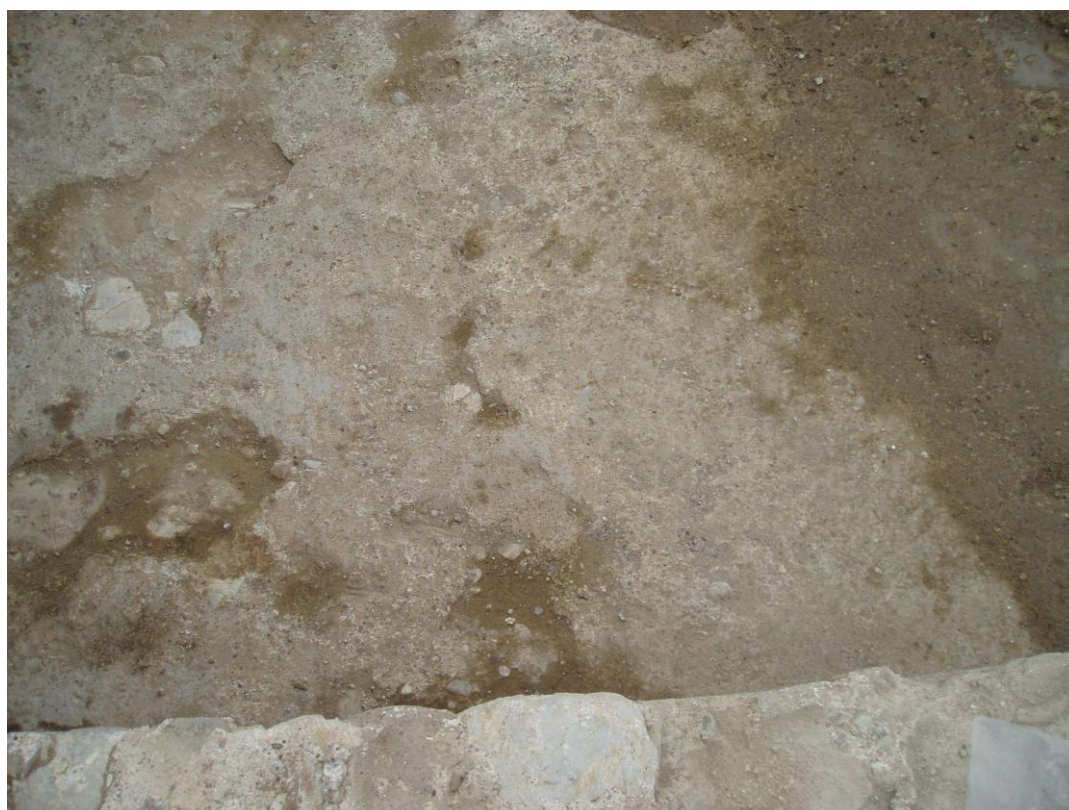
Εικόνα 138:κομμάτι από το δάπεδο δώματος
