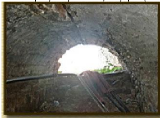
Εικόνα 85: στοά στην ανατολική πλευρά
