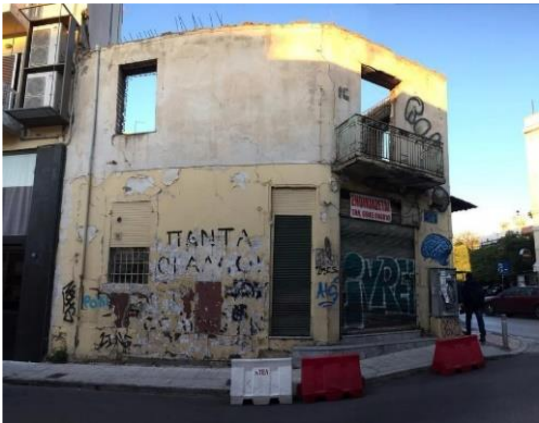
Εικόνα 3.18.,3.19.: Πρόσοψη κτιρίου επί της Οδού Ζαΐμη
