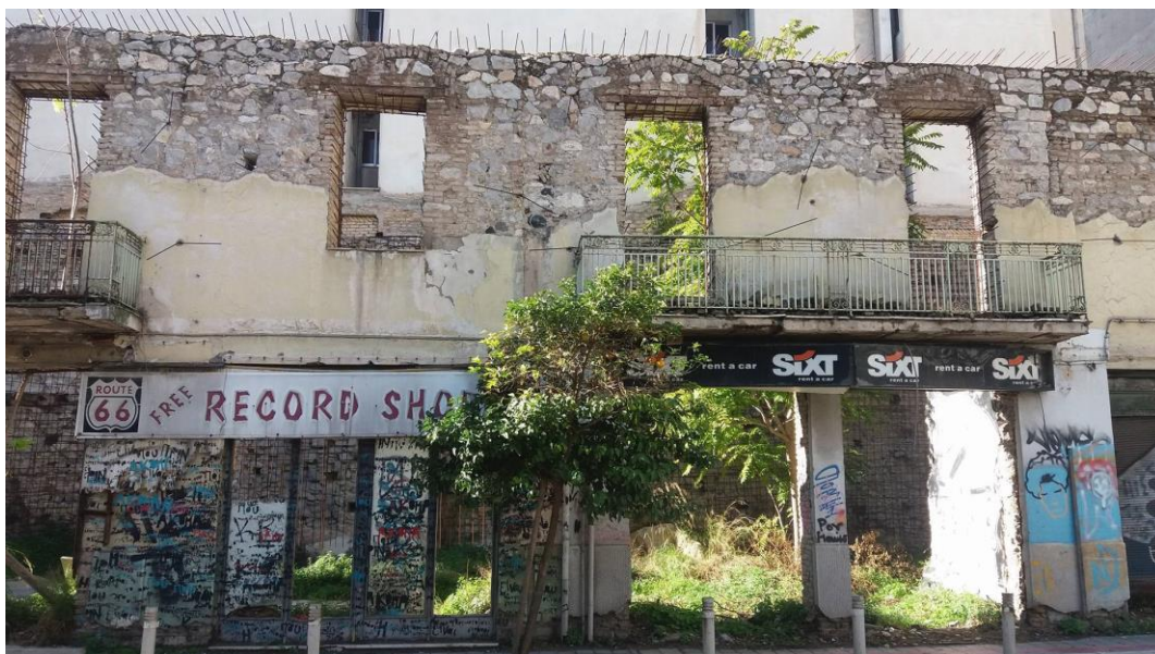
Εικόνα 3.2 Πρόσοψη κτιρίου επί της οδού Αγίου Ανδρέου
