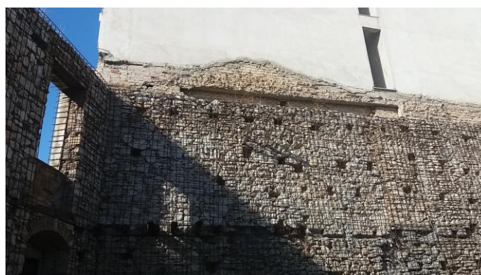
Εικόνες 3.25, 3.26: Άποψη εσωτερικής πλευράς της λιθόκτιστης τοιχοποιίας και ίχνη στεγών
