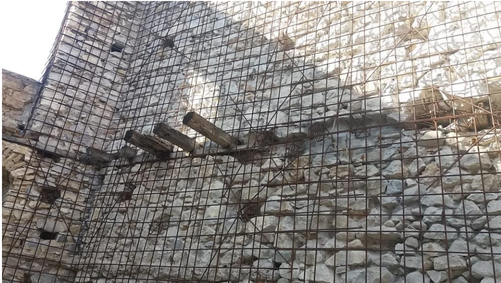
Εικόνες 3.27: Εσωτερική εσωτερικής πλευράς της λιθόκτιστης τοιχοποιίας
