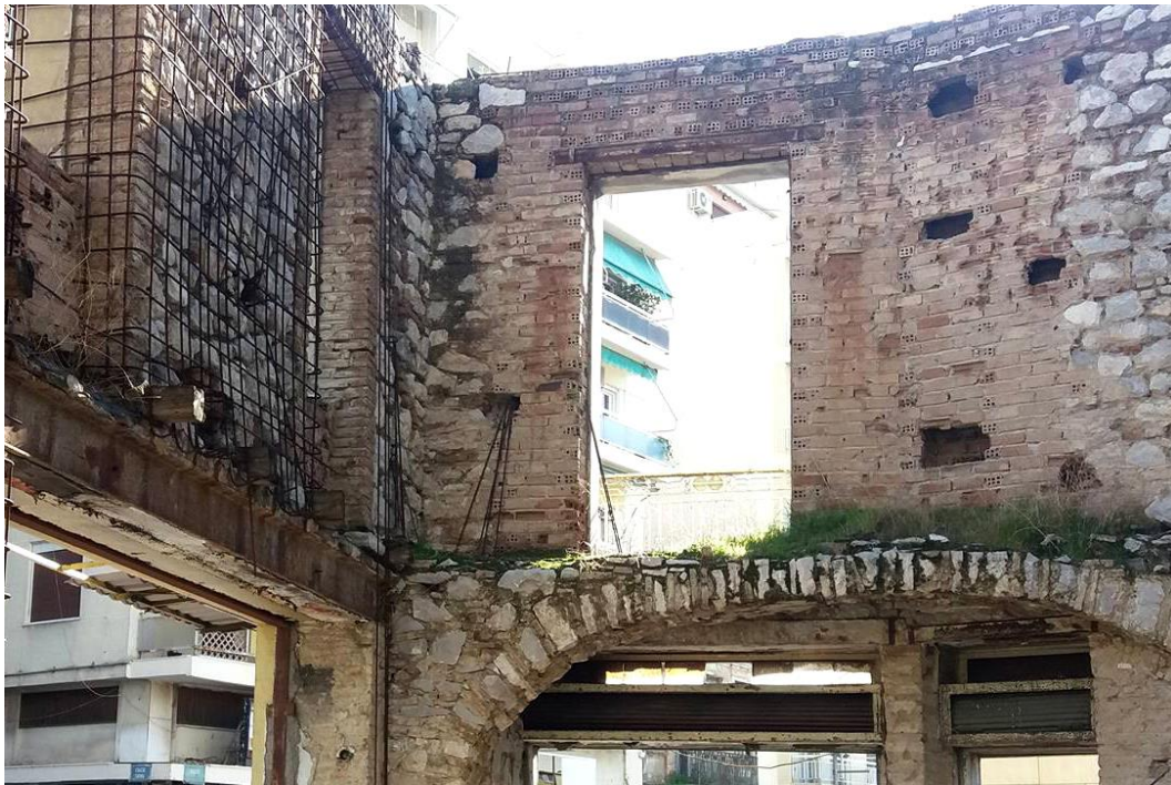
Εικόνα 3.16.: Δείγμα προσπάθειας αποκατάστασης με βιομηχανικό τούβλο
