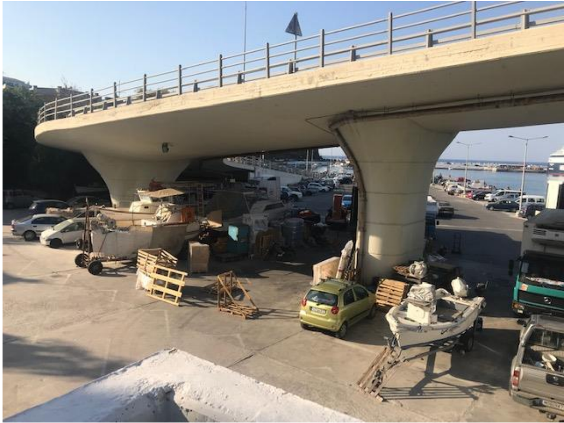
Εικόνα 5.2 Πλαϊνή όψη της γέφυρας.
