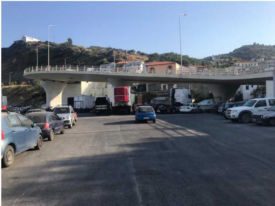
Εικόνα 5.1 Γενική όψη της γέφυρας.
