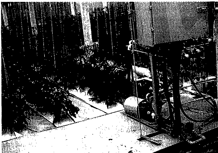
Εικ. 7 Αντλία ανακύκλωσης θρεπτικού διαλύματος σε καλλιέργεια με το σύστημα της μεμβράνης του θρεπτικού διαλύματος (NFT)
