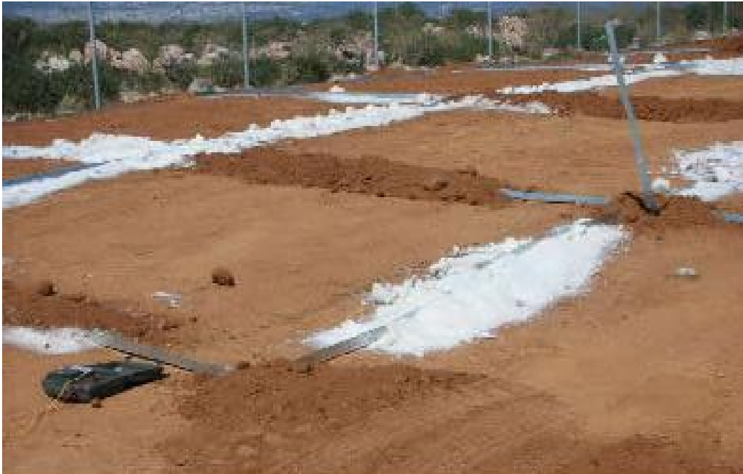
Εικόνα 3.3 πλέγμα γείωσης εγκιβωτισμένο σε αλάτι [16]
