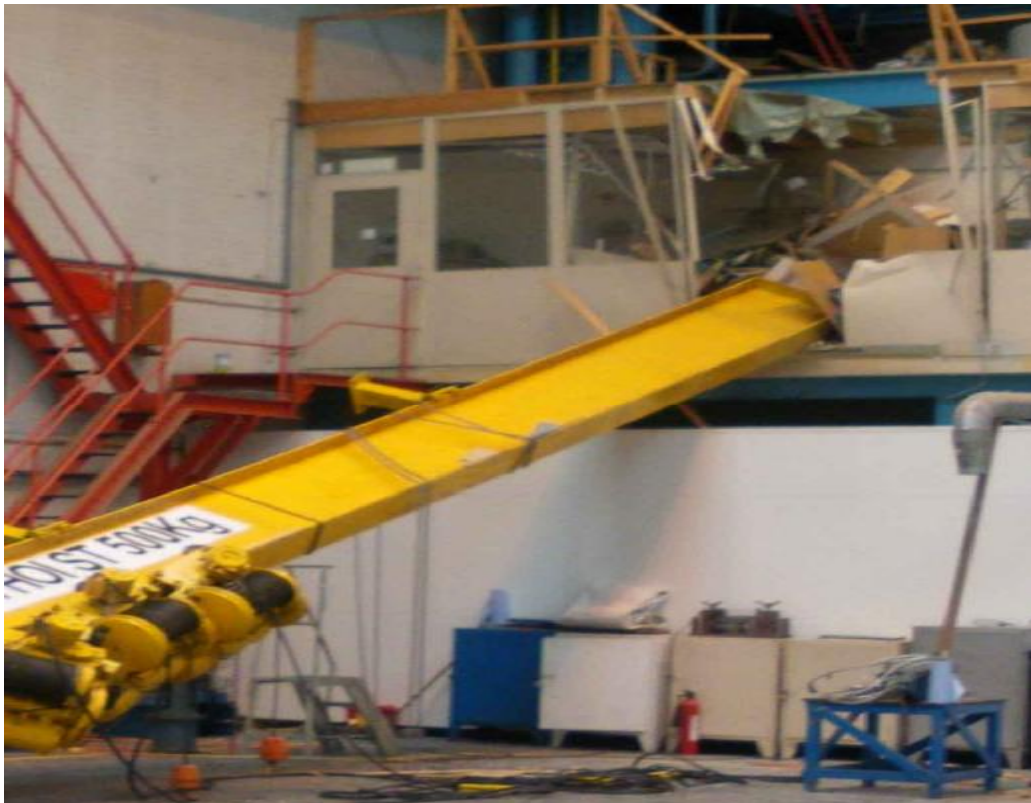
Εικόνα 3.1ii : Υπερφόρτωση γερανογέφυρας. Πηγή: google.com
