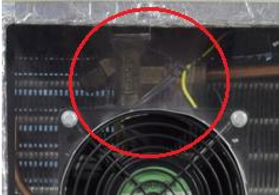
ΕΙΚΟΝΑ 6.6 Εκτονωτική διάταξη πριν τον εξατμιστή αέρα
