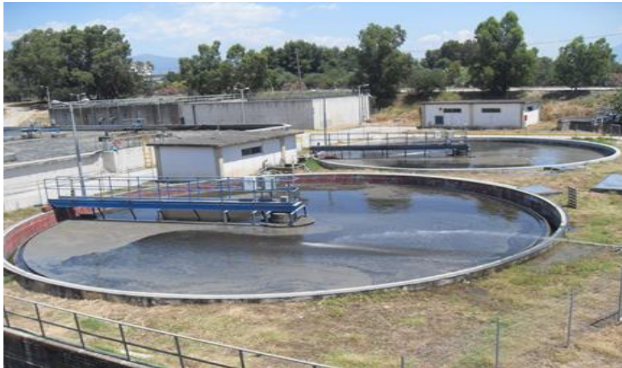
Εικόνα 1.5: Δεξαμενή καθίζησης
