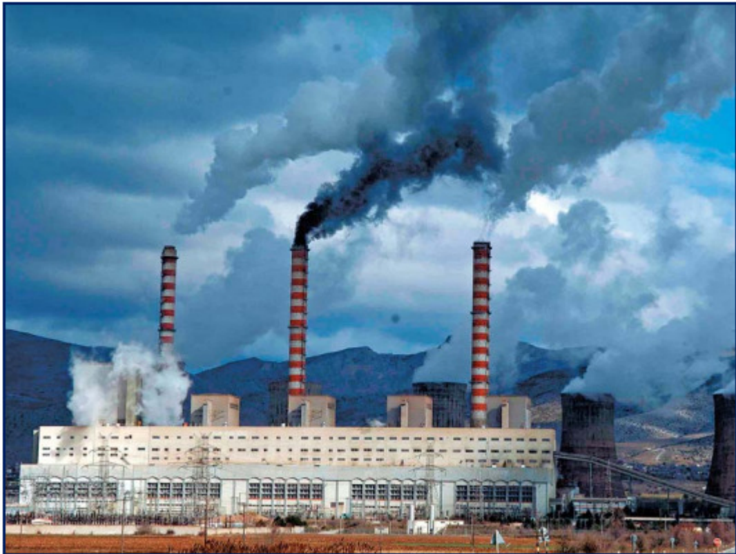
Εικόνα 3: Αέριες εκπομπές από σταθμό παραγωγής ηλεκτρικής ενέργειας.
