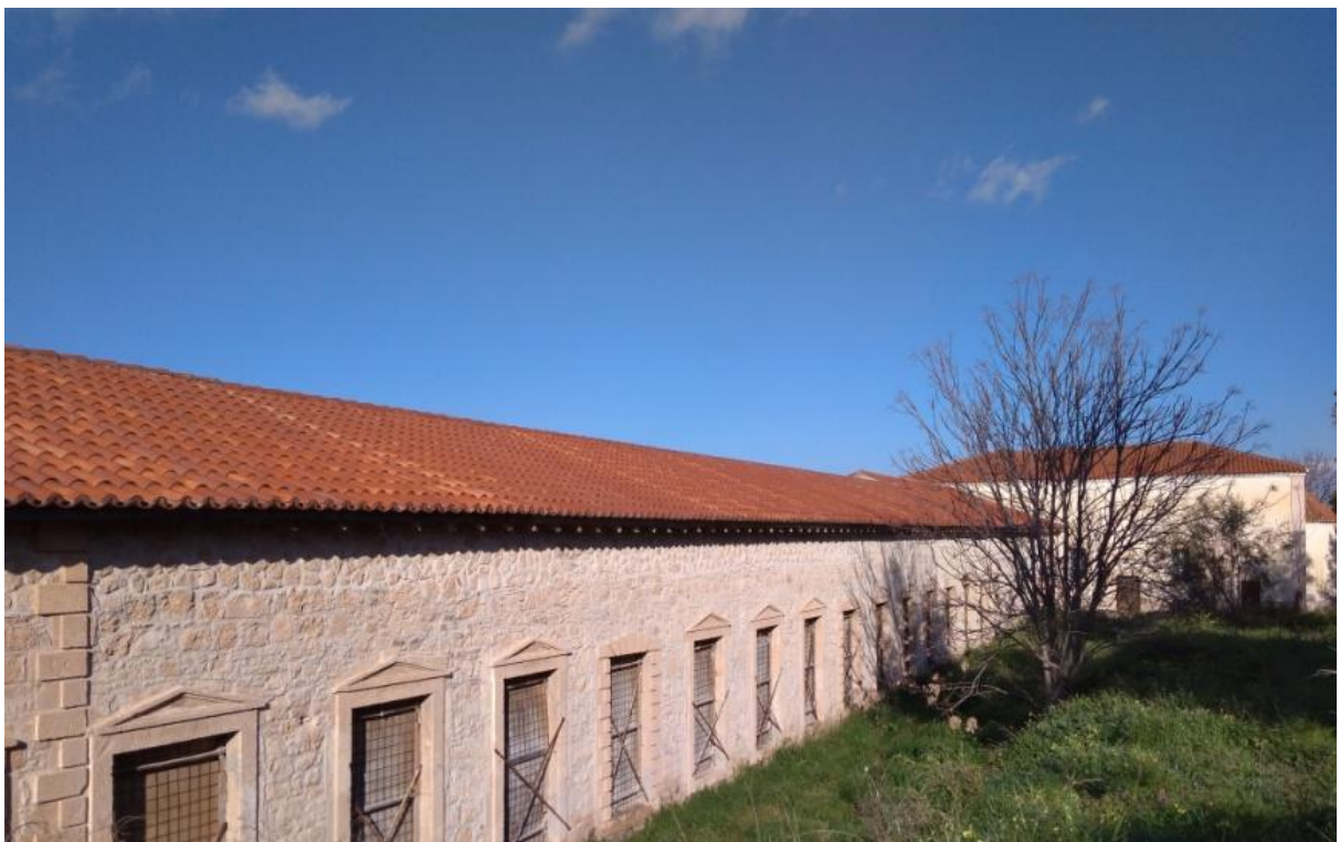
Εικόνα 8: Φωτογραφία της ανατολικής πλευράς του κτιρίου.
