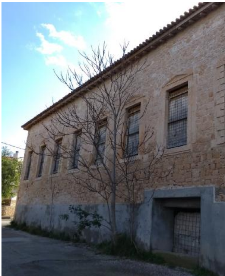
Εικόνα 2: Φωτογραφία της βόρειας πλευράς του κτιρίου.
