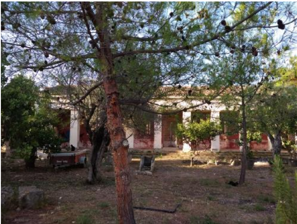
Εικόνα 5: Το Κεντρικό Σχολείο - Εϋνάρδειο στην Αίγινα.
