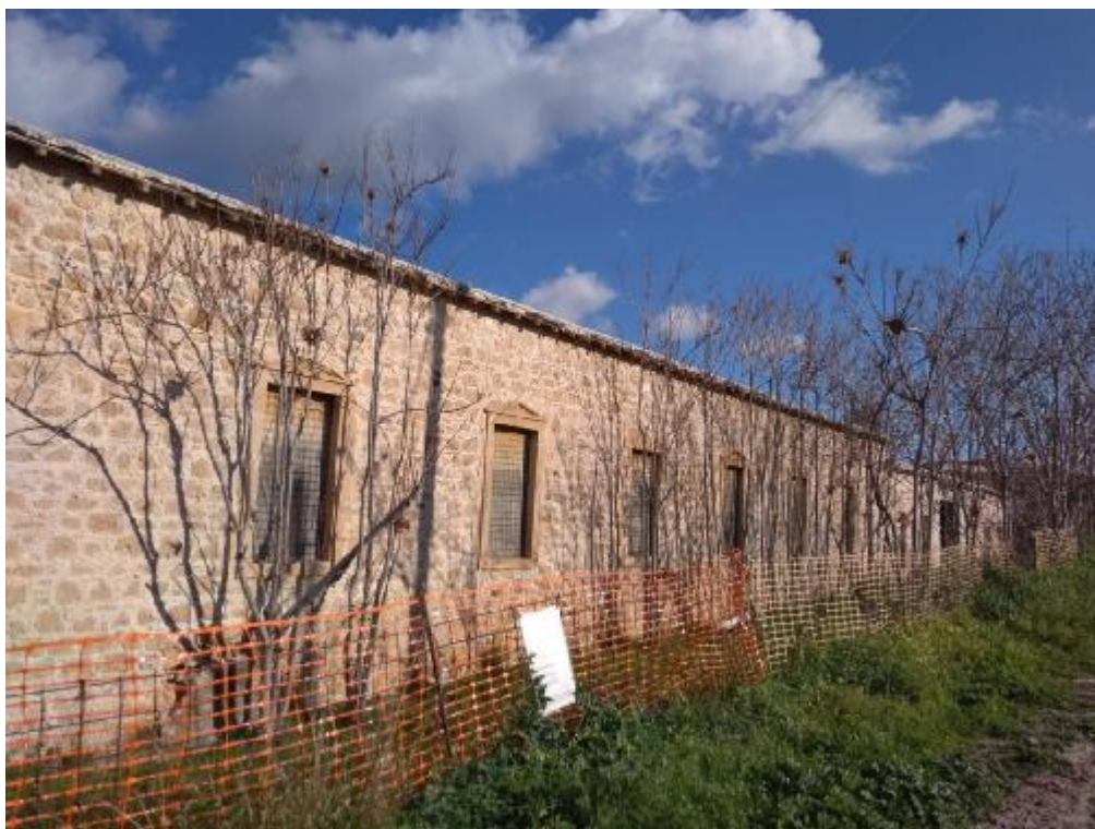
Εικόνα 6: Φωτογραφία της νότιας πλευράς του κτιρίου.
