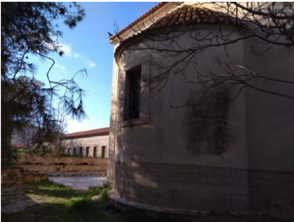
Εικόνα 12: Φωτογραφία της εξωτερικής πλευράς της εκκλησίας και του εξωτερικού προαυλίου του κτιρίου.
