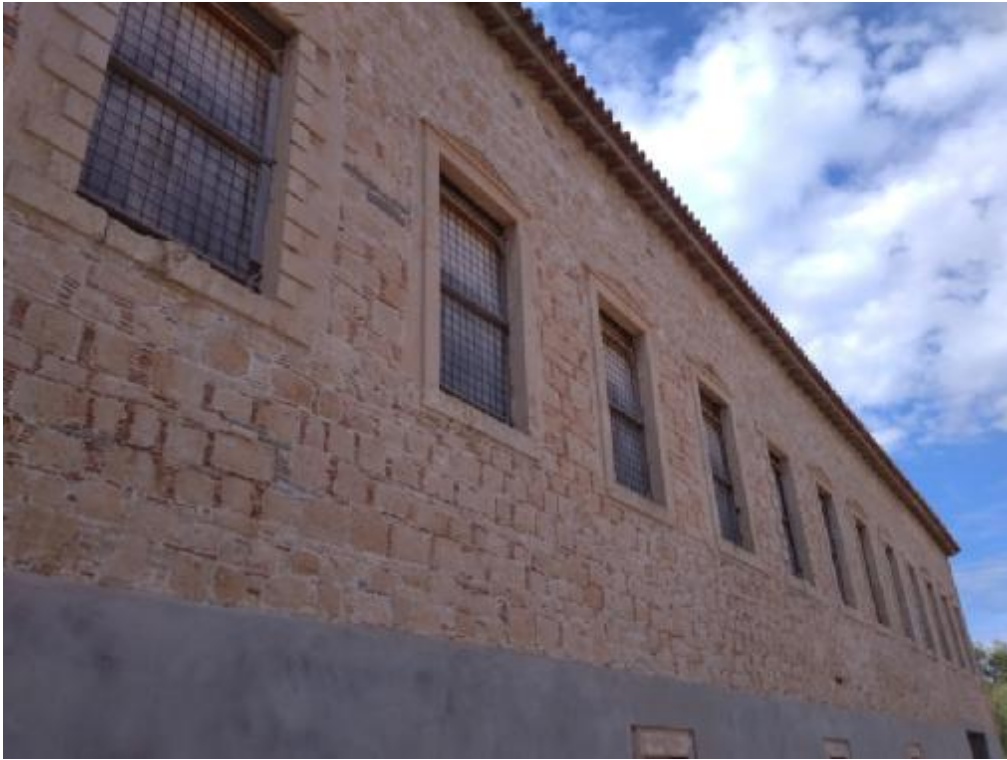
Εικόνα 3: Φωτογραφία της βόρειας πλευράς του κτιρίου.
