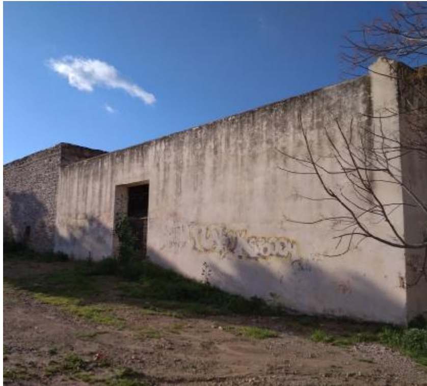
Εικόνα 9: Φωτογραφία της ανατολικής πλευράς του κτιρίου.
