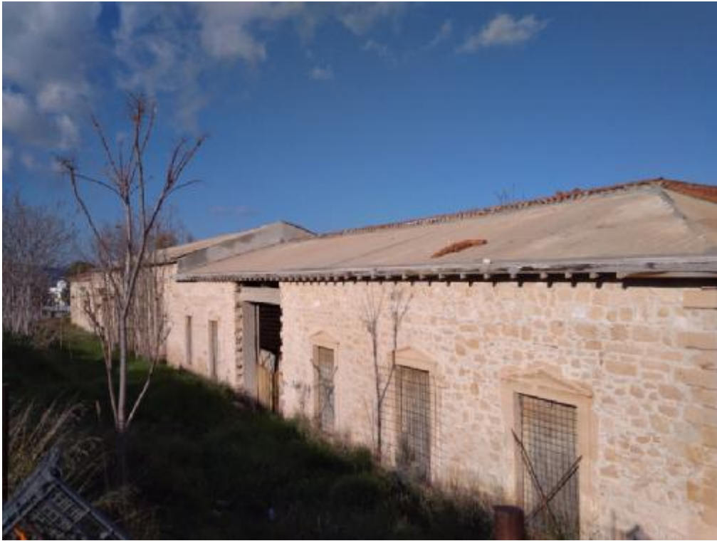
Εικόνα 7: Φωτογραφία της νότιας πλευράς του κτιρίου.
