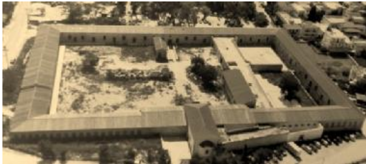
Εικόνα 1: Αεροφωτογραφία του Κτιρίου από την ανατολική πλευρά.
