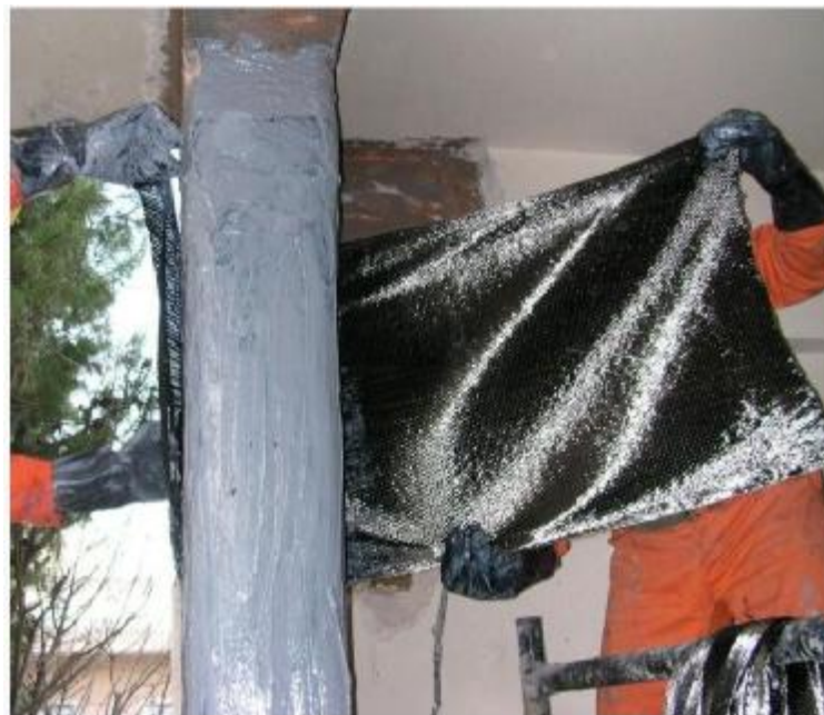
Εικόνα 3.2: Τοποθέτηση υφασμάτων σε στοιχεία οπλισμένου σκυροδέματος. 42
