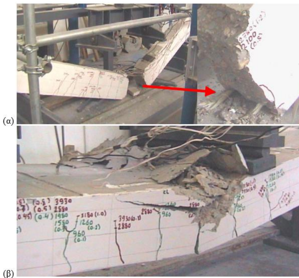
Εικόνα 4.1: Αστοχία σε κάμψη δοκών οπλισμένου σκυροδέματος με ΙΩΠ: (α) σύνθλιψη του σκυροδέματος και (β) εφελκυστική αστοχία του διαμήκους οπλισμού. 2
