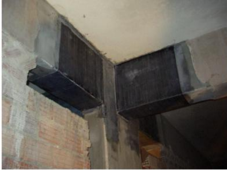
Εικόνα 3.3: Εφαρμοσμένα υφάσματα σε στοιχεία οπλισμένου σκυροδέματος. 42
