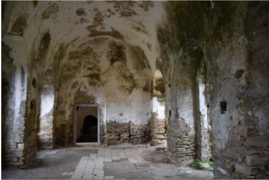
Εικόνα 4 : Φωτογραφία ισογείου κεντρικής αίθουσας κεντρικού κτιρίου.
