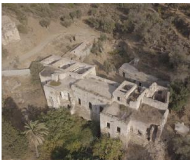
Εικόνα 2: Αεροφωτογραφία δυτικής πρόσοψης κεντρικού κτιρίου.
