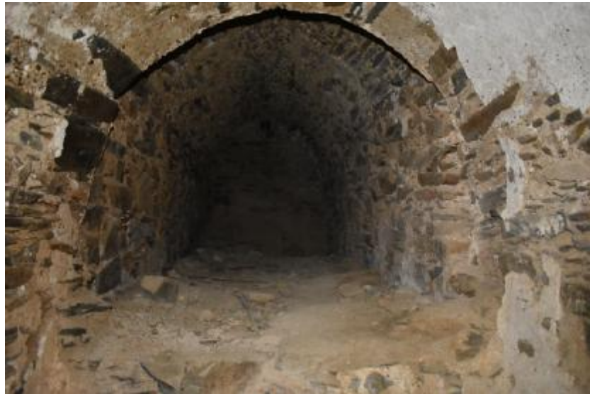
Εικόνα 18: Φωτογραφία νοτιοδυτικού ανοίγματος υπογείου.
