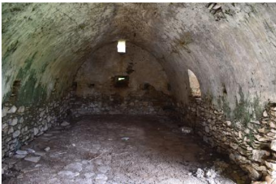
Εικόνα 27: Φωτογραφία εσωτερικού τμήματος βορειοανατολικού βοηθητικού χώρου.
