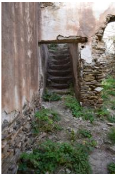
Εικόνα 13: Φωτογραφία βορειοανατολικού κλιμακοστασίου που οδηγεί στον επάνω όροφο στην βορειοανατολική πλευρά κεντρικού κτιρίου.
