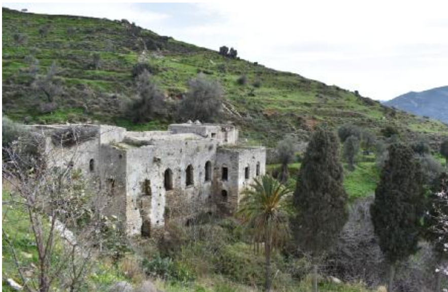
Εικόνα 1: Φωτογραφία δυτικής πρόσοψης κεντρικού κτιρίου.
