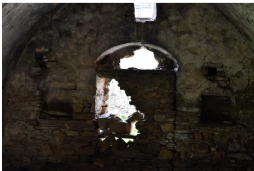
Εικόνα 28: Φωτογραφία εσωτερικού τμήματος βορειοανατολικού βοηθητικού χώρου (δυτικός τοίχος).
