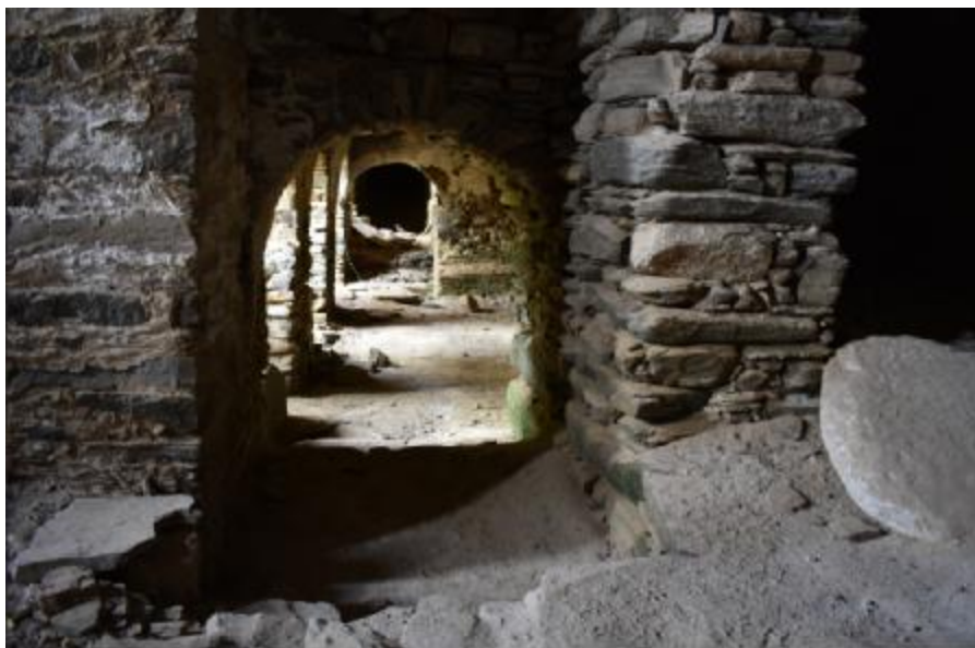
Εικόνα 19 : Φωτογραφία βόρειου τμήματος υπογείου.
