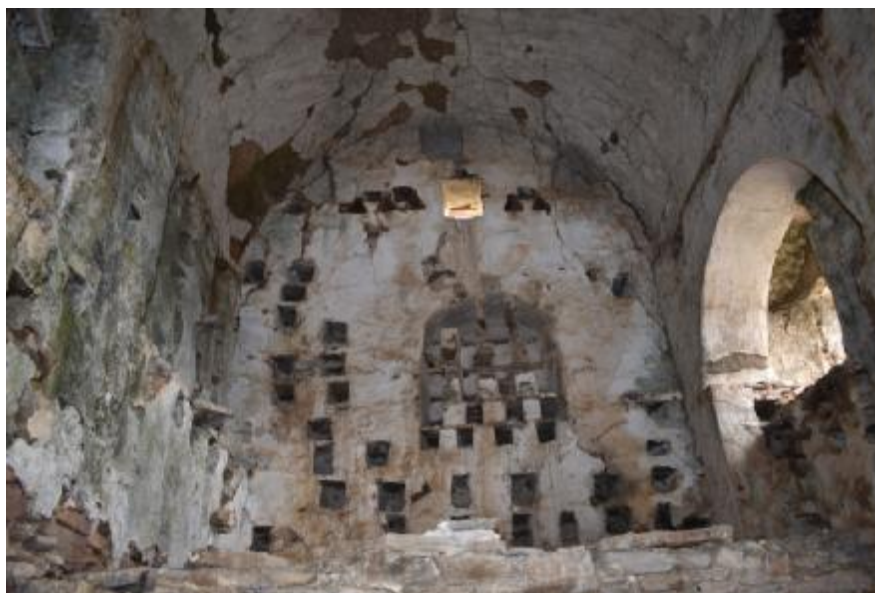
Εικόνα 25: Φωτογραφία εσωτερικό περιστεριώνα.
