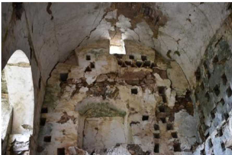
Εικόνα 24: Φωτογραφία εσωτερικό περιστεριώνα.
