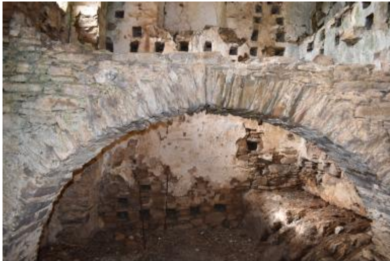
Εικόνα 23: Φωτογραφία εσωτερικό περιστεριώνα.
