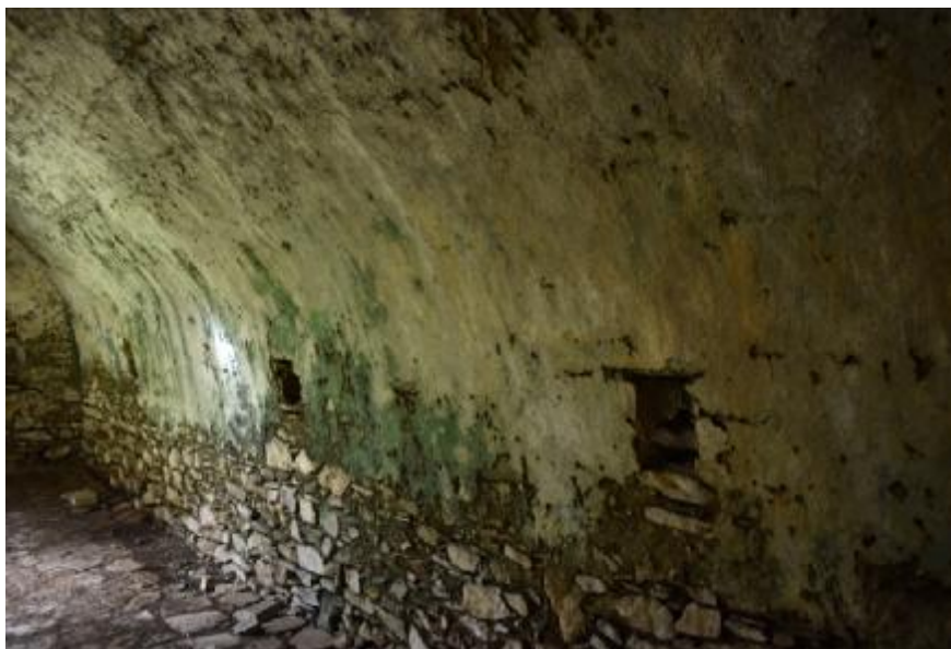
Εικόνα 34: Φωτογραφία εσωτερικού τμήματος βορειοανατολικού βοηθητικού χώρου.
