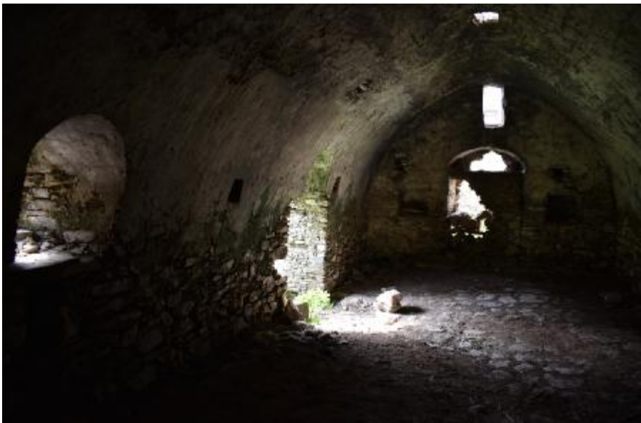
Εικόνα 36: Φωτογραφία εσωτερικού τμήματος βορειοανατολικού βοηθητικού χώρου.
