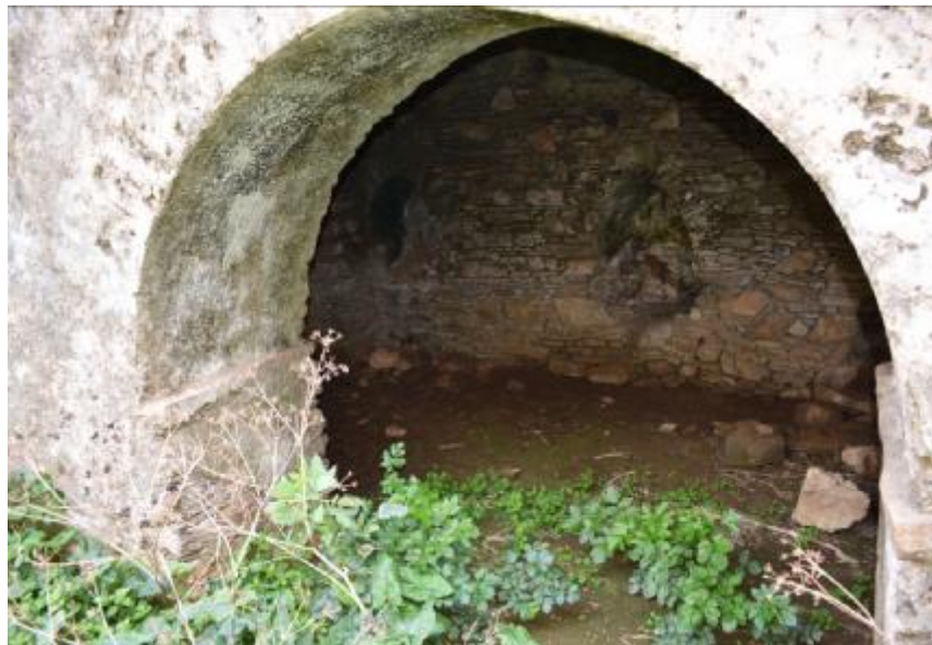
Εικόνα 33: Φωτογραφία νοτιότερου τμήματος νοτιοανατολικού βοηθητικού χώρου.
