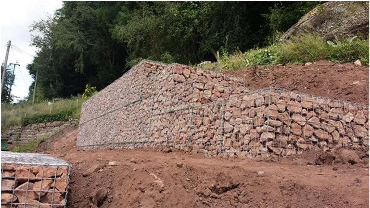
Εικόνα 2. Συρματοκιβώτια με πέτρες.
