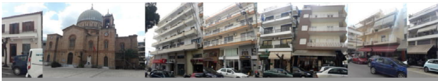
κόνα 21 Φωτογραφική απεικόνιση της Νότιας όψης της οδού Μητροπόλεως
