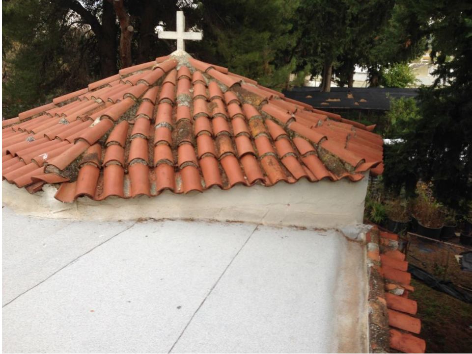
Εικόνα 13. Θόλος παλιού ναού. Ο θόλος του παλιού ναού έχει καλυφθεί με κατασκευή που σχηματίζει εξάγωνο και φέρει κεραμίδια.
