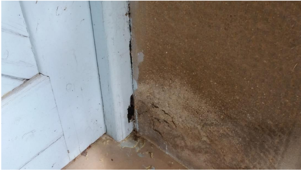
Εικόνα 27. Θύρα. Όλες οι θύρες της εκκλησίας είναι σπασμένες και μερικώς σαπισμένες.
