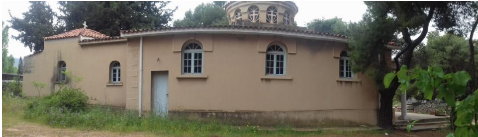
Εικόνα 11. Πανοραμική άποψη της βόρειας όψης. Παρατηρείται άριστη δεξιοτεχνία στο αρτιφισιέλ.
