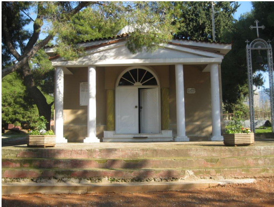
Εικόνα 8. Δυτική όψη. Η κύρια είσοδος του ναού γίνεται από την δυτική πλευρά, ενώ υπάρχουν δύο ακόμη θύρες στα βόρεια και νότια του ναού.
