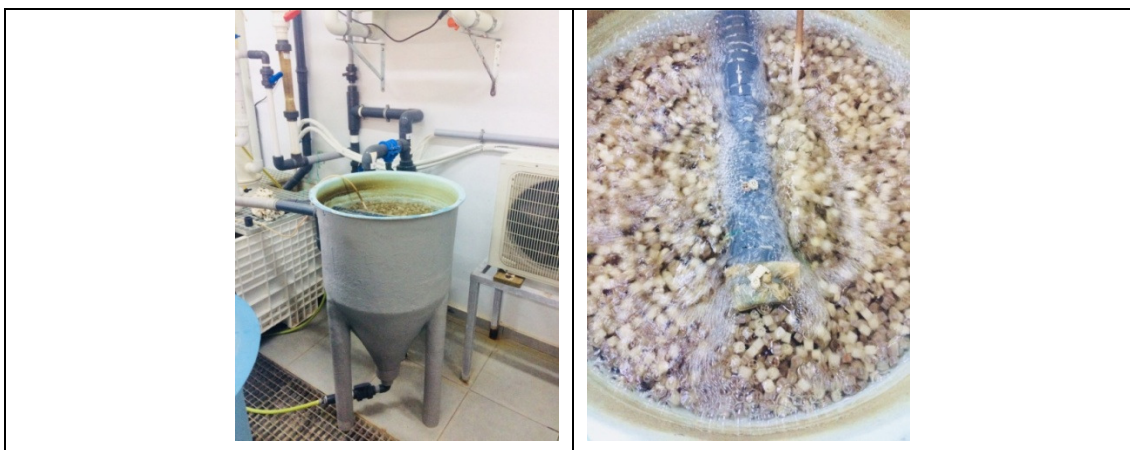
Εικόνα 16 Προσθετο submerged βιοφίλτροσε λειτουργία (αριστερά) με υλικό Biofilm Carrier Elements (δεξιά)
