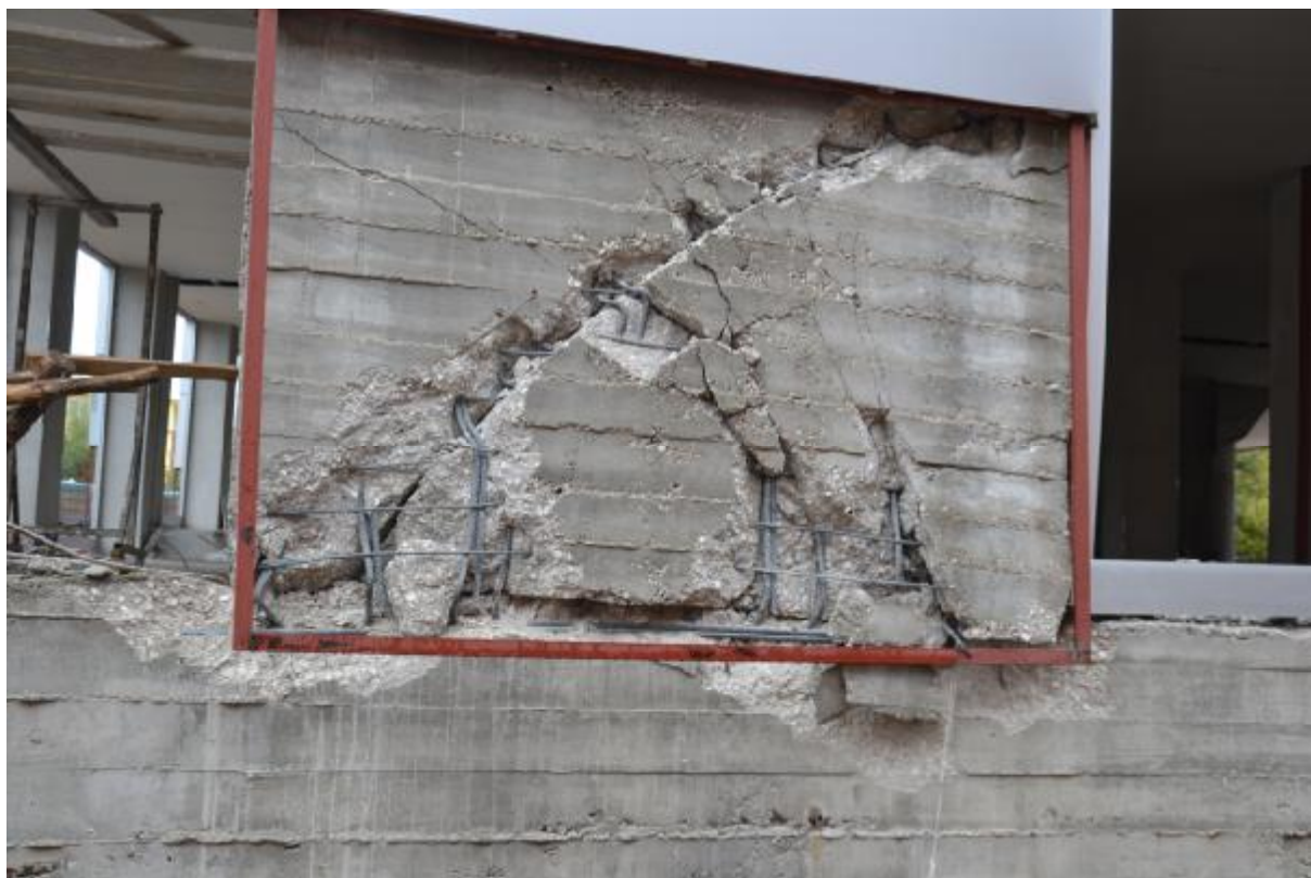
Σχήμα 6: Διατμητική βλάβη τοιχώματος ( http://www.eqclearinghouse.org ).
