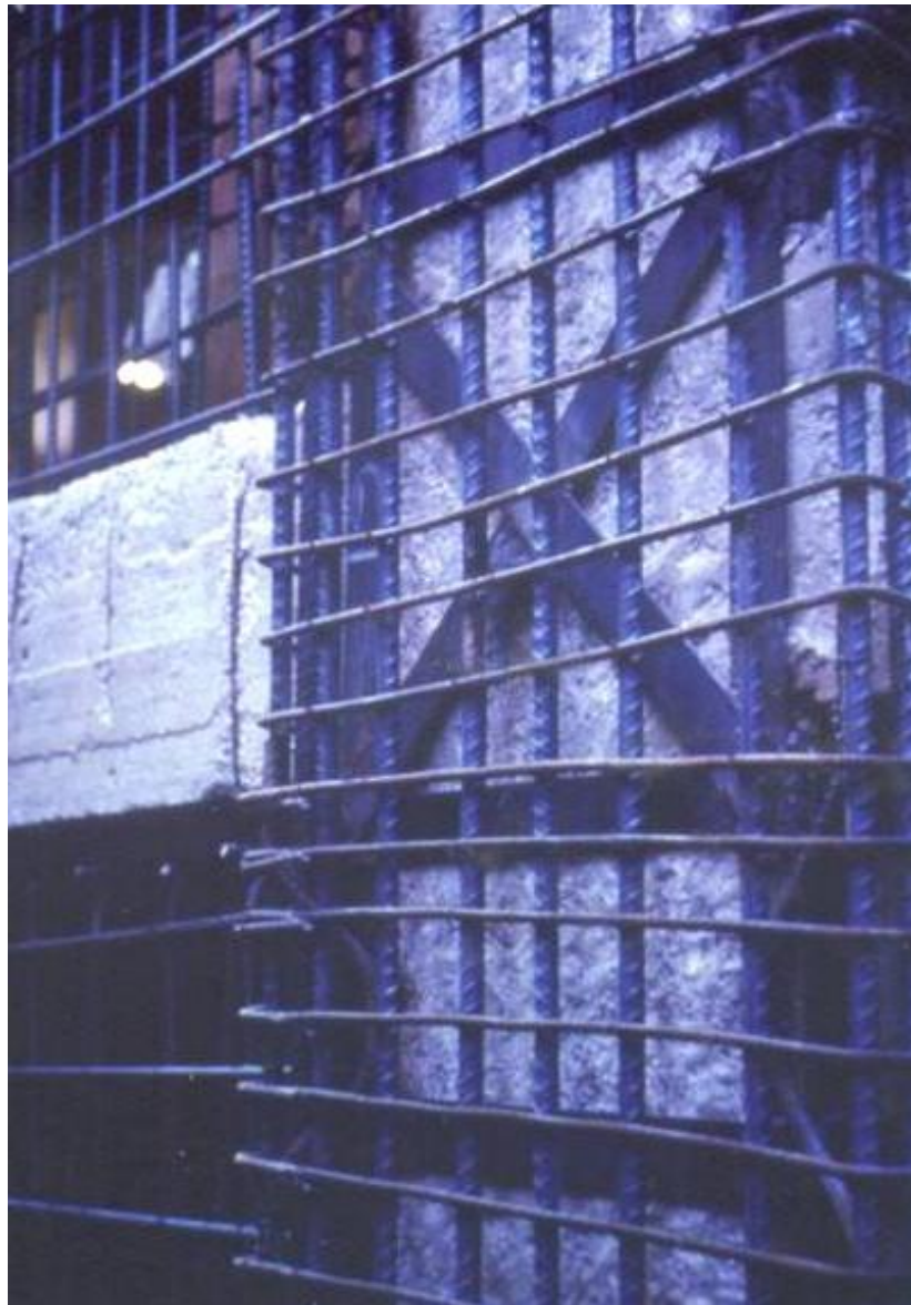
Σχήμα 13: Προσθήκη χιαστί κολλάρων από χαλύβδινα στοιχεία (Στέφανος Δρίτσος, Επεμβάσεις και ενισχύσεις σε υφιστάμενες κατασκευές, 2009).
