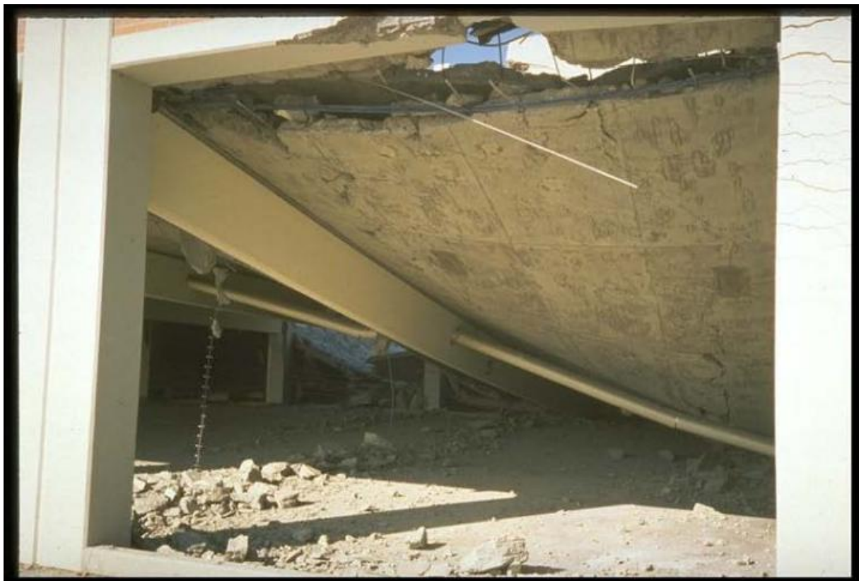
Σχήμα 10: Βλάβες σε πλάκες χώρου στάθμευσης. Η πλάκα ξεκόλλησε από το περιβάλλον πλαίσιο. Σεισμός του Northridge, 1994 ( https://eclass.teicrete.gr/modules/document/ ).
