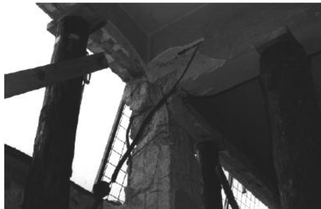
Σχήμα 5: Βλάβη σε ακραίο κόμβο (αριστερά) και σε μεσαίο κόμβο (δεξιά) [10].
