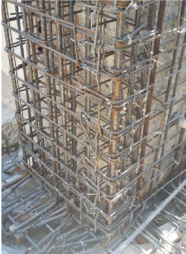
Σχήμα 11: Ενίσχυση υφιστάμενης οικίας με μανδύες Οπλισμένου Σκυροδέματος ( https://thedesignteam.eu/projects/enisxisi-ifistamenis-oikias )
