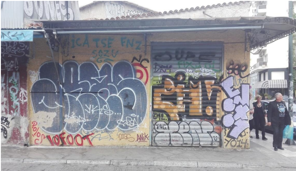
Εικόνα 21: Δυτική Όψη 1(Είσοδος από Ερμού)
