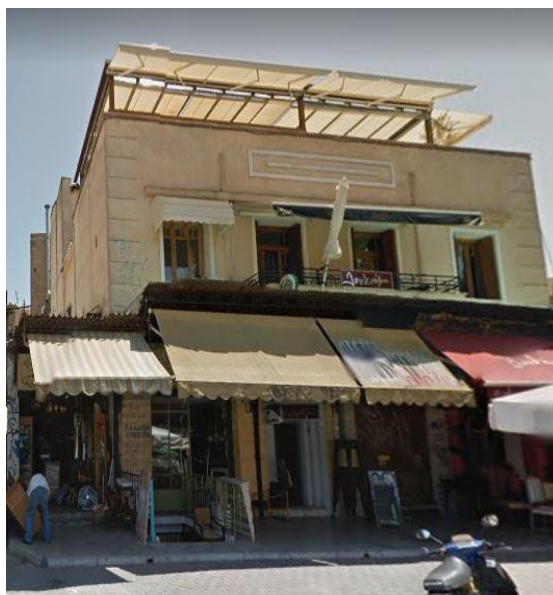
Εικόνα 12: Διατηρητέο κτίριο(Αβησσυνίας 3)-ξύλινα κουφώματα
