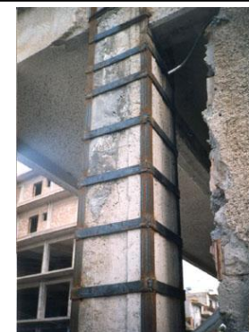
Εικόνα 62:Ενίσχυση υποστυλωμάτων με χαλύβδινες λάμες
