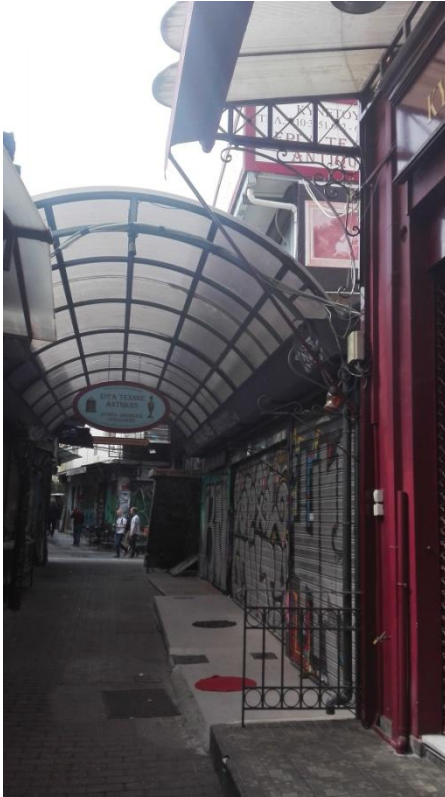
Εικόνα 35:Τμήμα Δυτικής Όψης 2
