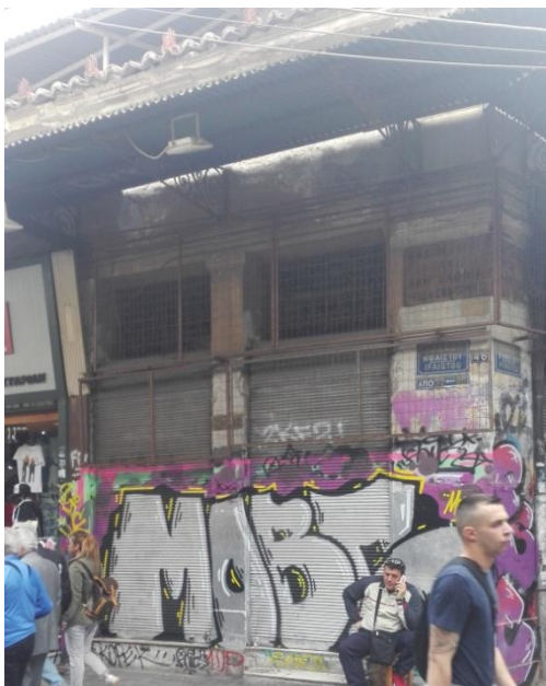
Εικόνα 38:Τμήμα Νότιας Όψης 1
