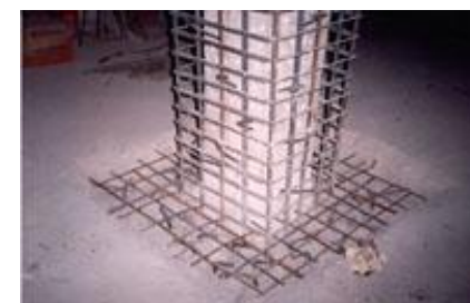
Εικόνα 61:Κατασκευή μανδύα από οπλισμένο σκυρόδεμα
