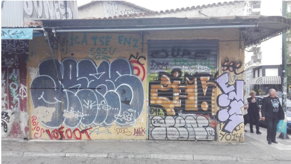
Εικόνα 9: Τμήμα Κεραμοσκεπής στην είσοδο της πλατείας
