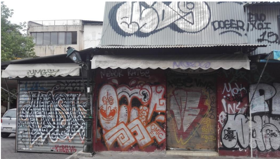
Εικόνα 23: Δυτική Όψη 1(Είσοδος από Ερμού)
