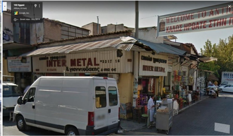
Εικόνα 10: Τμήμα Κεραμοσκεπής στην είσοδο της πλατείας
