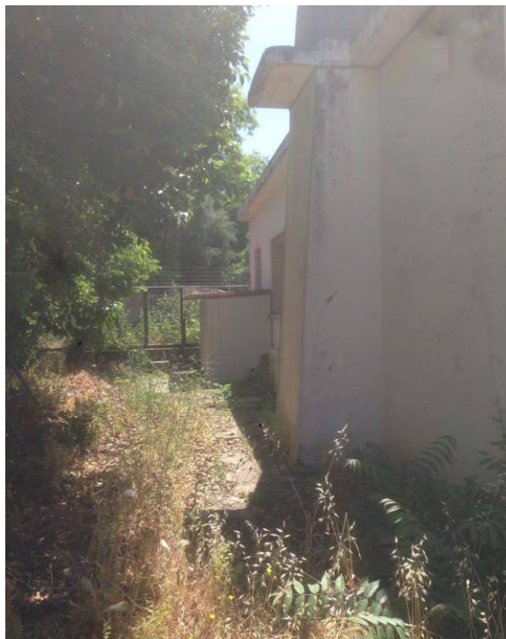
Εικόνα 4. Αριστερή πλάγια όψη κτιρίου.
