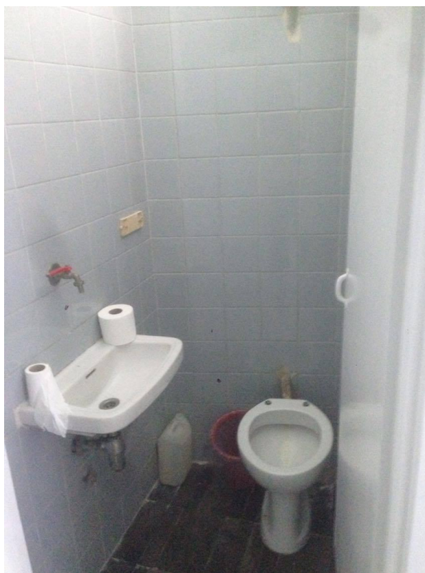
Εικόνα 9. Εσωτερικός χώρος, wc.
