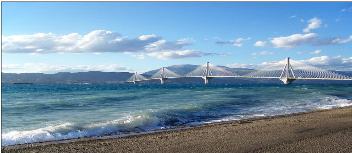
Εικόνα 2.12 Η γέφυρα Ρίου-Αντιρρίου.
