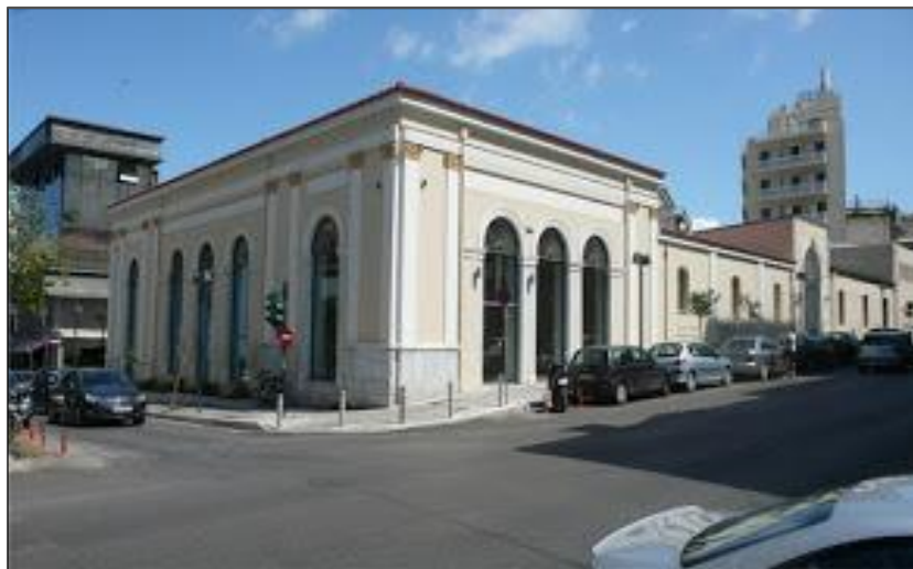
Εικόνα 3.23 Το κτίριο της Αγοράς Αργύρη.
