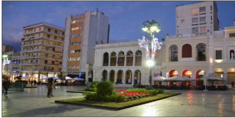
Εικόνα 3.62 Το κτίριο του Θεάτρου Απόλλων στην πλατεία Γεωργίου της Πάτρας.
