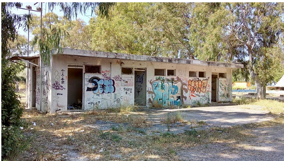
Εικόνα 16. Άλλη όψη κτιρίου, WC
