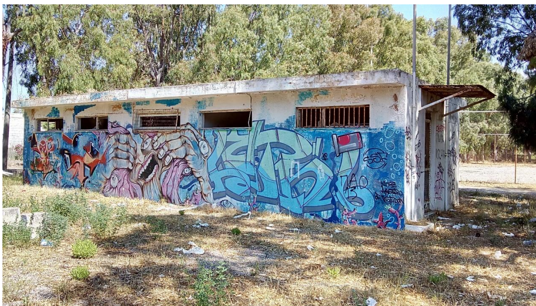
Εικόνα 15. Πίσω όψη κτιρίου, WC
