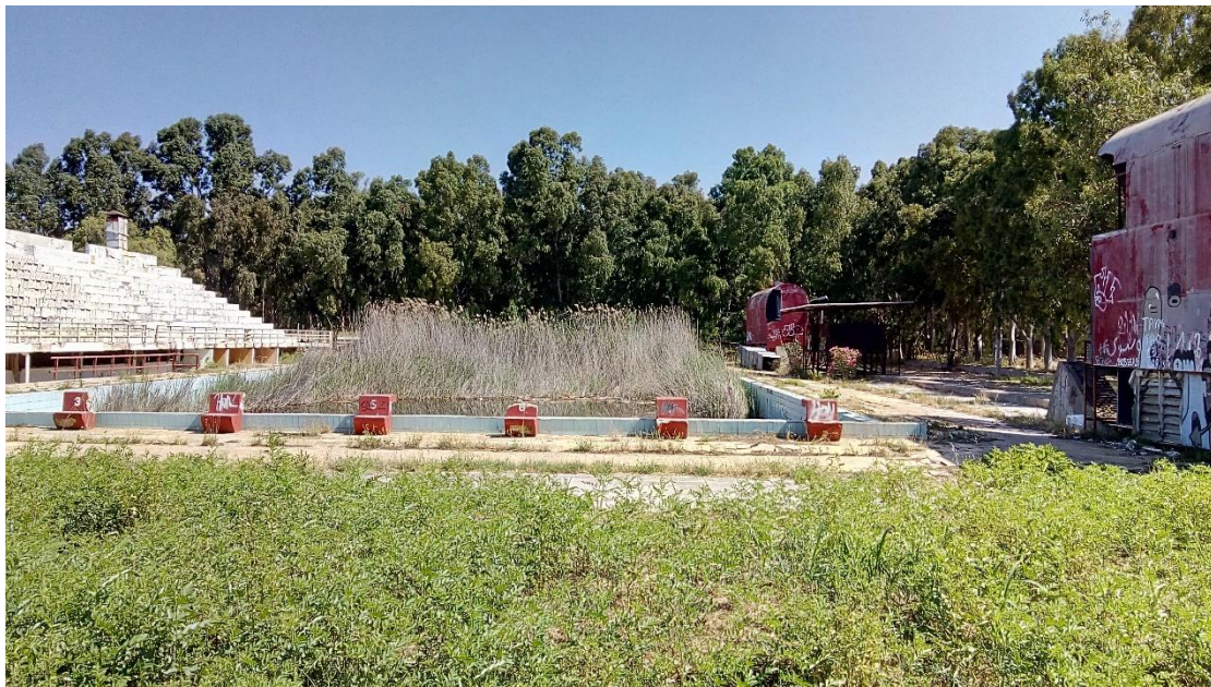
Εικόνα 4. Όψη πισίνας κολυμβητηρίου.
