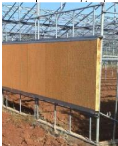
Σχήμα 5.3: Τοποθέτηση πάνελ κατά την κατασκευή του θερμοκηπίου
