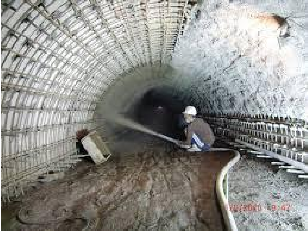
Σχήμα 1.5 Εκτόξευση σκυροδέματος σε σήραγγα [6]
