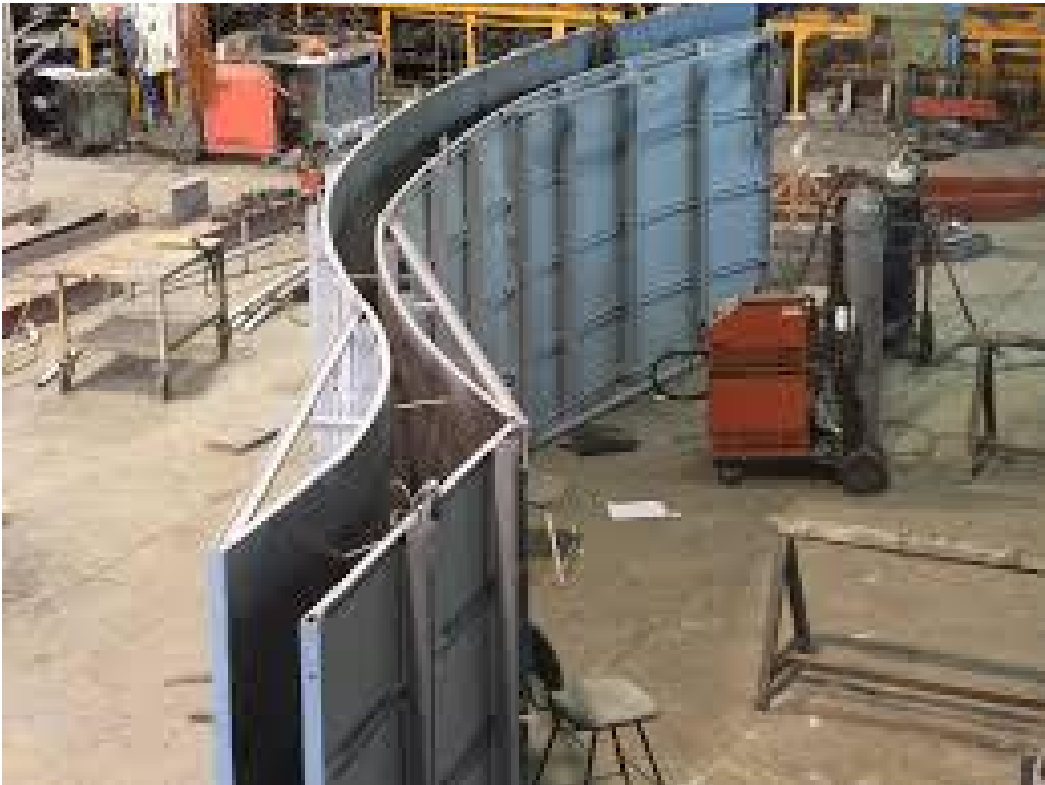
Σχήμα 1.3 Παράδειγμα σχημάτων και διαμορφώσεων σκυροδέματος που λαμβάνουν χώρα στο εργοτάξιο [4].
