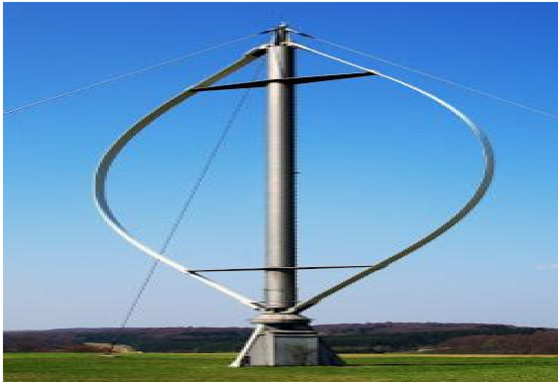
Εικόνα 3.3.1.3 Μεγάλου μεγέθους Α/Γ Darrieus(6)
