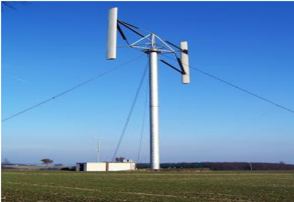
Εικόνα 3.3.1.2 Μεγάλου μεγέθους Α/Γ Darrieus(5)
