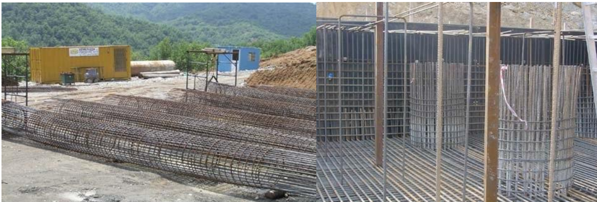
γ) Κλωβοί οπλισμών πασσάλων
