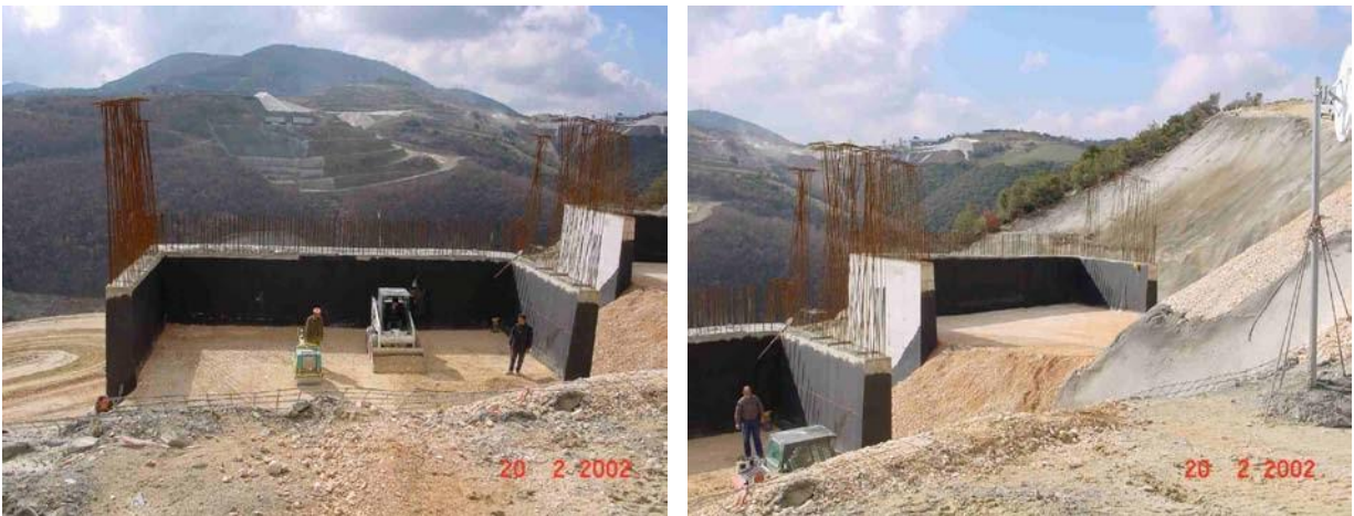
Σχήμα 1.17 Κατασκευή μεταβατικού επιχώματος ακροβάθρων [4].
