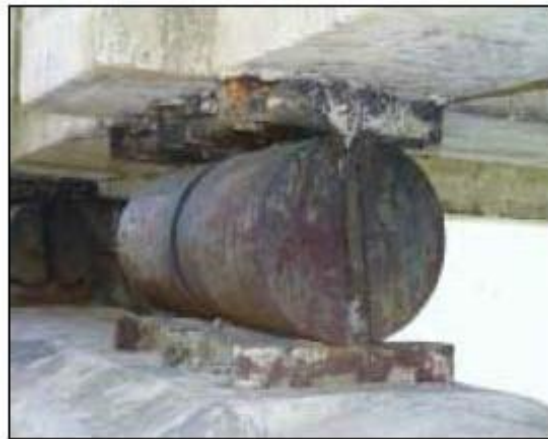
Σχήμα 1.23 Κυλιόμενα εφέδρανα [5].
