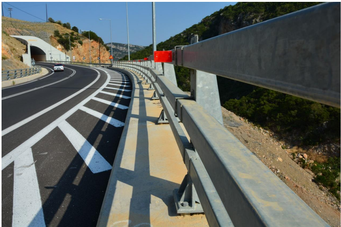
ΦΩΤ. 5.17 : Κιγκλιδώματα ασφαλείας της γέφυρας Γ1.
