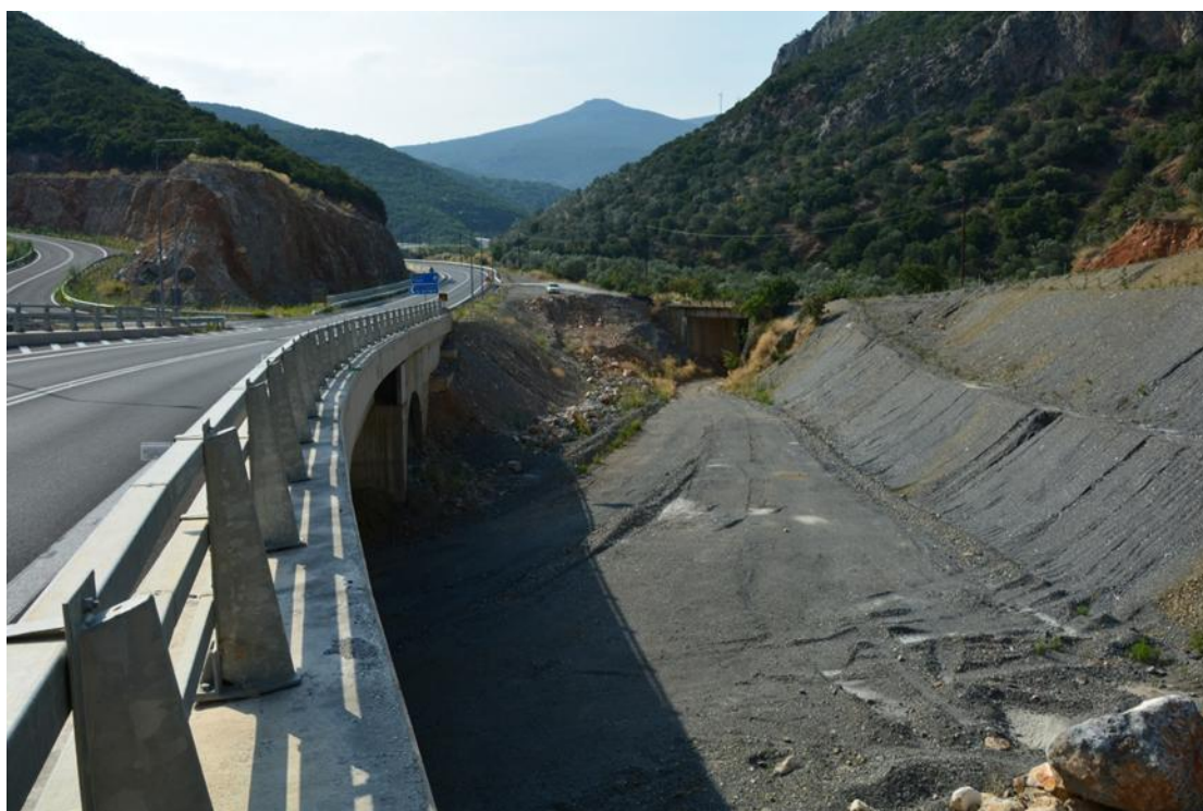
ΦΩΤ. 5.23 : Νότια όψη της γέφυρας Γ1 μεταξύ των μεσόβαθρων M2 και M1, με κατεύθυνση από το M2 προς το M1, στην οποία διακρίνονται τα κιγκλιδώματα, ο τοίχος αντιστήριξης, ο χείμαρρος Τάνος καθώς επίσης μπορεί να γίνει ορατή στο βάθος η γέφυρα του παλιού δρόμου Τριπόλεως – Άστρους.
