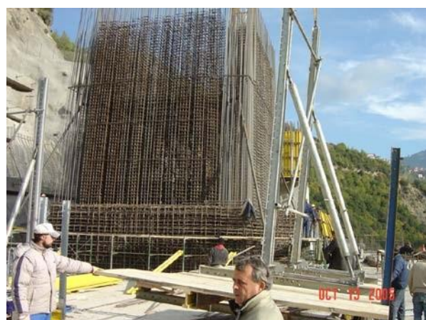
Οπλισμός κεφαλόδεσμου - βάσης μεσοβάθρου
