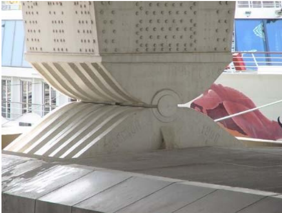
Σχήμα 1.22 Αρθρωτά εφέδρανα [5].
