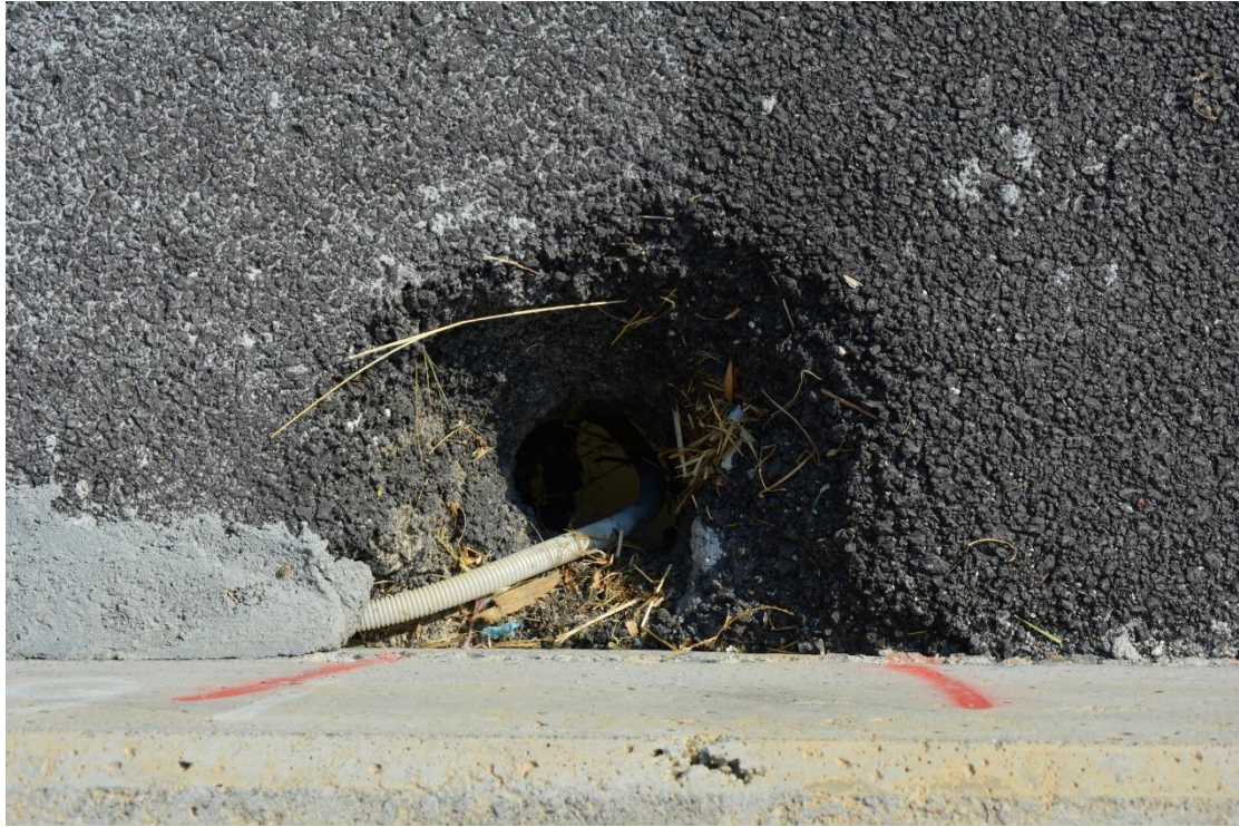
ΦΩΤ. 5.20 : Θέση αγωγού παροχέτευσης όμβριων υδάτων.
