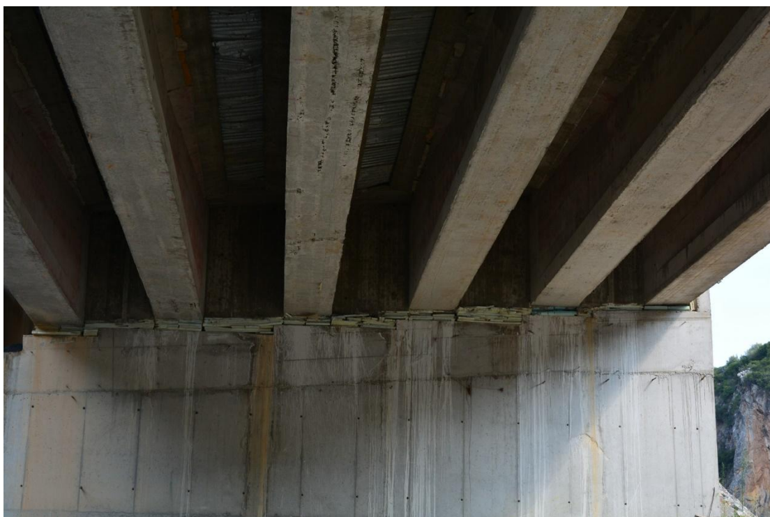
ΦΩΤ. 5.5 : Βόρεια όψη του μεσόβαθρου M2, διακρίνεται η θέση τοποθέτησης των ελαστομεταλλικών εφεδράνων πριν την αφαίρεση των υποστηριγμάτων.
