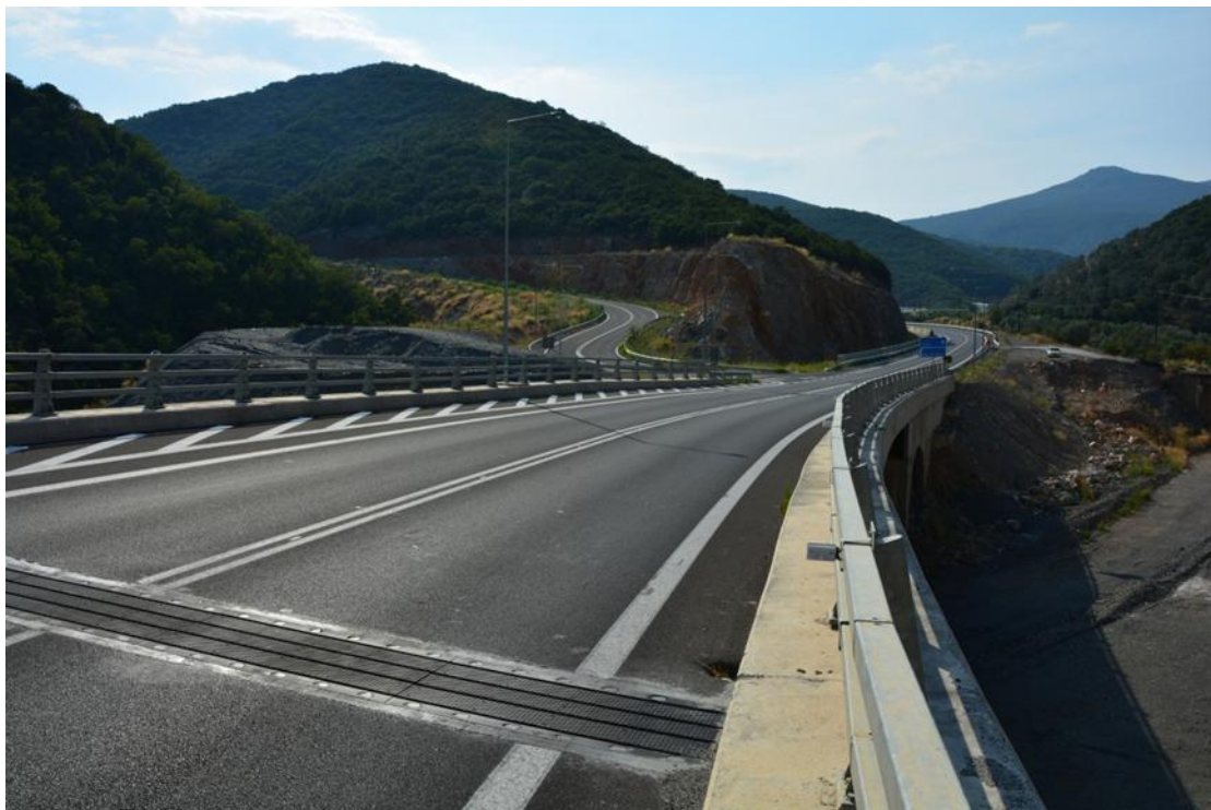
ΦΩΤ. 5.15 : Η γέφυρα Γ1 με κατεύθυνση από το μεσόβαθρο Μ2 προς το μεσόβαθρο Μ1.
