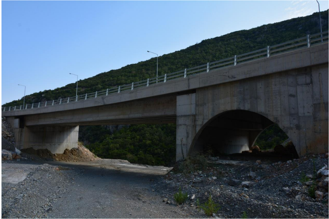
ΦΩΤ. 5.2 : Νοτιοδυτική όψη της παρούσης γέφυρας Γ1, διακρίνονται από αριστερά προς τα δεξιά τα μεσόβαθρα της γέφυρας Μ2 και Μ1 και τμήμα του ακροβάθρου Α1.
