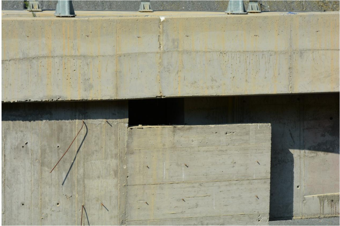
ΦΩΤ. 5.8 : Θέση τοποθέτησης εφεδράνων και αρμός μεταξύ του ακρόβαθρου A1 και του μεσόβαθρου M1.
