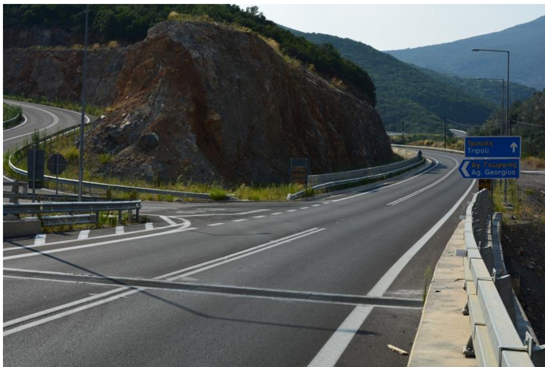
ΦΩΤ. 5.18 : Νότιο τμήμα της γέφυρας Γ1 στο οποίο διακρίνονται ο αρμός μεταξύ του ακρόβαθρου Α1 και του μεσόβαθρου Μ1 και ο δρόμος ο οποίος βρίσκεται στην αρχή του ακρόβαθρου Α1.
