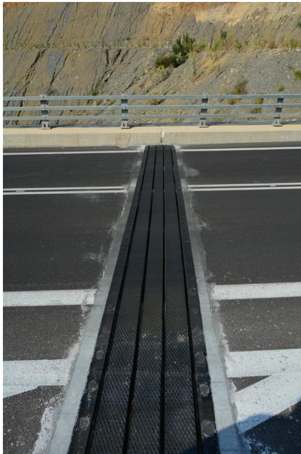
ΦΩΤ. 5.14 : Μεταλλικά καλύμματα του διαχωριστικού αρμού μεταξύ των ακρόβαθρου Α2 και μεσόβαθρου Μ2.
