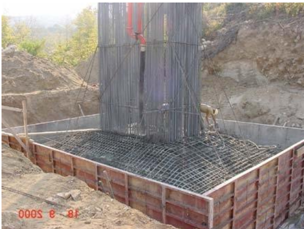
α) Επιφανειακή θεμελίωση
