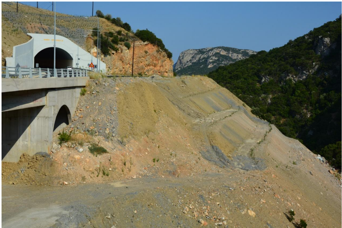
ΦΩΤ. 5.9 : Βορειοανατολική όψη του ακρόβαθρου A1, διακρίνεται και ο τοίχος αντιστήριξης.
