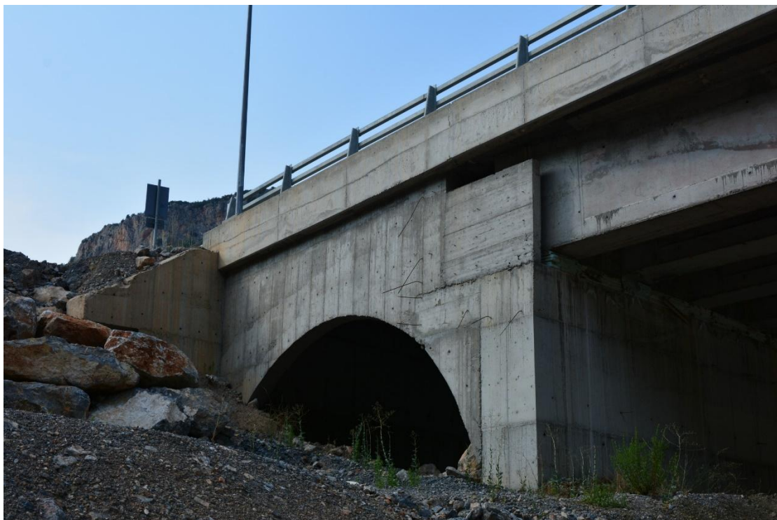
ΦΩΤ. 5.7 : Νοτιοανατολική όψη του ακρόβαθρου A1 όπου διακρίνεται το μεσόβαθρο M1 και η θέση τοποθέτησης των ελαστομεταλλικών εφεδράνων.
