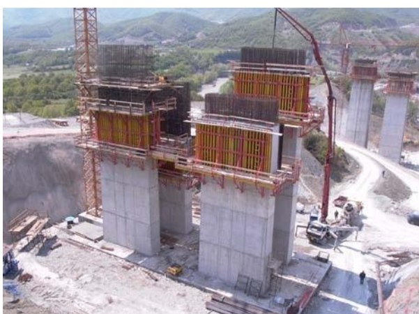
Κατασκευή μεσοβάθρου μορφής δίδυμων λεπίδων
