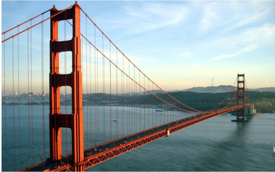
Σχήμα 1.8 Η κρεμαστή Γέφυρα Golden Gate του Σαν Φρανσίσκο [18xiv].
