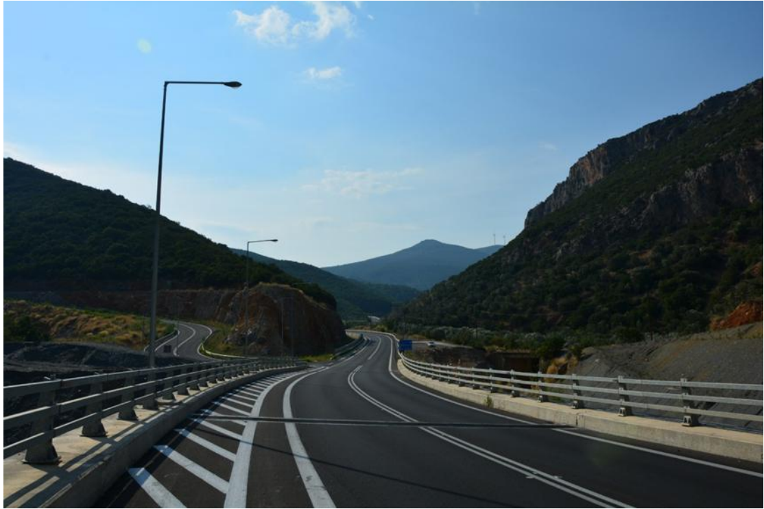
ΦΩΤ. 5.16 : Γενική άποψη του καταστρώματος της παρούσας γέφυρας Γ1.
