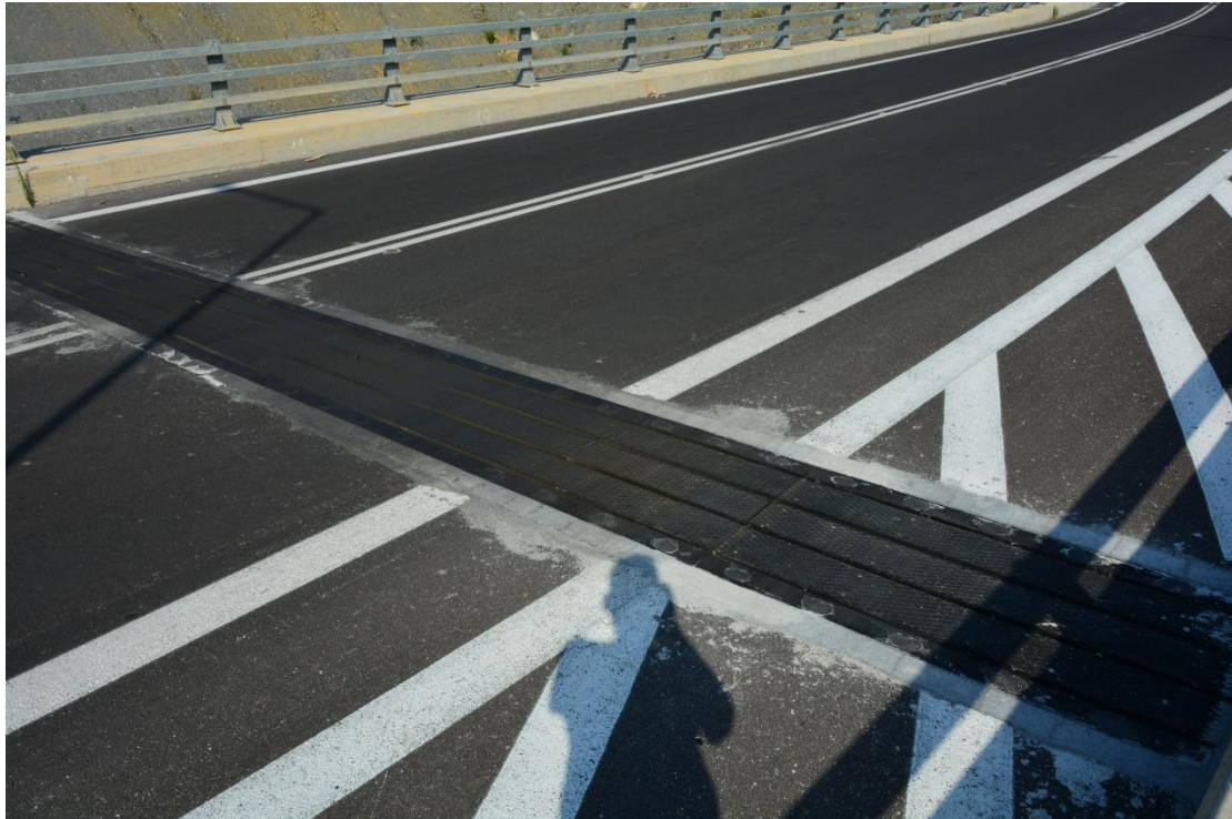
ΦΩΤ. 5.13 : Μεταλλικά καλύμματα του διαχωριστικού αρμού μεταξύ των ακρόβαθρου Α1 και μεσόβαθρου Μ1.
