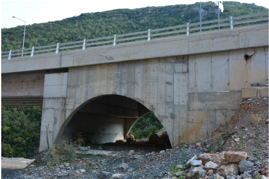
ΦΩΤ. 5.3 : Νοτιοδυτική όψη του ακροβάθρου Α1 στα δεξιά, επίσης διακρίνεται και το μεσόβαθρο Μ1 στα αριστερά.
