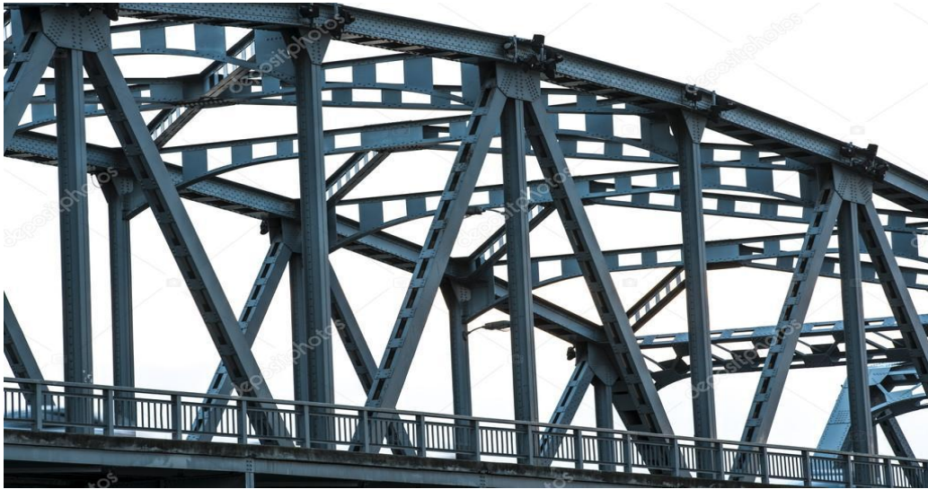
Σχήμα 1.4 Χάλυβα δομή υποστήριξης πάνω από γέφυρα [18iv].
