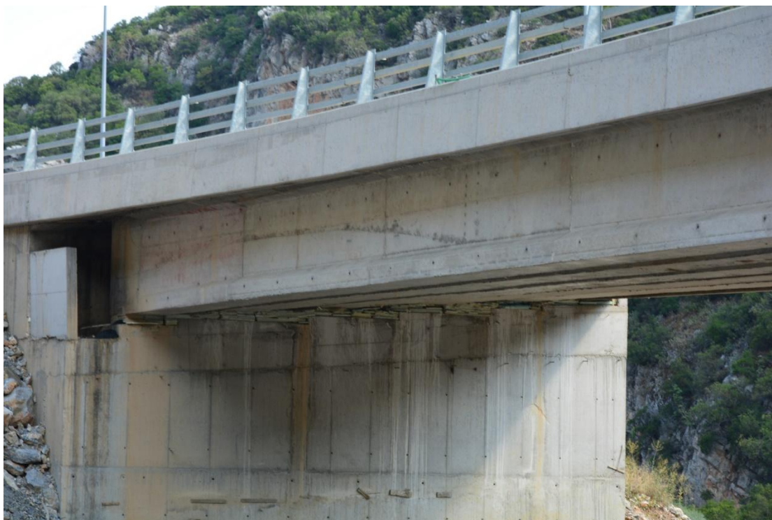
ΦΩΤ. 5.4 : Βορειοδυτική όψη του μεσόβαθρου M2, διακρίνεται η θέση τοποθέτησης των ελαστομεταλλικών εφεδράνων πριν την αφαίρεση των υποστηριγμάτων.
