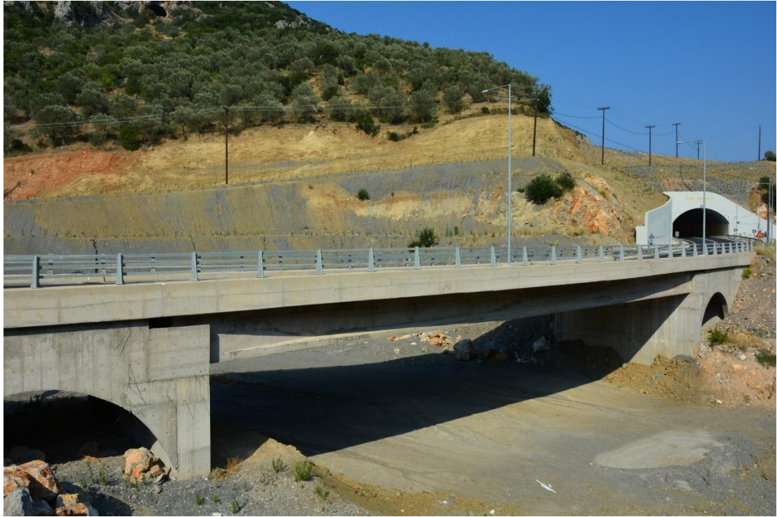
ΦΩΤ. 5.10 : Νοτιοανατολική όψη της γέφυρας Γ1 όπου διακρίνονται το μεσόβαθρο M1, το μεσόβαθρο M2 και το ακρόβαθρο A2.
