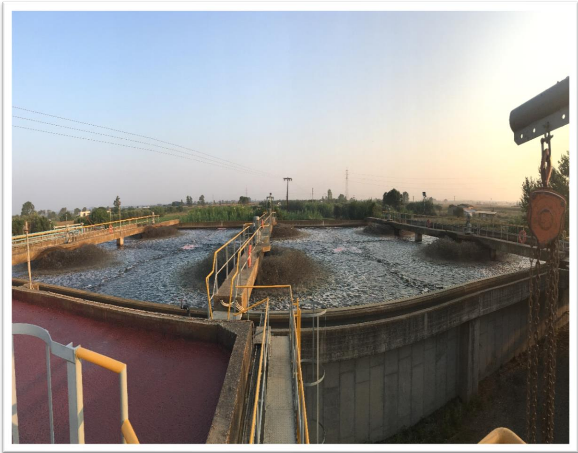
Εικόνα 20: Δεξαμενή αερισμού
