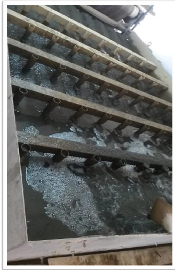
Εικόνα 22: Μηχανικός παχυντής
